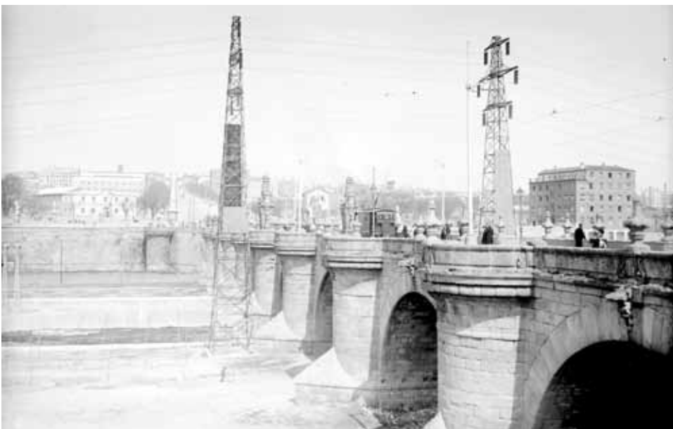
Fig. 3. Anónimo, Vista del puente de Toledo, 1934. Fotografía.
