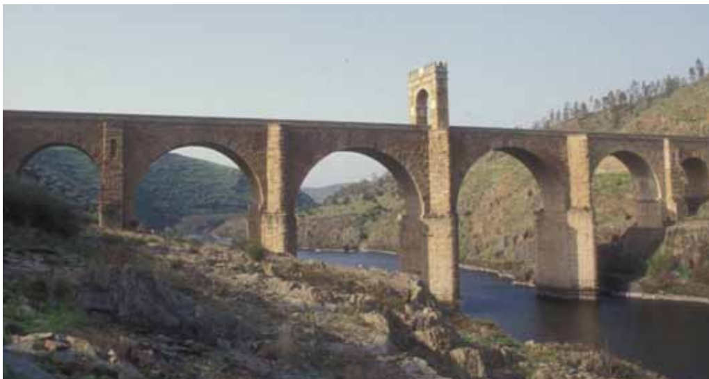
Puente de Alcántara sobre el río Tajo, en Cáceres
