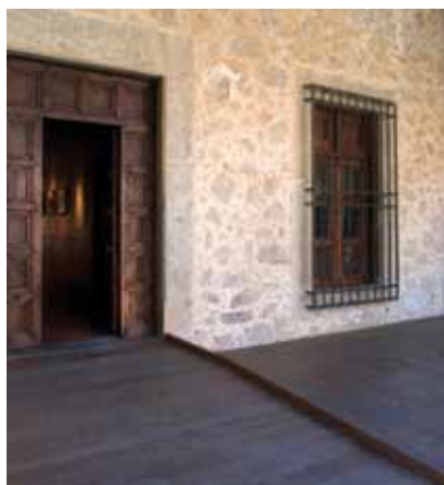
Entrada al Palacio del Emperador
