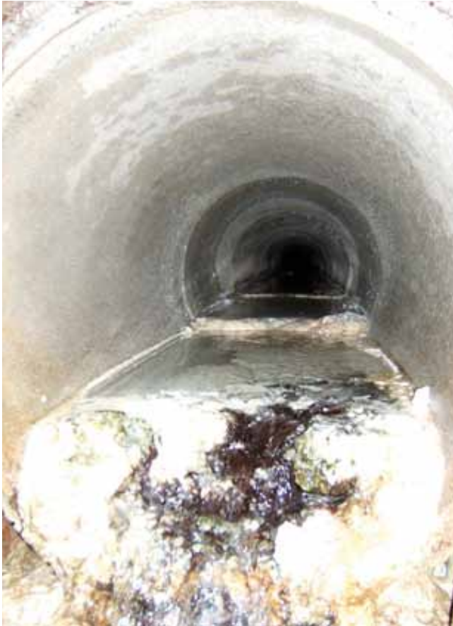
Fig. 3. Obstrucción en las canalizaciones del túnel
