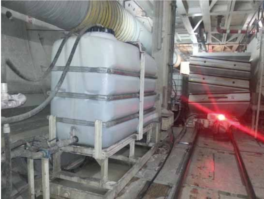
Fig. 7. Depósito del com. B en el back-up
