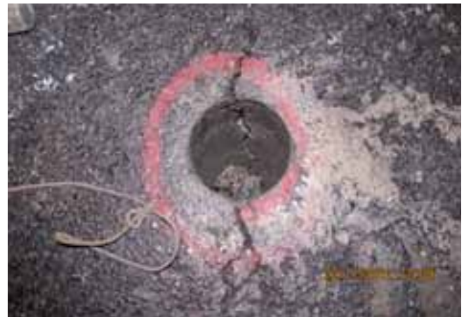
Fig. 10. Imágenes de la zona de extracción de los diferentes testigos
