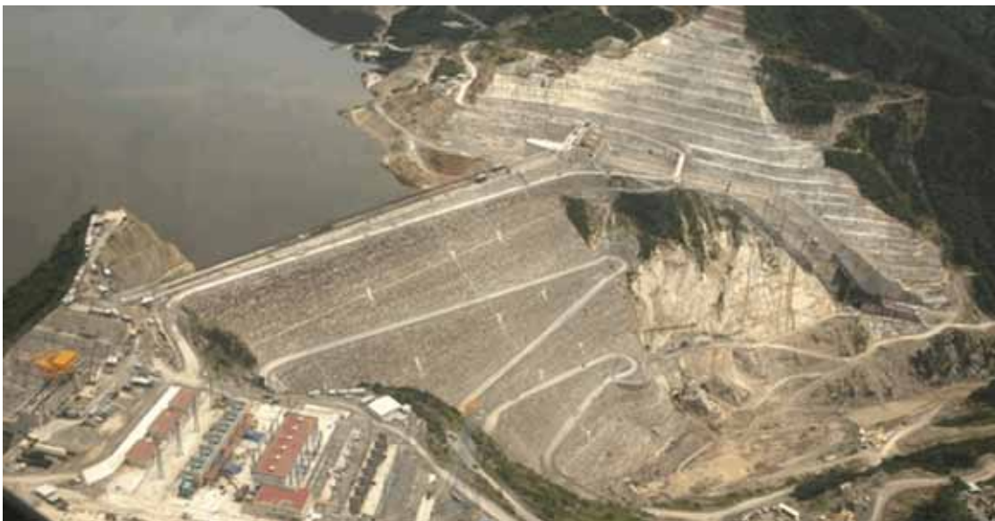
Fig. 2. La presa de La Yesca en septiembre de 2013 (CNN)
