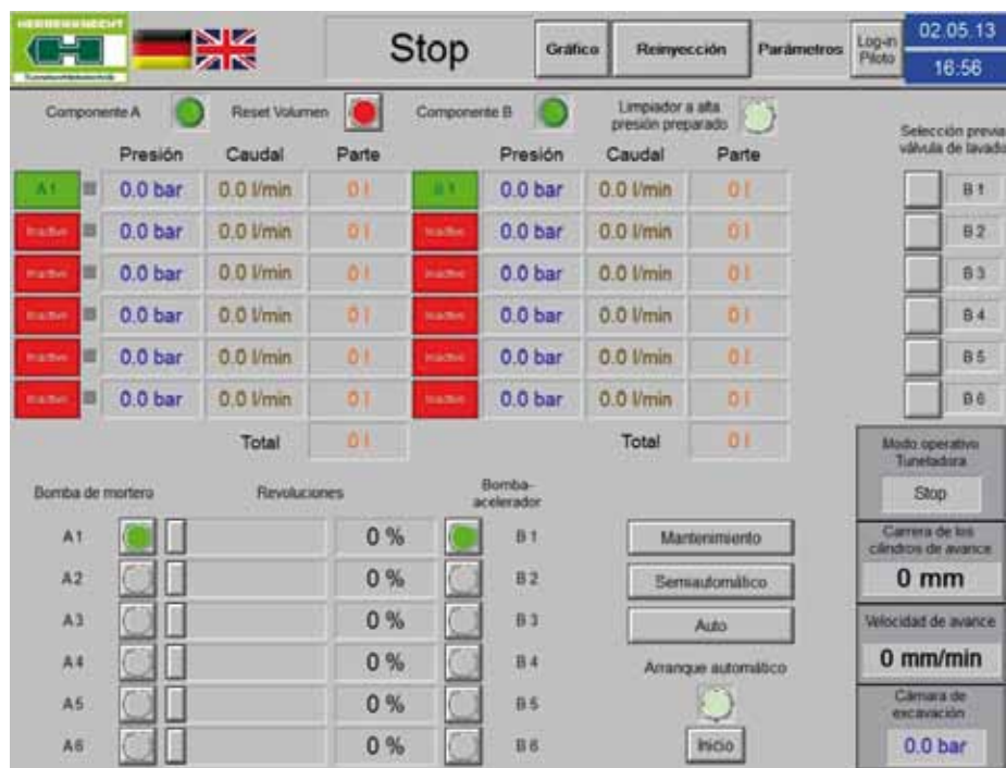
Fig. 11. Pantalla del Operador del Sistema
