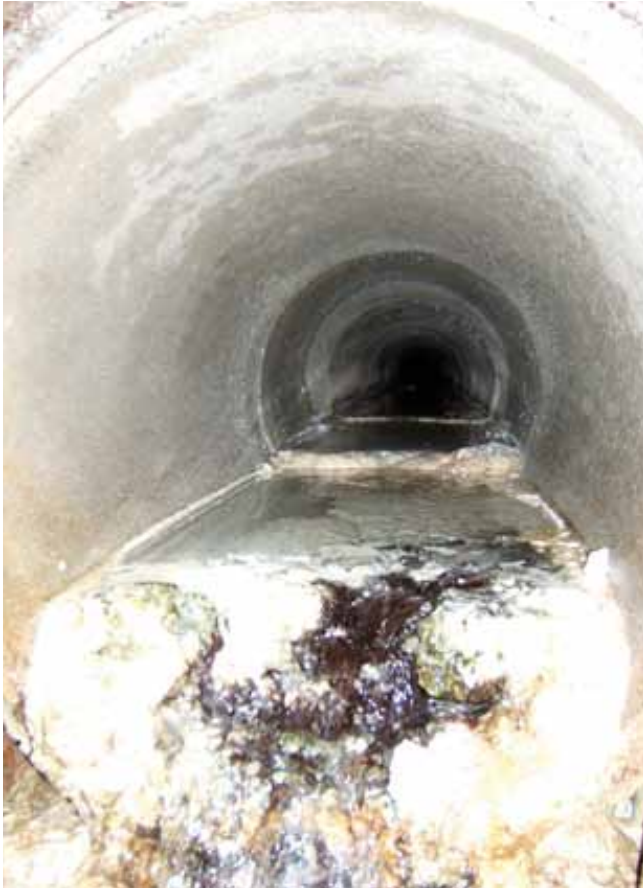
Fig. 3. Obstrucción en las canalizaciones del túnel
