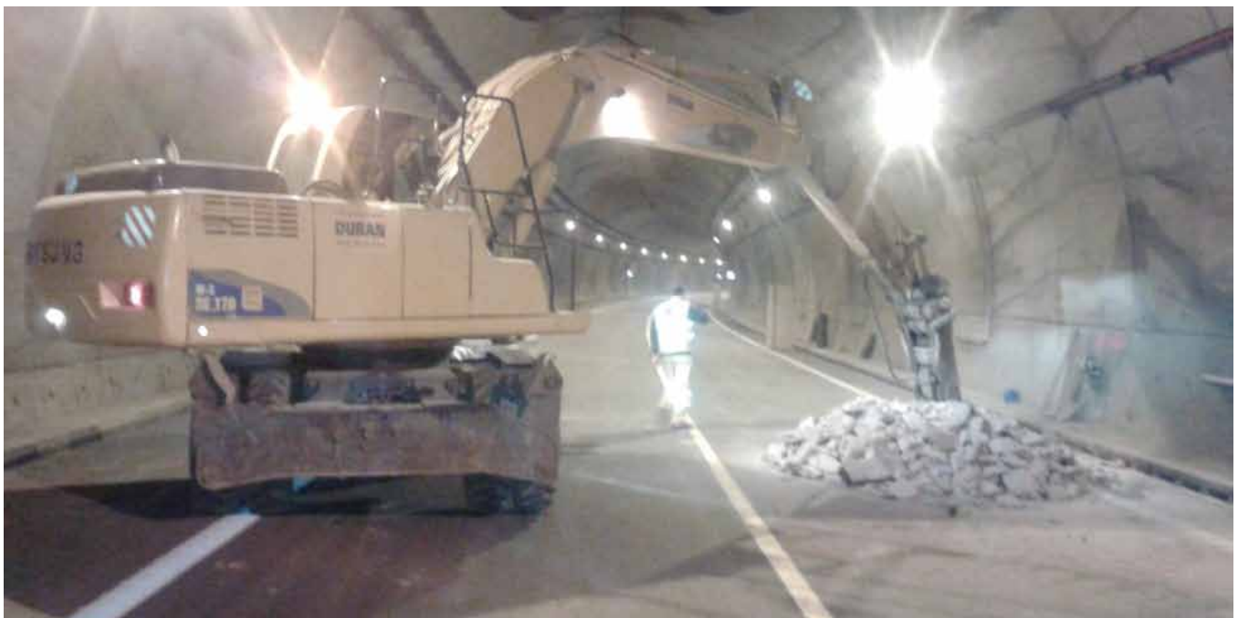
Fig. 19. Localización arqueta tubo B
