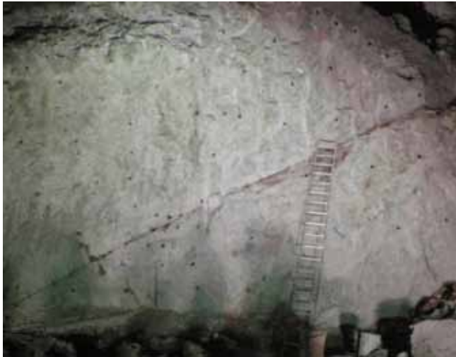
Fig. 7. Afloramiento de la falla en el frente del túnel
