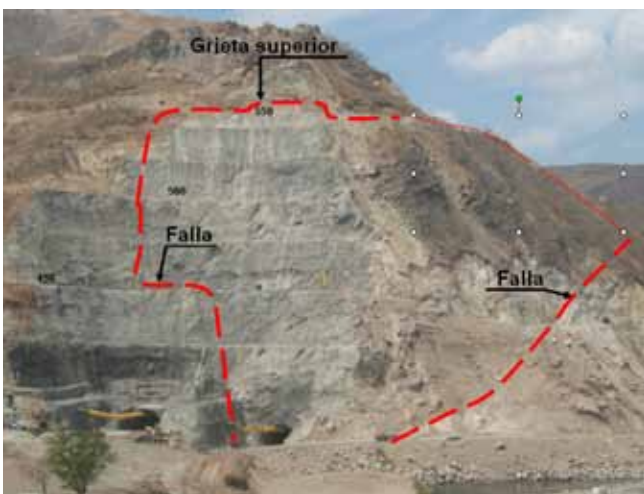
Fig. 5. Vista frontal de los túneles y esquema del deslizamiento
