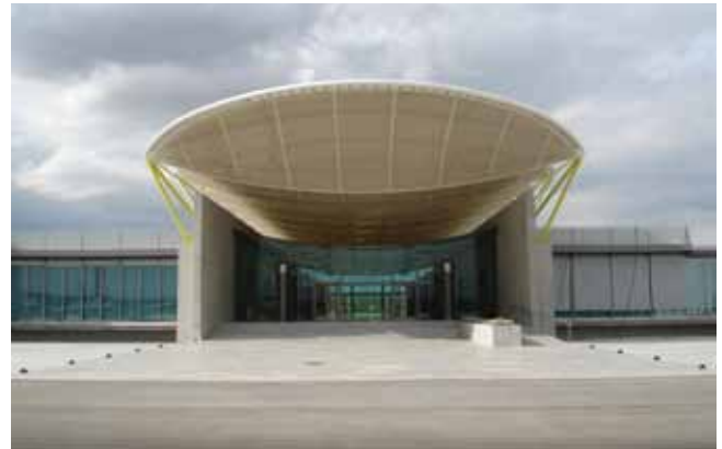
Fig. 4. Vista del Pabellón de Estado desde el área de maniobras
