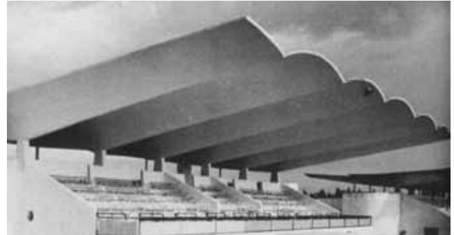
Fig. 4. Cubierta del Hipódromo de la Zarzuela
