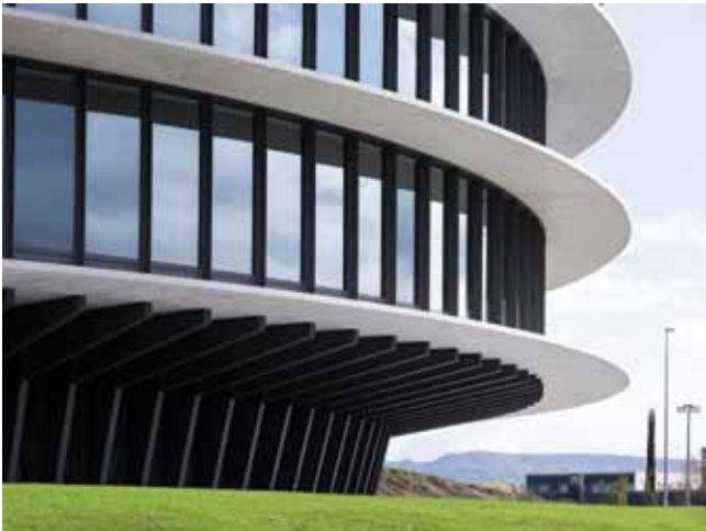
Diseño de estructura del edificio Gamesa eólica, la estructura es la imagen del edificio y resuelve la fachada, la carpintería, el remate del falso techo y del suelo técnico
