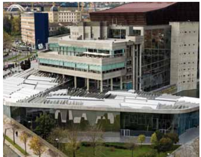
Vista de la cubierta de la ampliación
