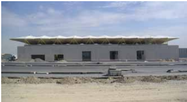
Fig. 3. Vista de la estructura de la membrana
