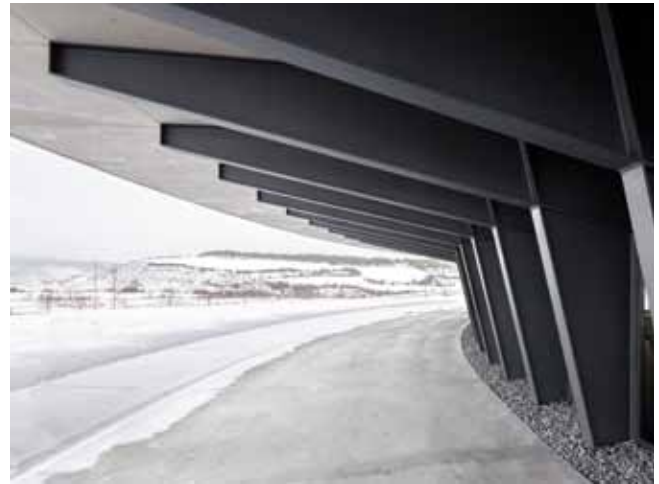
Diseño de estructura del edificio Gamesa eólica, la estructura es la imagen del edificio y resuelve la fachada, la carpintería, el remate del falso techo y del suelo técnico
