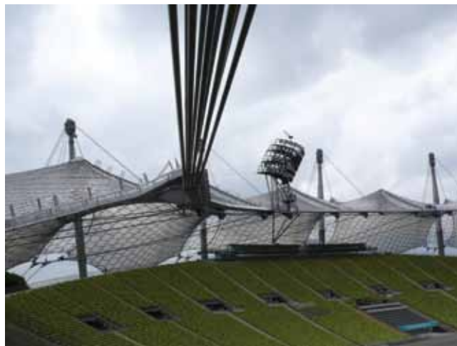
Fig. 2. Cubierta del estadio olímpico de Múnich. Foto: C. Nárdiz
