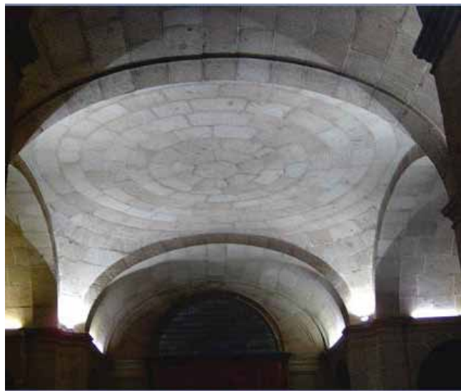
Fig. 2. Monasterio de El Escorial. Bóveda plana de la Basílica. 1563-1584
