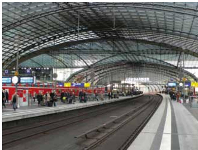
Fig. 3. Cubierta de la Estación Central de Berlín. Foto: C. Nárdiz
