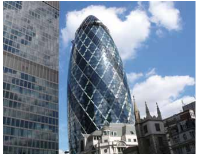
Fig. 6. La Torre Swiss Re, en Londres. Foto: C. Nárdiz
