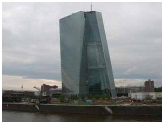
Fig. 13. Torre del European Center Bank, en Fráncfort. Foto: C. Nárdiz
