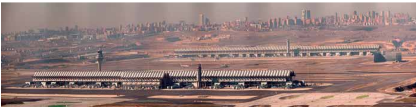
Fig. 6. T4 de Madrid. Edificio terminal y satélite
