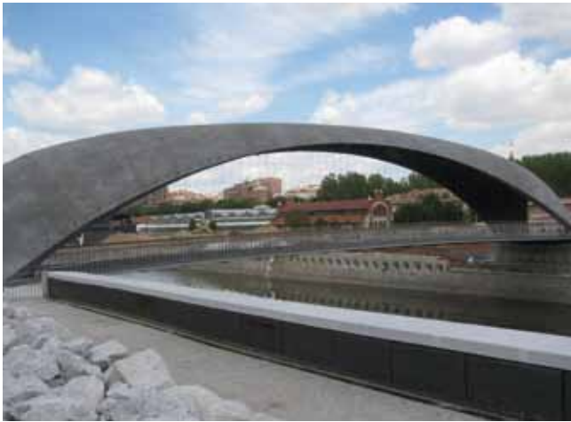
Fig. 9. Pasarela Cáscara en la zona de Matadero. M-Río. Madrid.
