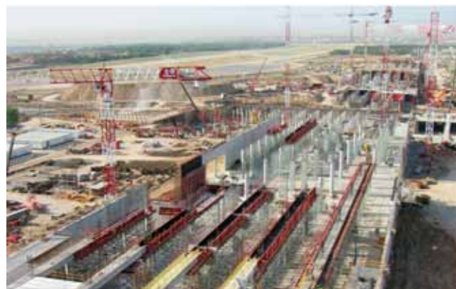
Fig. 7. Construcción de la T4. Vigas longitudinales de los pórticos de 18,00 m de vano con cimbra autolanzable
