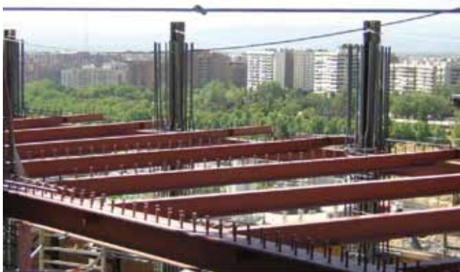
Fig. 11. Disposición de vigas y viguetas
