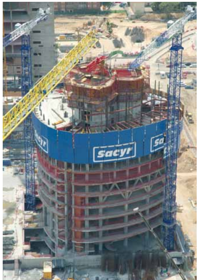
Fig. 15. Vista general del proceso constructivo y del concepto estructural global
