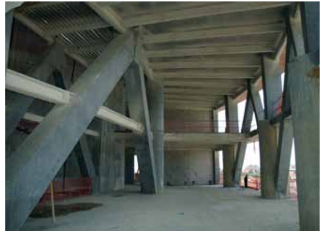
Fig. 6. Bielas de descarga de los soportes interrumpidos en planta 6ª
