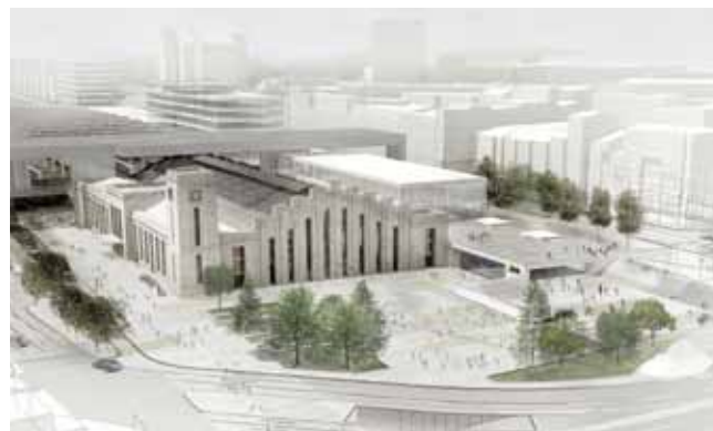
Fig. 8. El vestíbulo transversal es también una nueva comunicación urbana entra ambas calles que se evidencia por un gran pieza superior, a modo de grapa o transición, entre la marquesina histórica y la nueva cubierta
