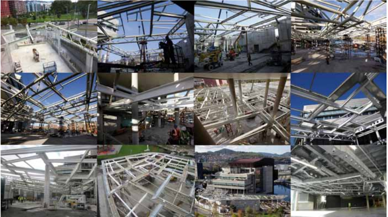
Fig. 4. Imágenes del proceso de montaje de la estructura recíproca de cubierta
