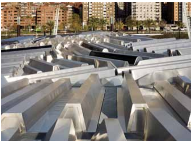
Las tejas metálicas de cubierta
