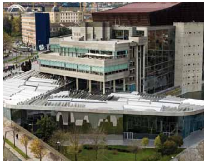
Vista de la cubierta de la ampliación
