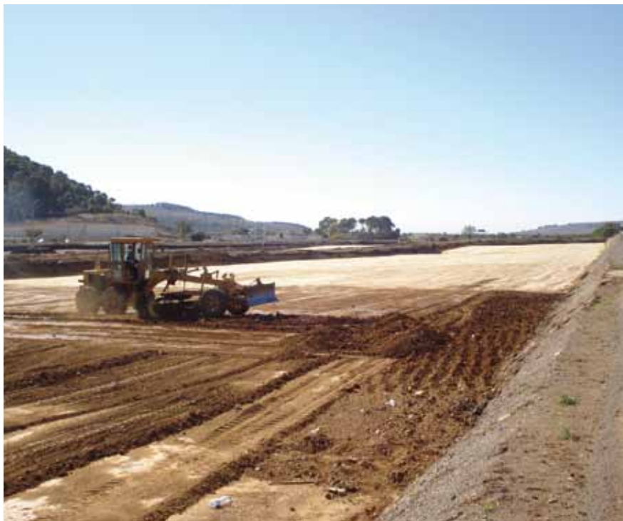
Obras en la autopista este-oeste (Sener)
