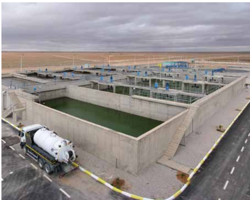
Depuradora en Mecheria (Comsa Emte)
