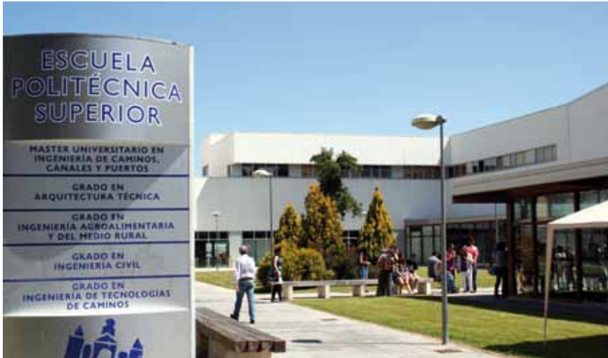
Vista exterior del edificio
