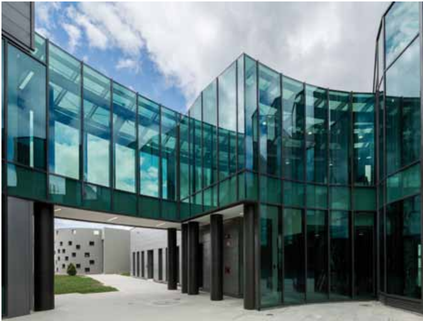
Fachada del edificio de gestión y control
