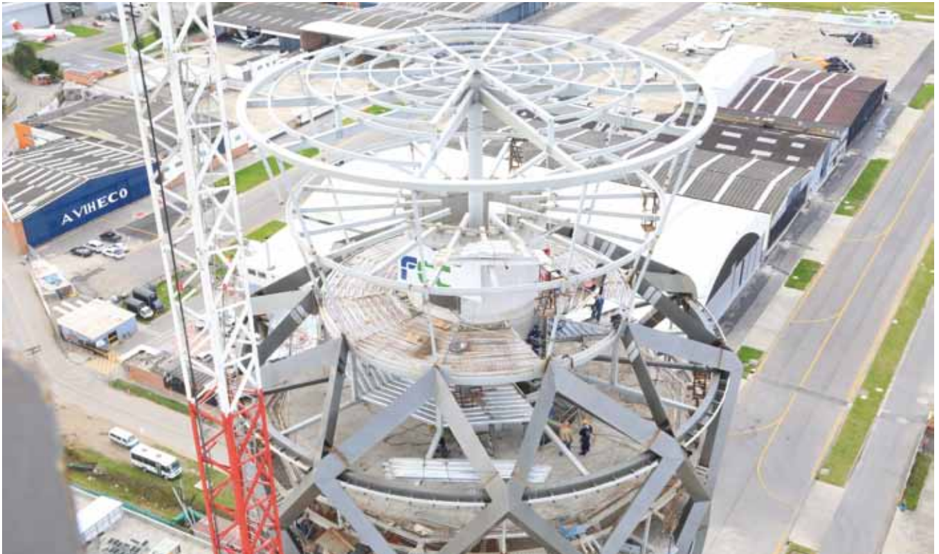
Construcción de la estructura de la torre
