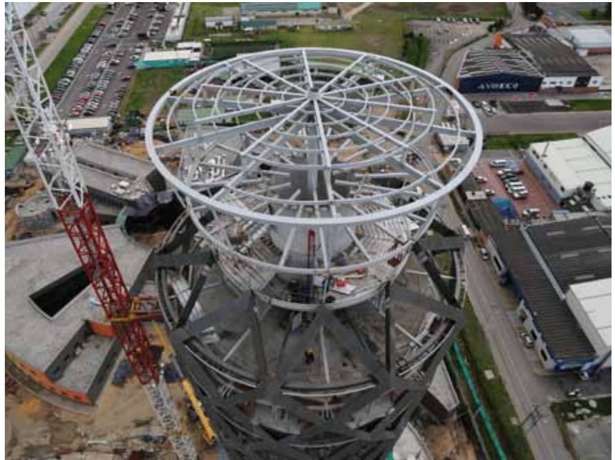
Torre en construcción. Estructura helicoidal
