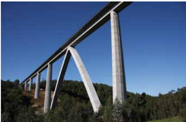
Fig. 28. Viaducto sobre el río Deza
