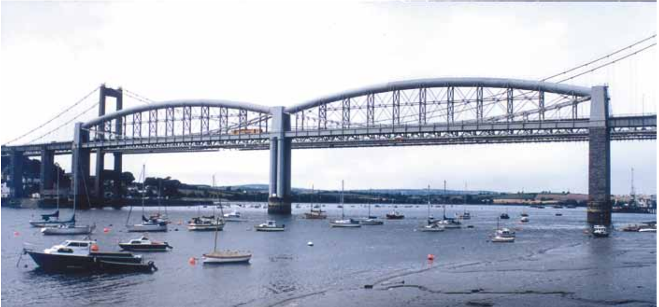
Fig. 5. Puente Royal Albert sobre el río Tamar en Saltash (Inglaterra). Luz 132 m. 1859. I. Brunel
