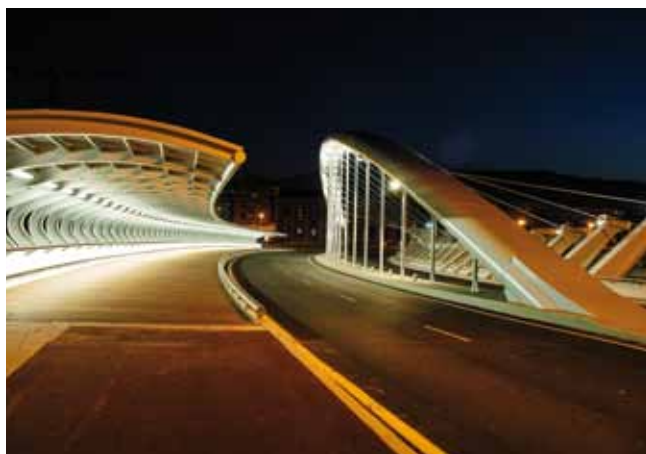
Fig. 34. Puente sobre el río Galindo
