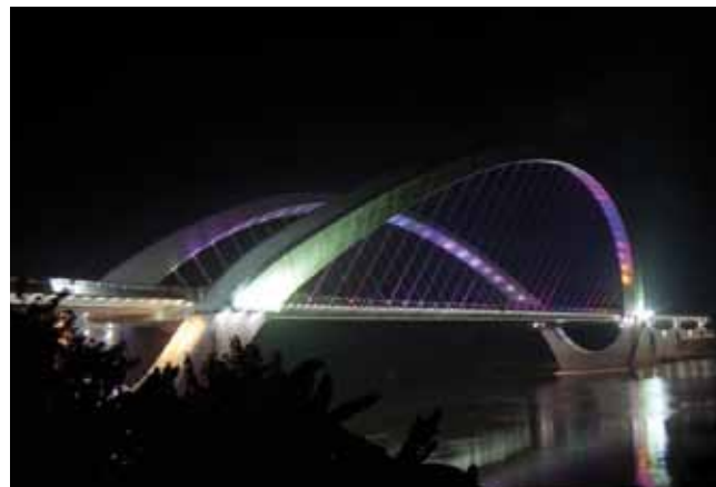
Fig. 29. Puente Nanning sobre el río Yong
