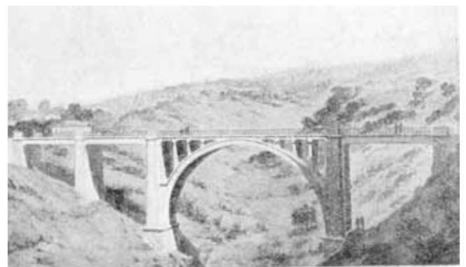
Fig. 14. Viaducto sobre Barranco Hondo
