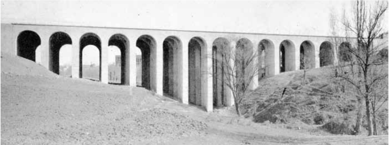
Fig. 44. Viaducto de los 15 Ojos
