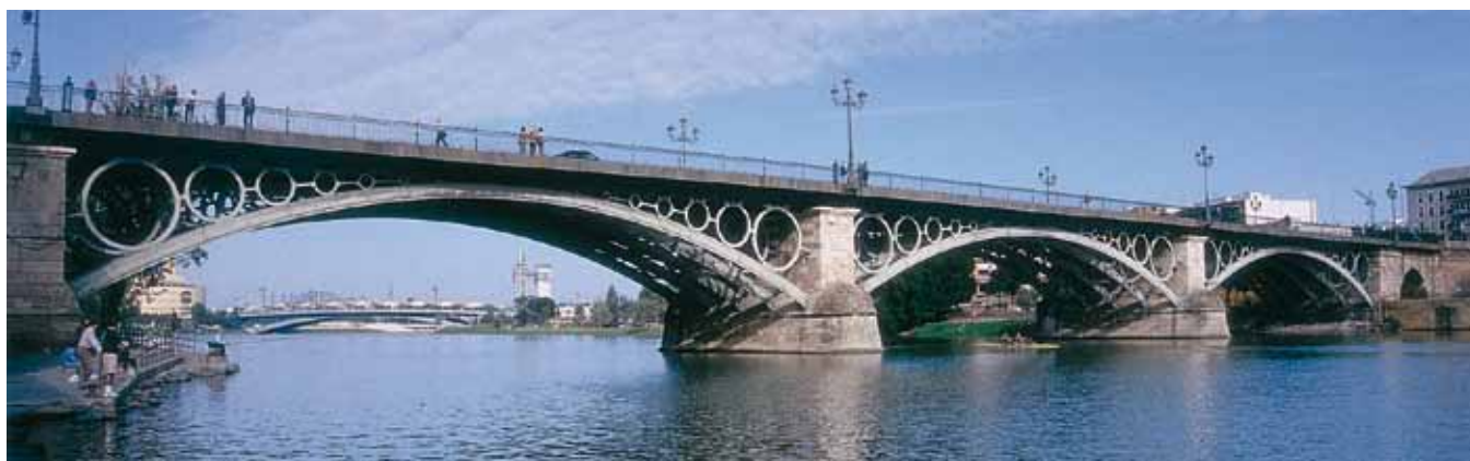
Fig. 4. Puente de Triana en Sevilla sobre el río Guadalquivir. Luz 46,5 m. 1845. G. Steinacher, F. Bernadet
