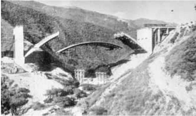
Fig. 2. Puente en la autopista Guayra (Venezuela)
