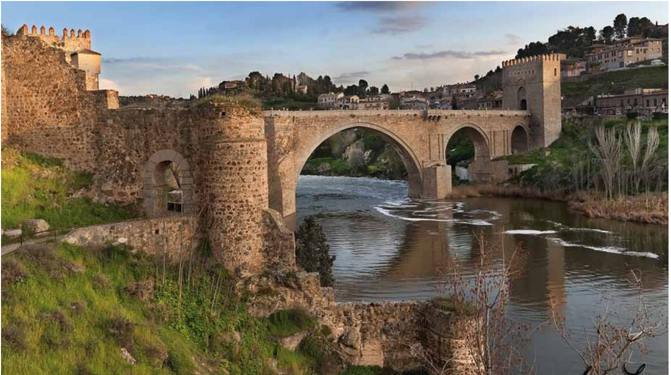
Fig. 2. Puente de San Martín, en Toledo. La luz del vano central es de 38 m y fue construido en el s. XIV
