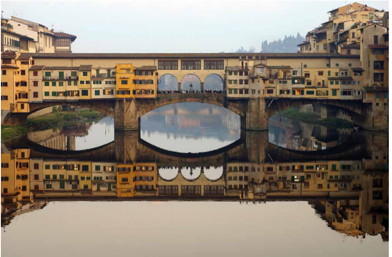
Fig. 3. Puente Vecchio. Bóvedas de 30 m de luz con un rebajamiento de 1/7
