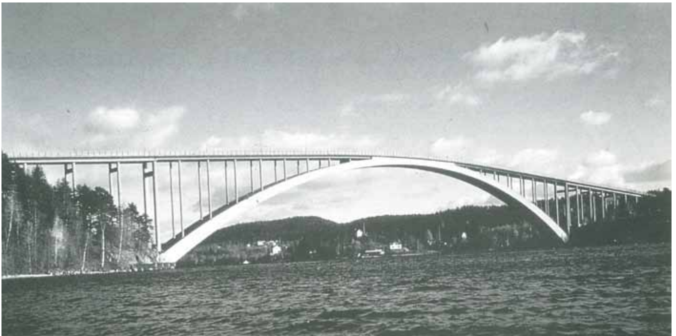
Fig. 50. Puente de Sandó
