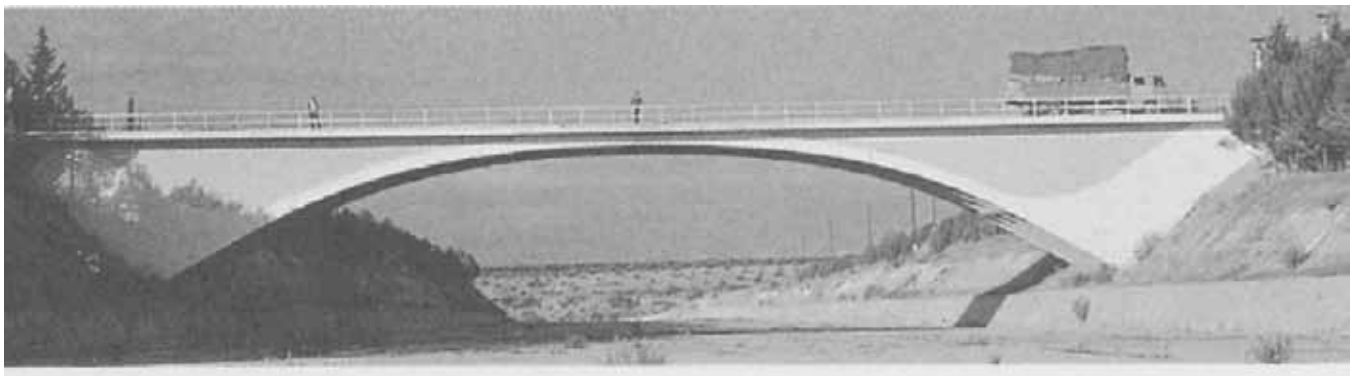
Fig. 42. Puente sobre el aliviadero de Cubillas
