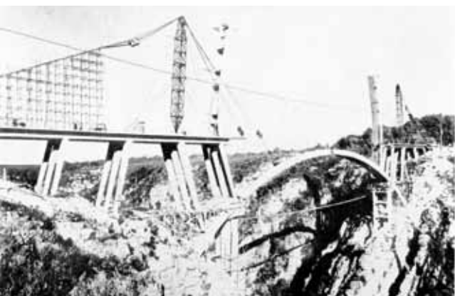
Fig. 8. Puente sobre el río Storms. Giro de los arcos principales
