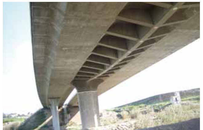
Fig. 41. Puente de Alcantarilla
