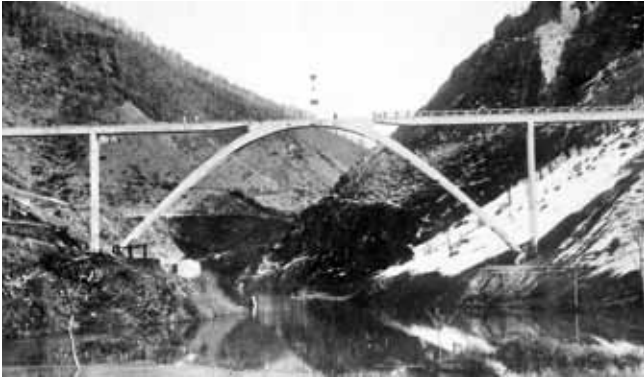
Fig. 5. Pasarela del torrente de Lussia
