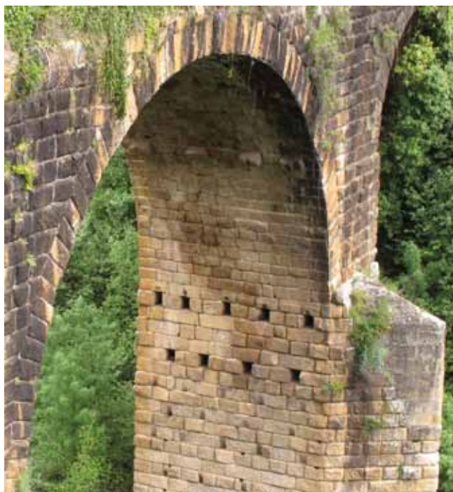
Figs. 17 y 18. Mechinales de apoyo de la cimbra y andamios, apoyos en forma de cuña para los jabalcones de apeo del tirante y sillares salientes en el intradós de la bóveda para arriostramiento lateral de las cerchas, del arco central de Ponte Bibei, Ourense (Foto y dibujo M. Durán)
