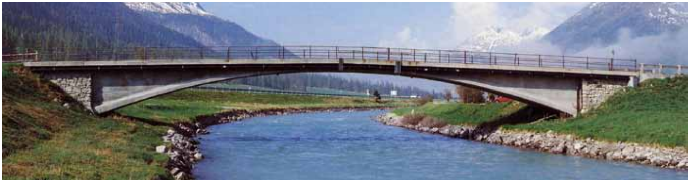
Fig. 26. Puente sobre el río Inn, en Zuoz
