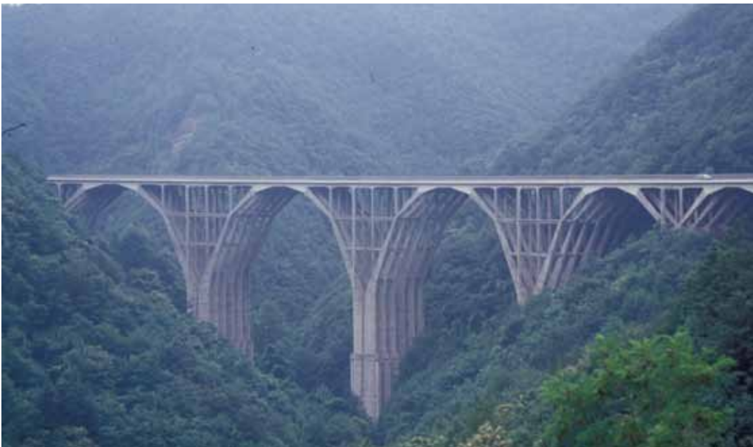
Fig. 24. Puente en la autopista de Bologna-Venecia
