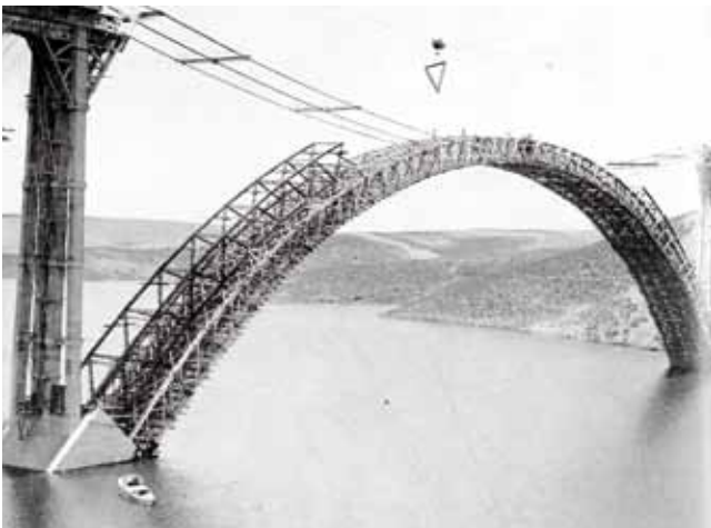
Fig. 46b. Construcción del arco de Martín Gil
