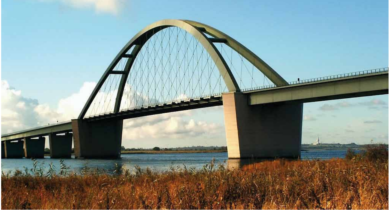
Fig. 14. Puente sobre el estrecho de Fehmarn
