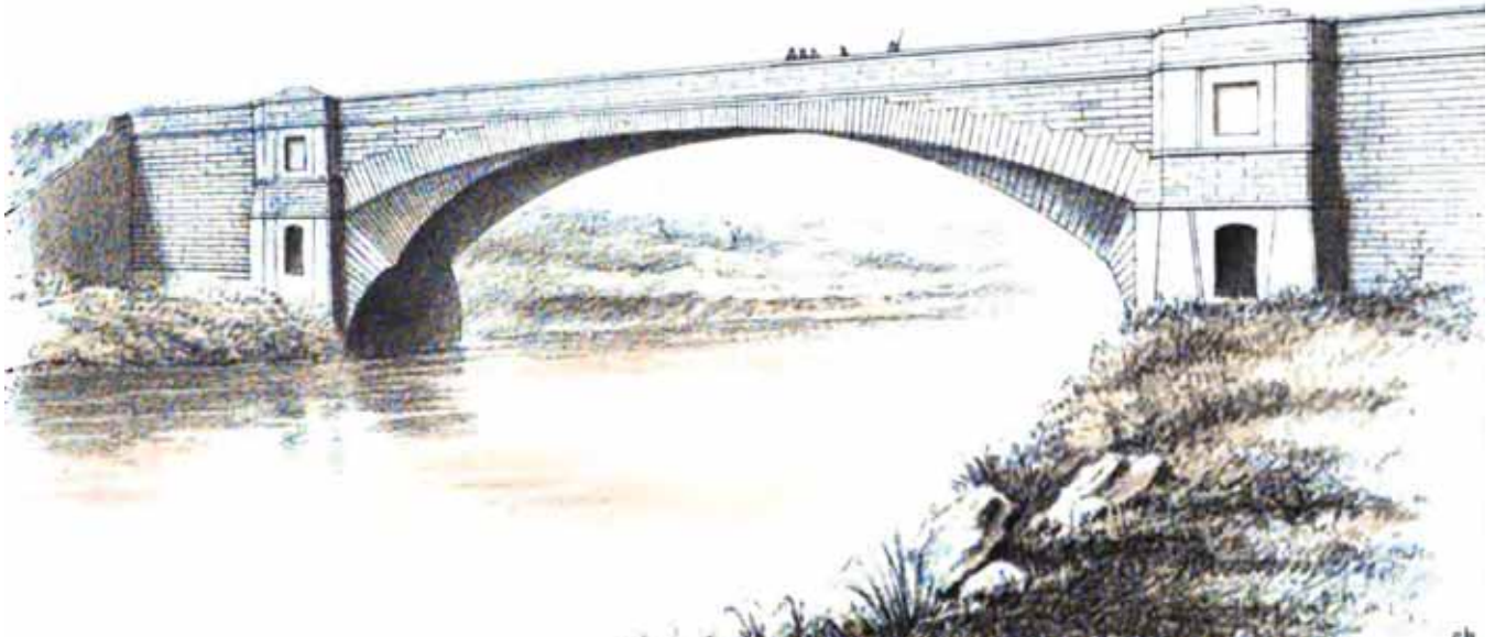
Fig. 7. Puente Over. Gloucester. T. Telford. 1827. Luz de 45,70 m
