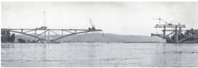
Fig. 47. Construcción del puente Rij
