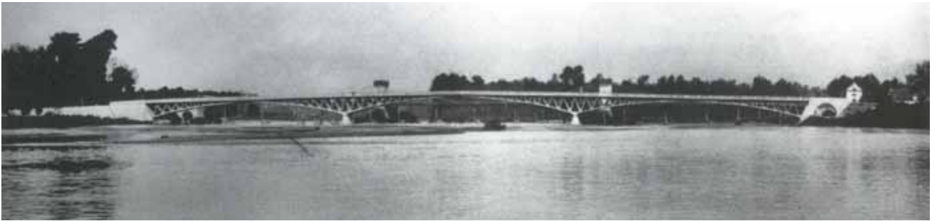
Fig. 31b. Puente de Veudre
