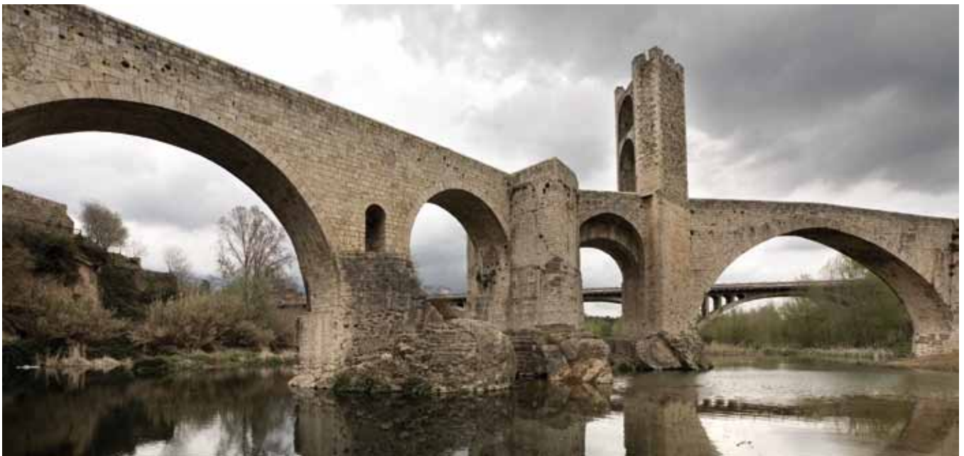
Fig. 1. Puente de Besalú, en Girona. Puente representativo junto con el de Frías en Burgos de los puentes fortaleza construidos en los s. XII y XIII. El arco central de menor luz denota la antigua presencia de un puente levadizo de madera
