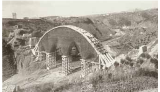
Fig. 4. Cimbra del puente de la Fiumarella
