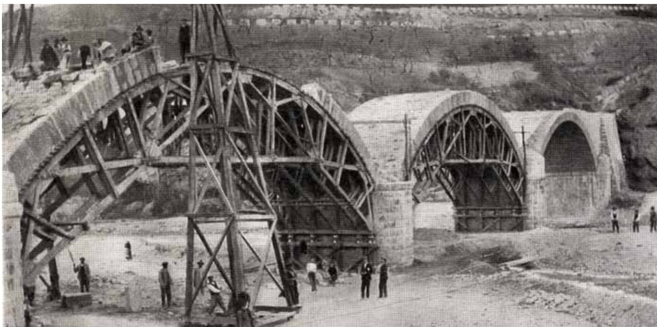
Fig. 9. Construcción de un puente carretero
