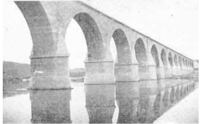
Fig. 2. Puente sobre el Tajo
