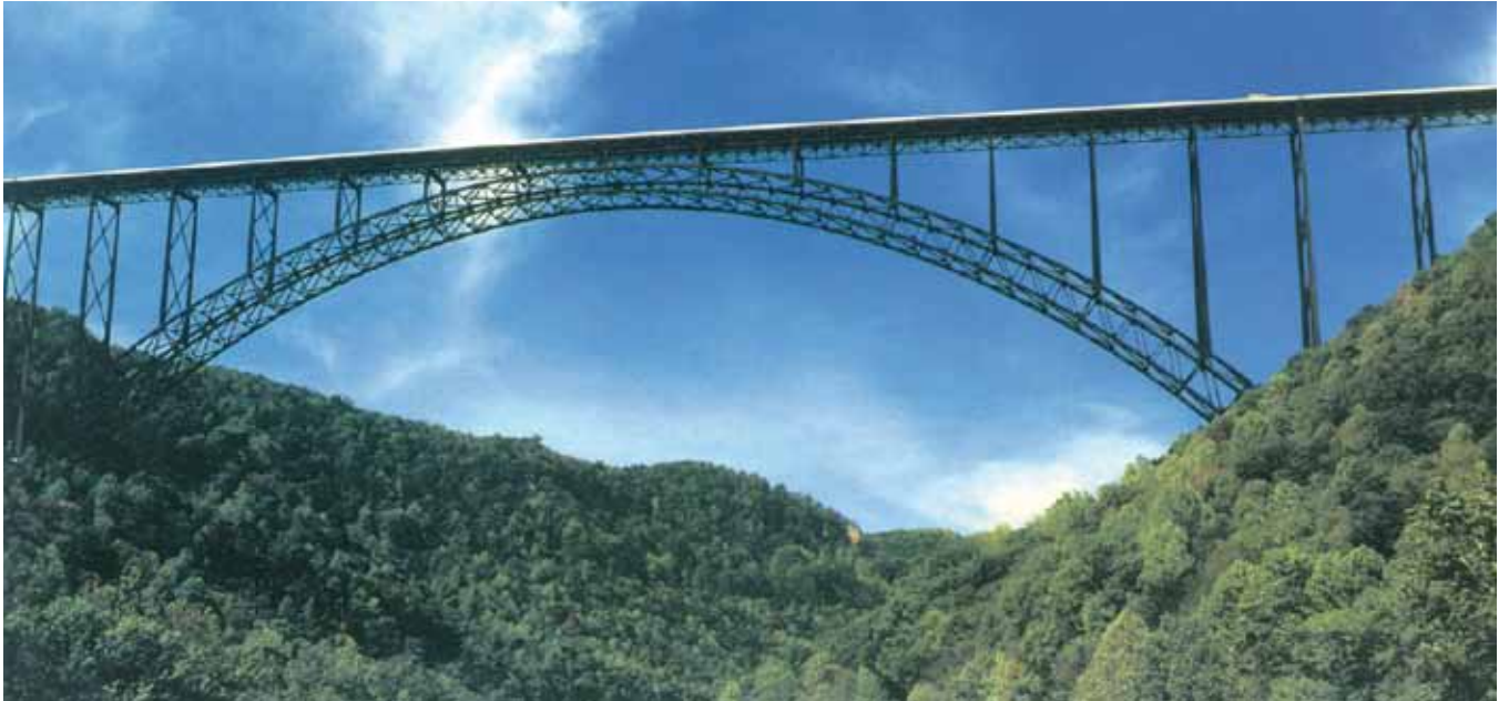
Fig. 16. Puente de la New River Gorge (Estados Unidos). Luz 518 m. 1976.
