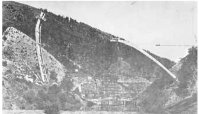
Fig. 6a. Giro y abatimiento del arco del torrente Lussia
