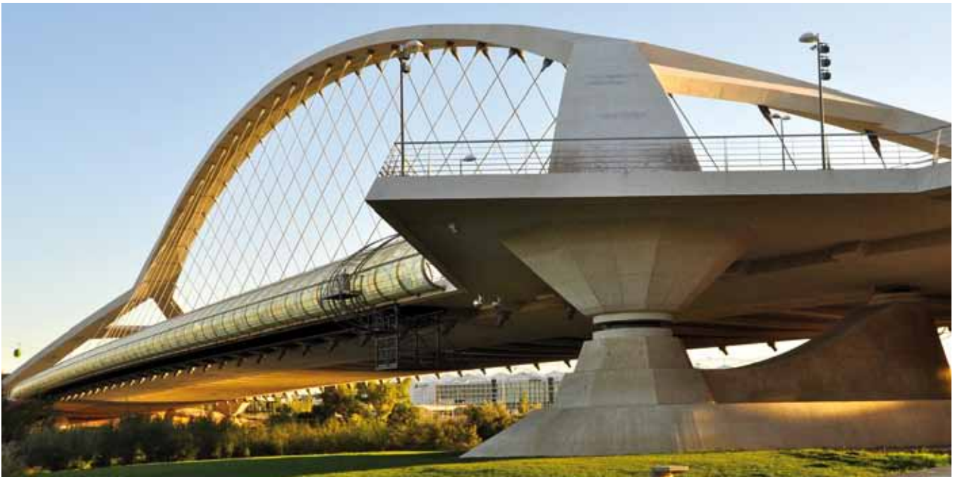
Fig. 44. Puente del Tercer Milenio
