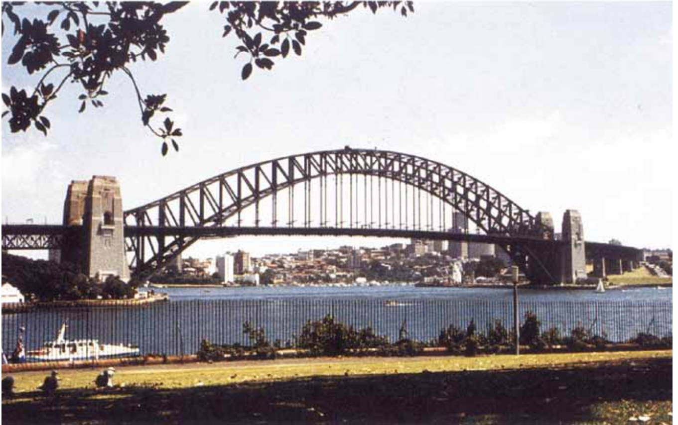
Fig. 14. Puente de Sydney (Australia). Luz 503 m. 1932. R. Freeman
