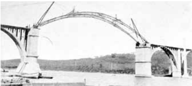
Fig. 48a. Puente del Pedrido y autocimbra
