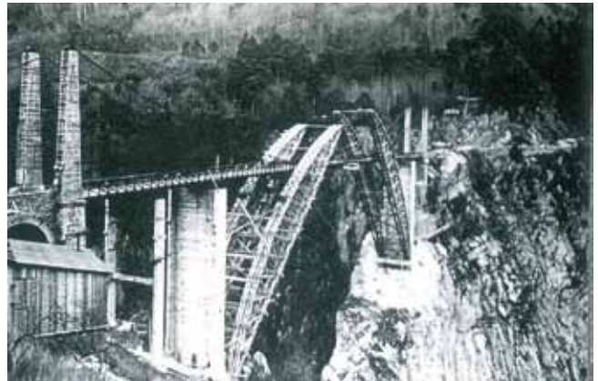
Fig. 6b. Giro de la cimbra de madera de un puente francés de ferrocarril
