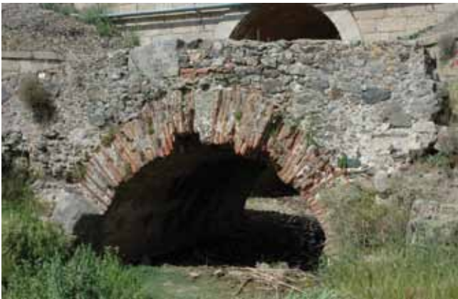
Fig. 15. Rosca interior de ladrillo de la bóveda y dovelas de piedra en la boquilla aguas abajo de la Alcantarilla de Mérida (Foto M. Durán)
