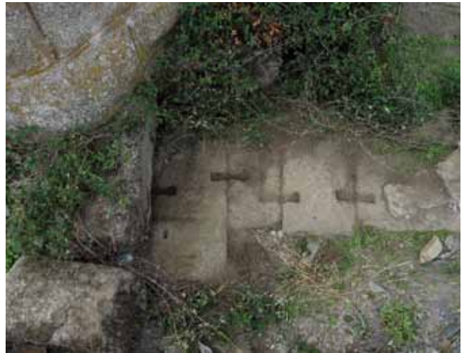
Fig. 20. Detalle de la losa de cimentación de la pila nº 2 del puente de Alcántara, con una línea de replanteo, muescas de palanca y mortajas de enlaces de doble cola de milano (Foto M. Durán)
