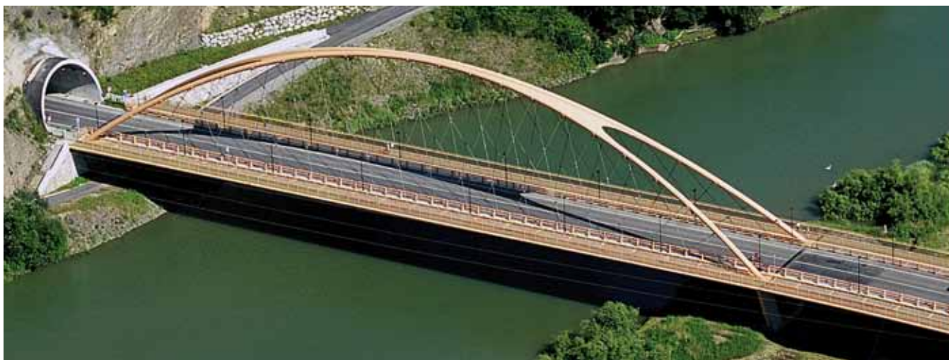
Fig. 16. Puente sobre el río Deba
