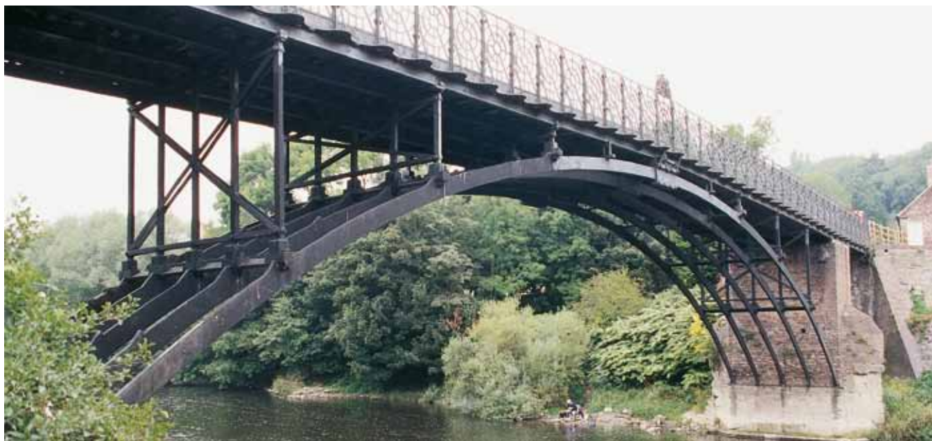
Fig. 3. Puente de Coalport. Luz 31 m. 1818
