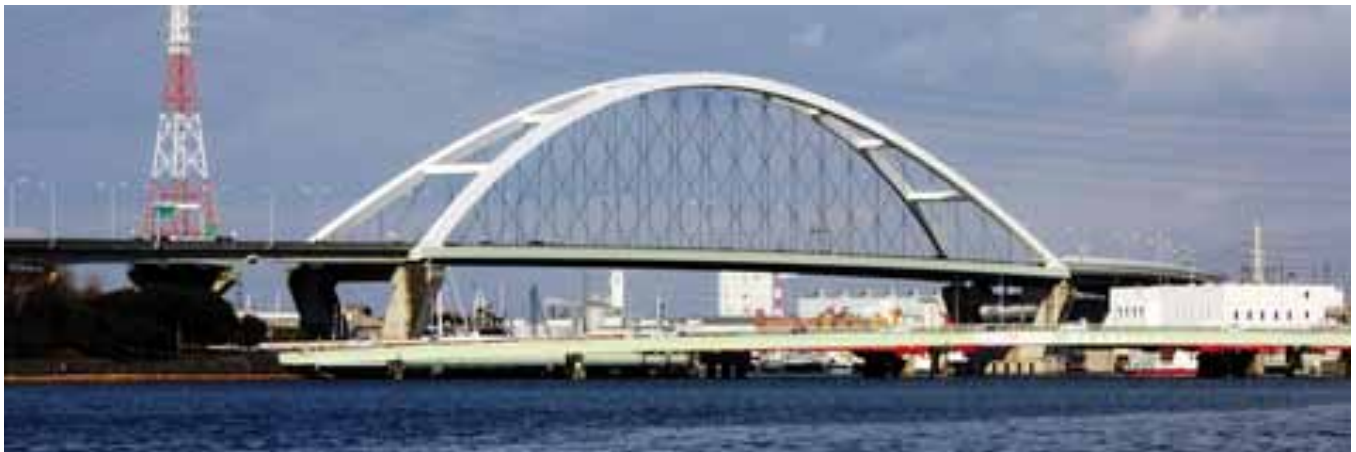
Fig. 15. Puente de Shin-Hamadera
