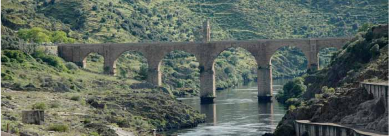
Fig. 6. Alzado aguas arriba del puente de Alcántara, Cáceres (Foto M. Durán)
