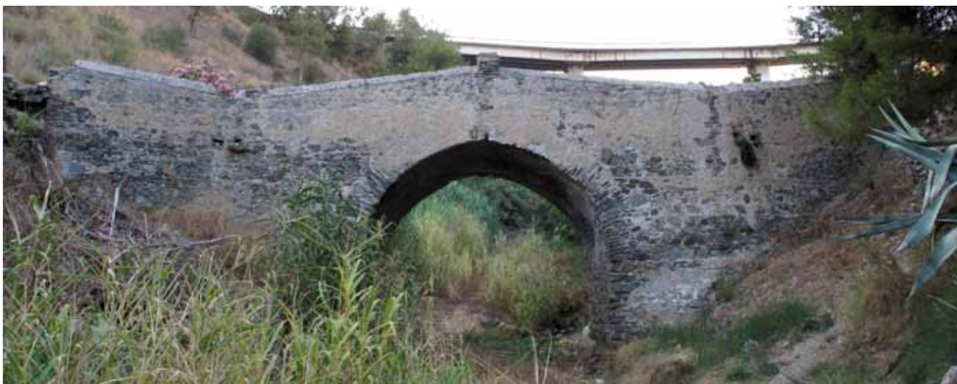
Fig. 13. Probable puente romano de Cotobro, realizado con mampostería hidráulica, en Almuñecar, Granada (Foto M. Durán)
