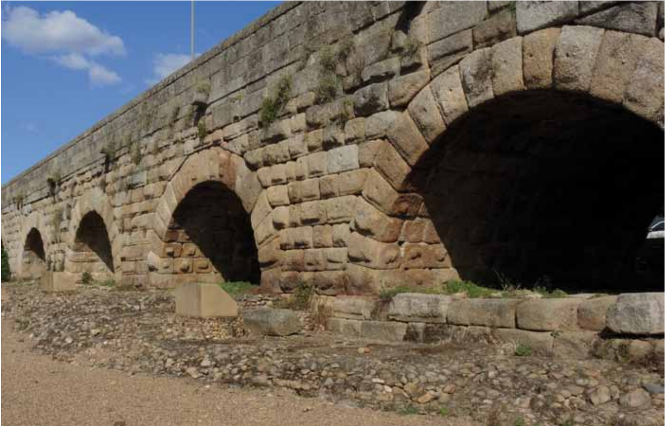
Fig. 11. Cimentación artificial de hormigón de cal y canto bajo las pilas del puente de Mérida en la margen derecha del río Guadiana (Foto M. Durán)
