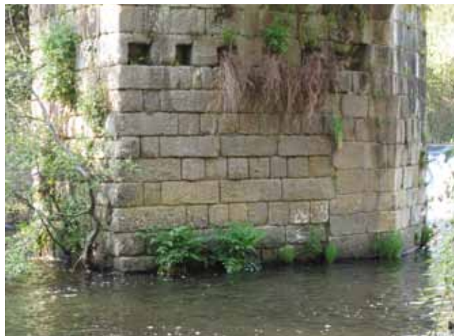
Fig. 21. Fábrica romana en la parte posterior de la pila central de A Ponte Freixo, con hiladas alternas de sillares normalizados de 1x1x3 pies dispuestos a soga y a tizón (Foto M. Durán)
