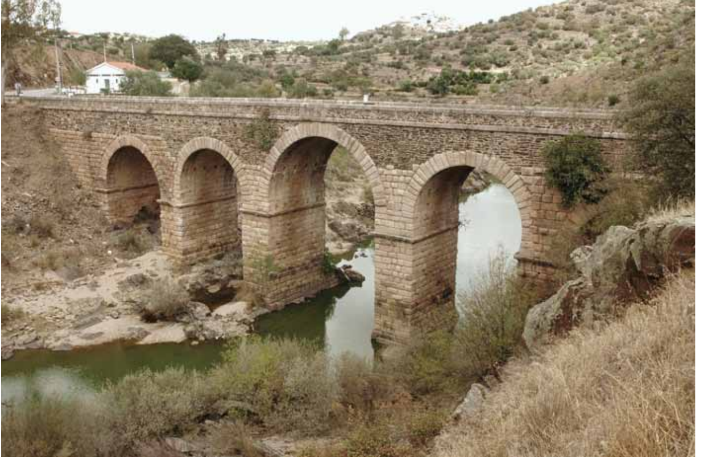
Fig. 10. Buena cimentación del puente de Segura (Cáceres-Portugal) en la roca del cauce (Foto M. Durán)
