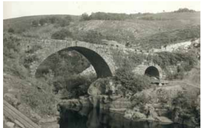
Fig. 16. Alzado aguas abajo de A Ponte Pedriña, Ourense (Foto Archivo Central, Ministerio de Cultura, Caja 88048, exp. N° 14)
