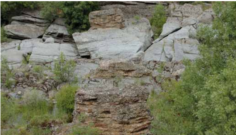
Fig. 12. Relleno de hormigón de una pila del puente de A Pontóriga, en Ourense (Foto M. Durán)
