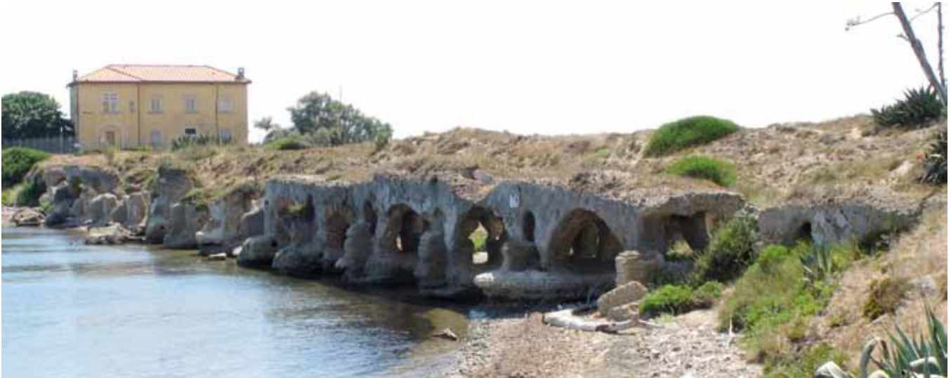
Fig. 14. Puente de Torre Astura realizado con hormigón de cal (Foto M. Durán)
