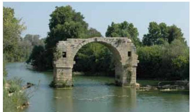
Fig. 8. Ruinas del Pont Ambroix en la Vía Domicia, Francia (Foto M. Durán)
