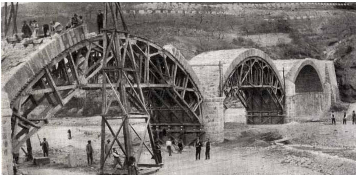
Fig. 9. Construcción de un puente carretero
