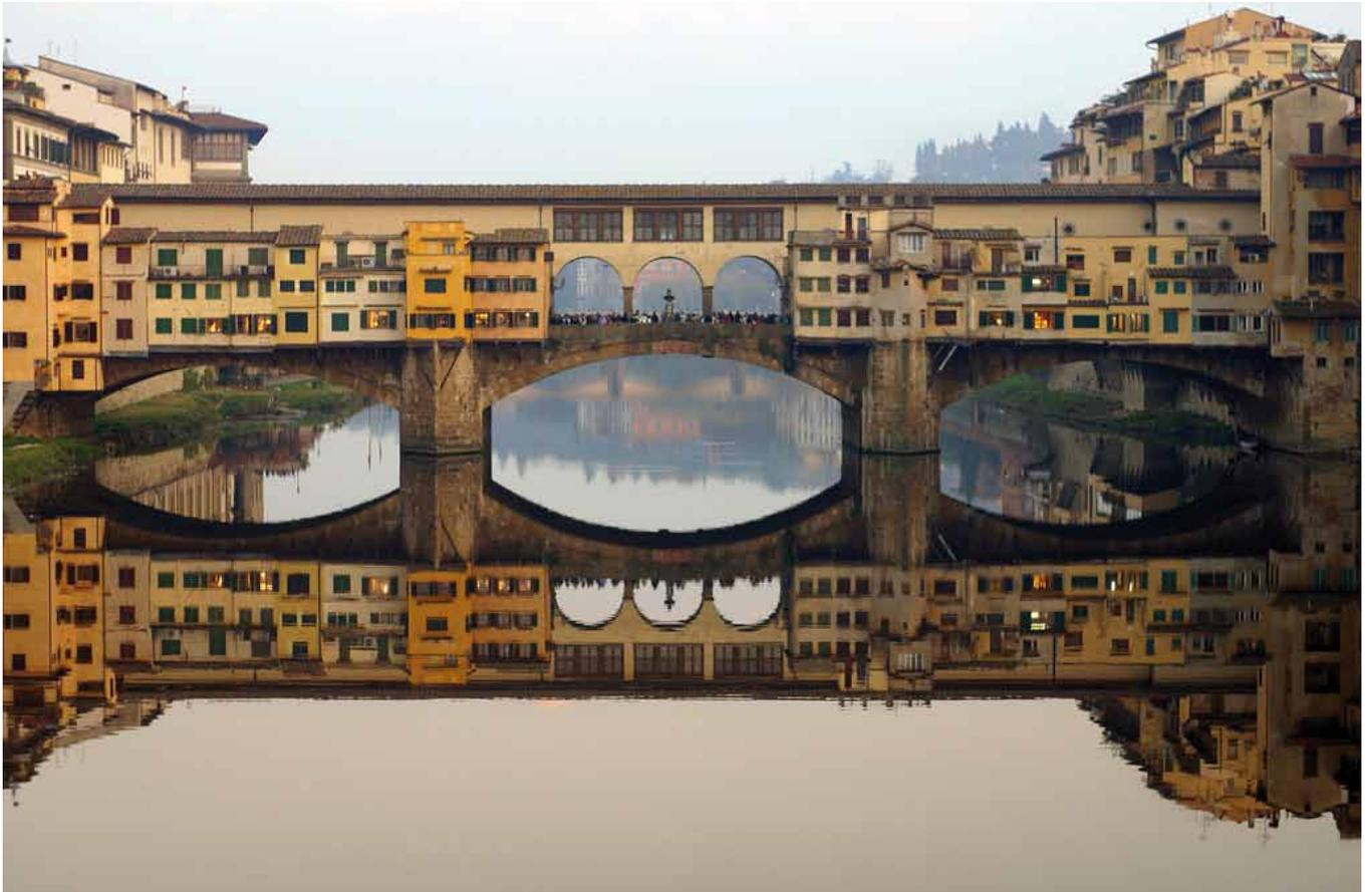
Fig. 3. Puente Vecchio. Bóvedas de 30 m de luz con un rebajamiento de 1/7
