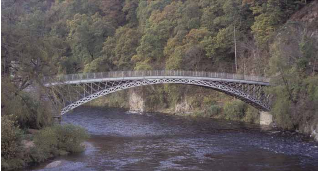
Fig. 2. Puente de Craigelachie sobre el río Spey. Escocia. Luz 45 m. 1815. T. Telford
