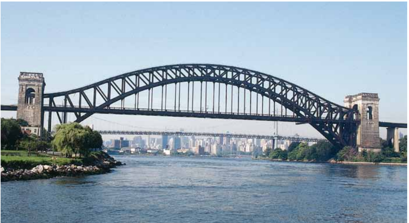
Fig. 13. Puente sobre la Hell Gate en Nueva York. Luz 298 m. 1917. G. Lindenthal
