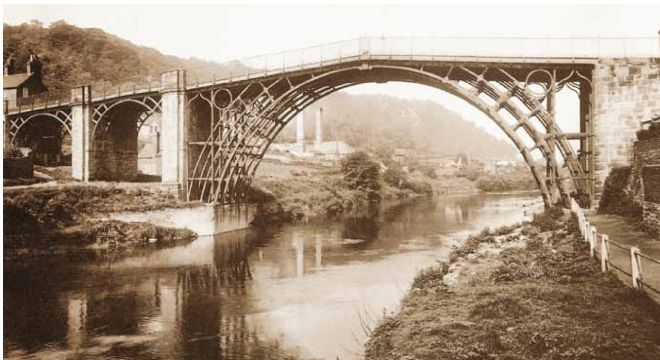
Fig. 1. Puente de Coalbrookdale sobre el río Severn (Gran Bretaña). Luz 30 m. 1779. T. Pritchard. A. Darby III, J. Wilkinson
