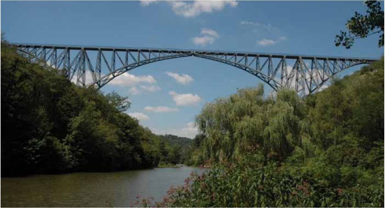
Fig. 12. Viaducto de Viaur sobre el río Viaur (Francia). Luz 220 m. 1902. P. Bodin
