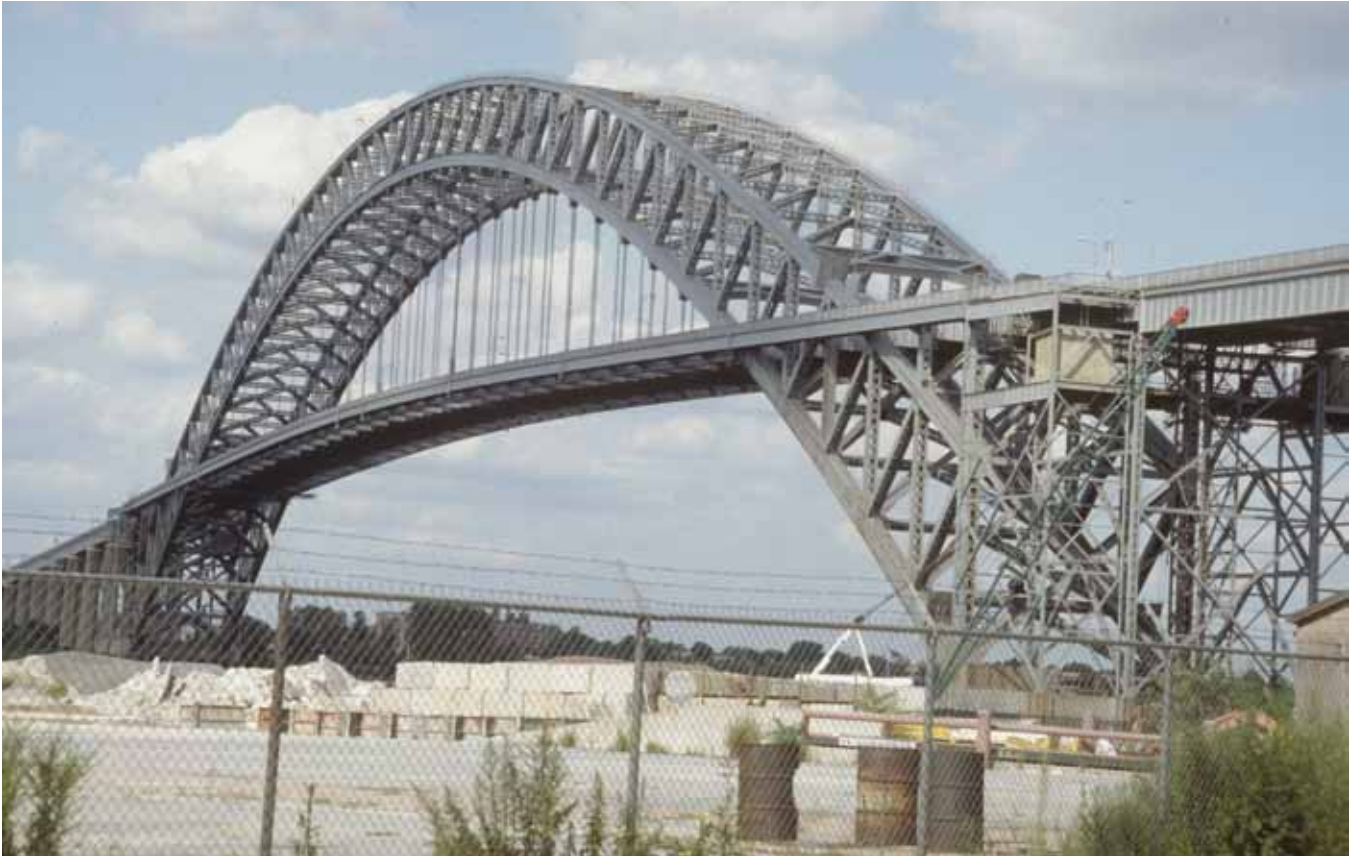
Fig. 15. Puente de Bayona sobre el Kill Van Kull, en Nueva York. Luz 504 m. 1932. O. Ammann
