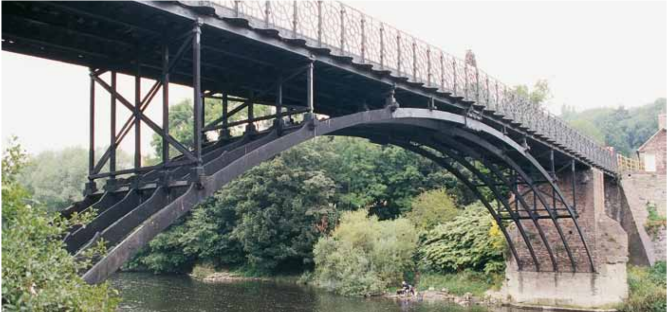
Fig. 3. Puente de Coalport. Luz 31 m. 1818
