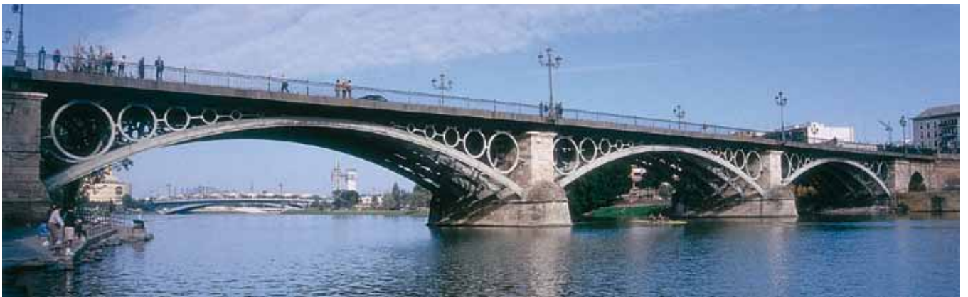
Fig. 4. Puente de Triana en Sevilla sobre el río Guadalquivir. Luz 46,5 m. 1845. G. Steinacher, F. Bernadet
