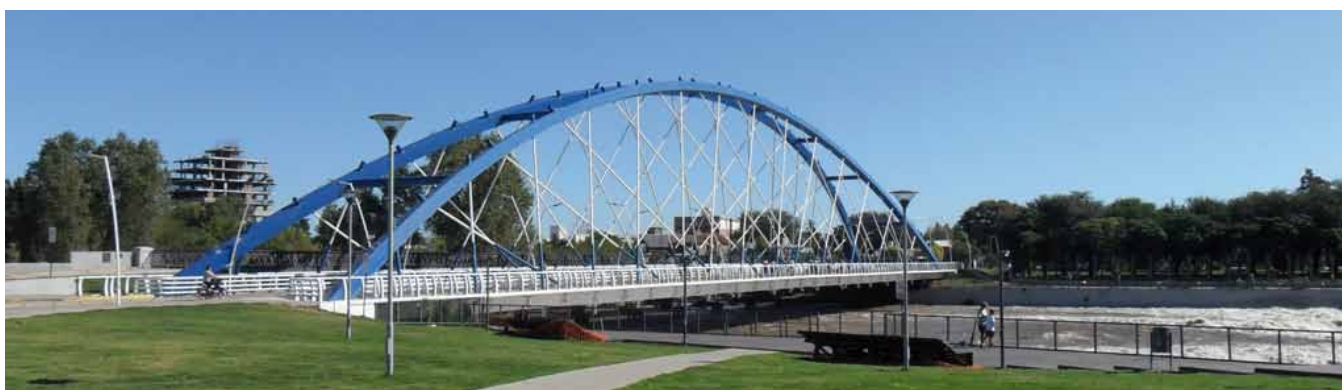
Fig. 18. Puente sobre el río Tercero, en Villamaría
