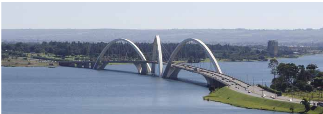
Fig. 32. Puente Juscelino Kubitschek
