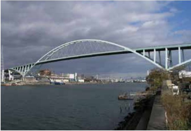
Fig. 23. Puente Shin Kizugawa
