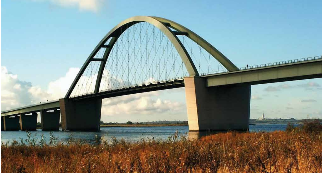
Fig. 14. Puente sobre el estrecho de Fehmarn
