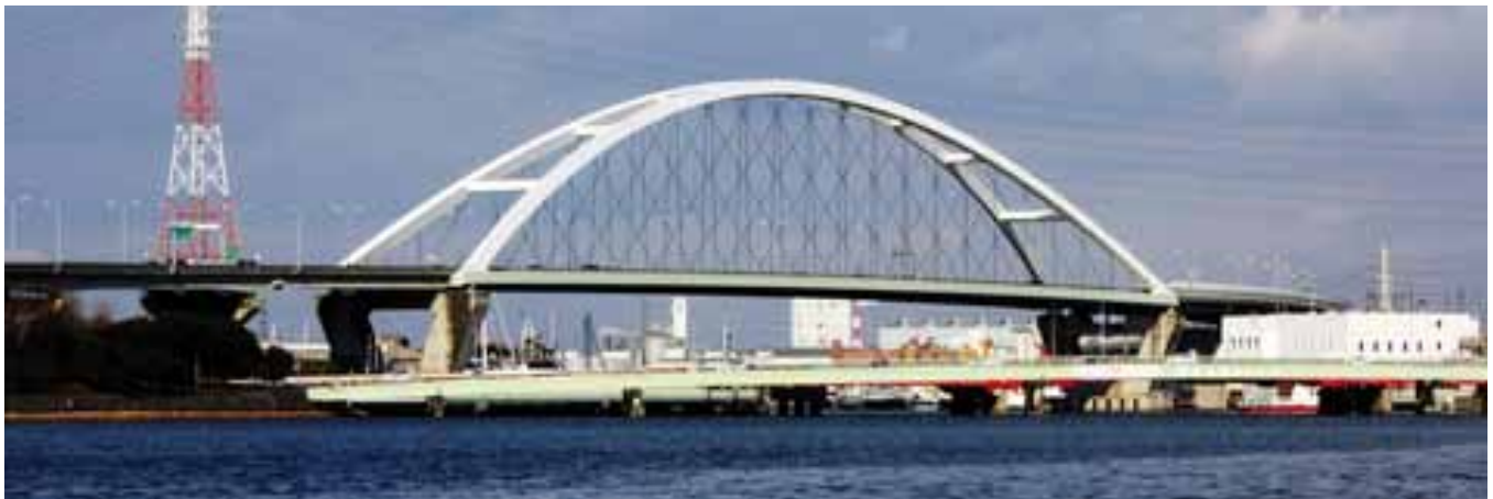
Fig. 15. Puente de Shin-Hamadera
