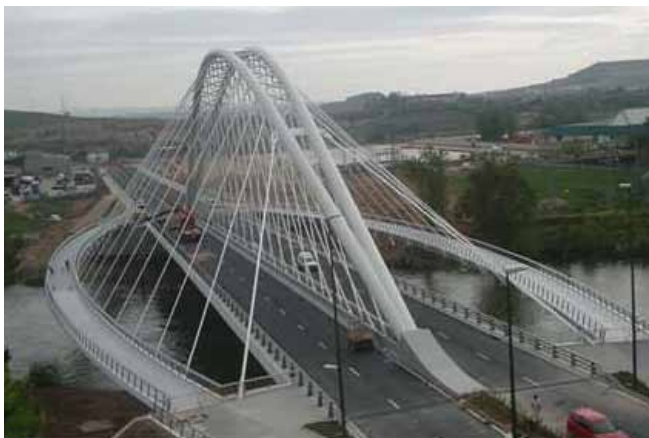
Fig. 28. Cuarto puente sobre el río Ebro, en Logroño
