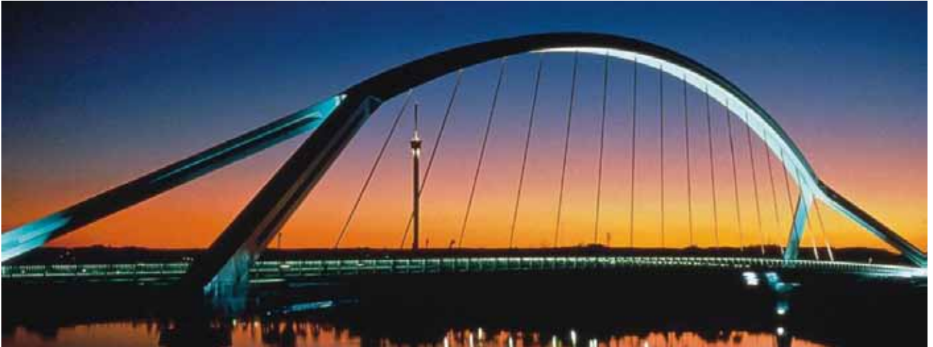
Fig. 19. Puente de la Barqueta
