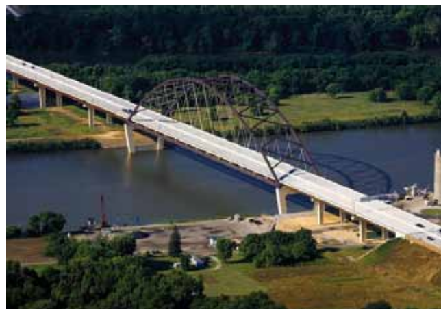
Fig. 17. Puente Blennerhassett Island
