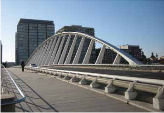
Fig. 30. Puente de la Alameda
