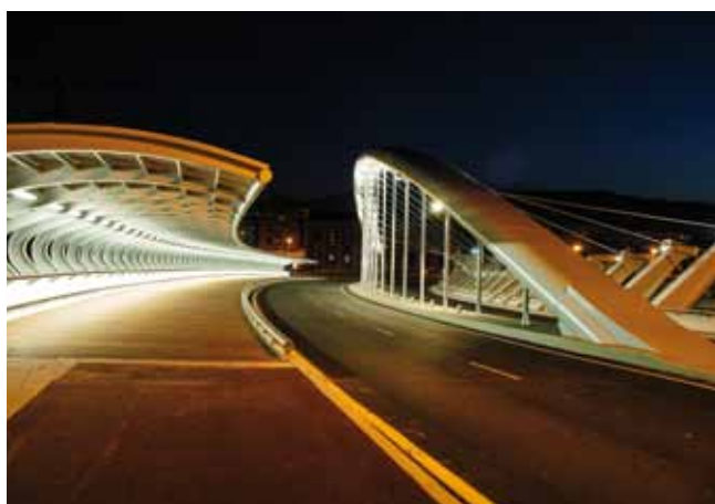
Fig. 34. Puente sobre el río Galindo
