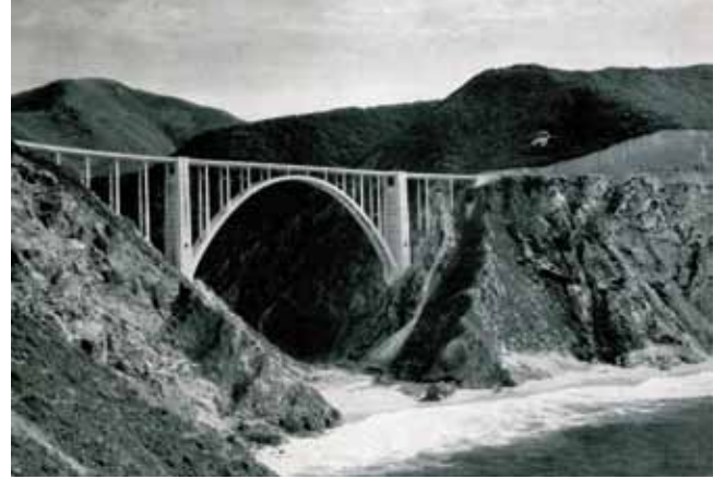
Fig. 19. Puente de Bixby
