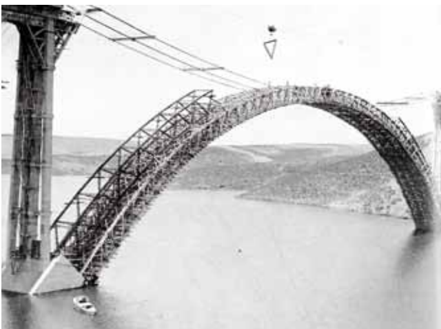
Fig. 46b. Construcción del arco de Martín Gil
