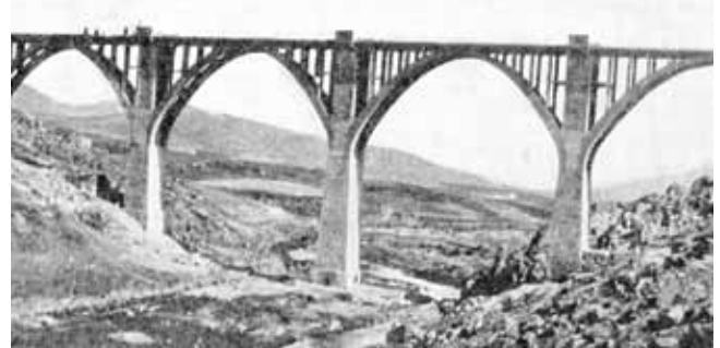
Fig. 15a y 15 b. Puente de Gaznata
