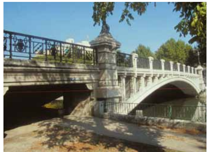
Fig. 13. Puente de la Reina Victoria
