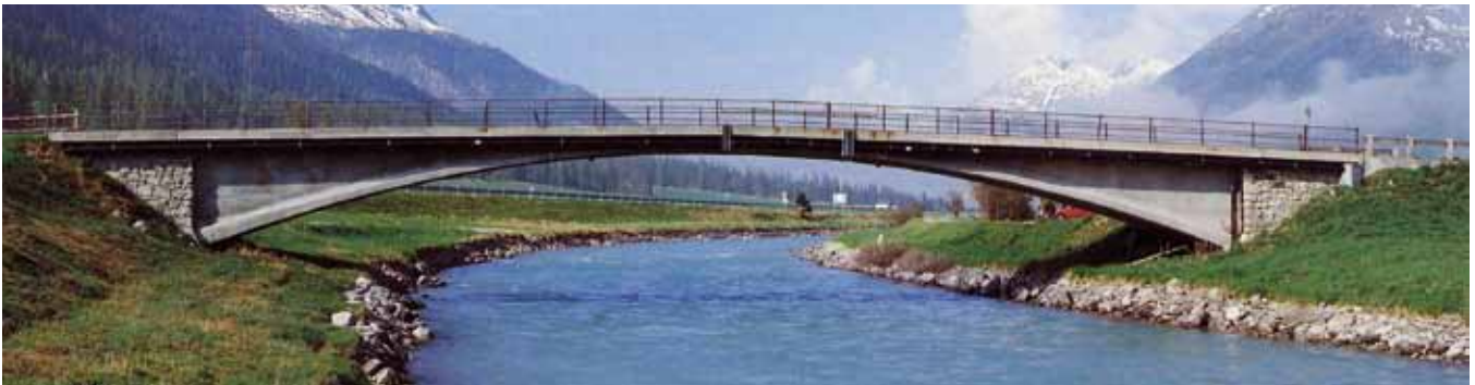
Fig. 26. Puente sobre el río Inn, en Zuoz
