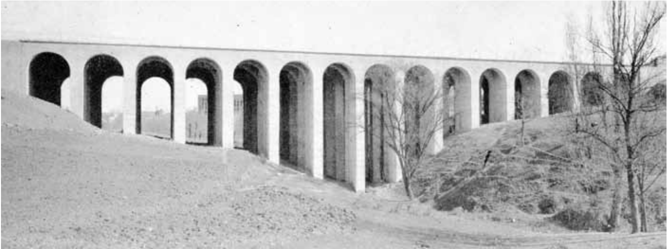
Fig. 44. Viaducto de los 15 Ojos
