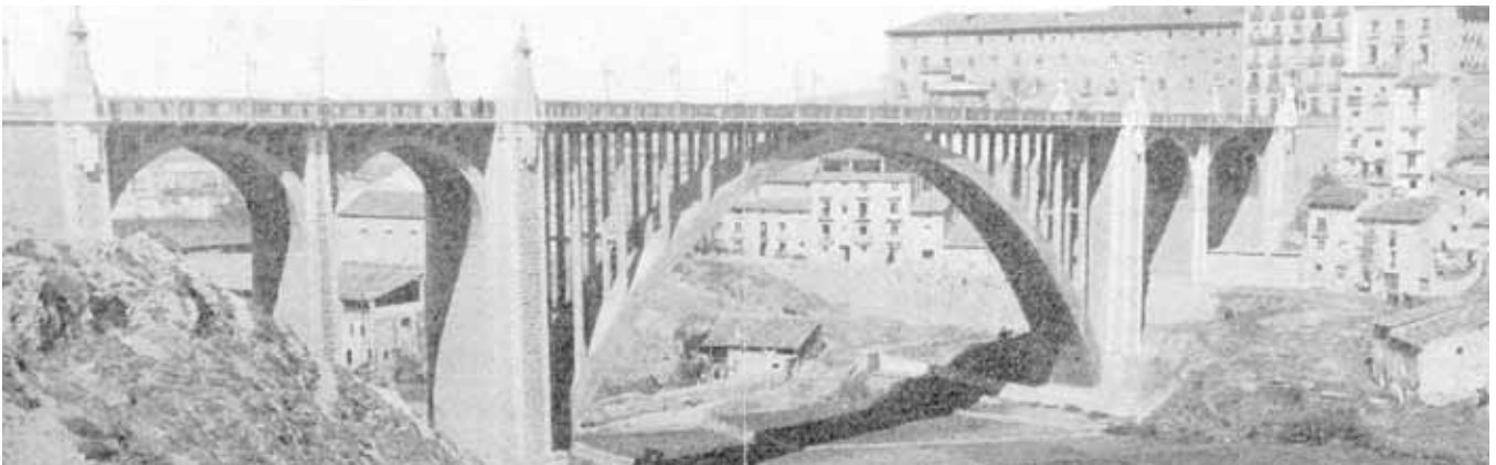
Fig. 16. Viaducto de Teruel
