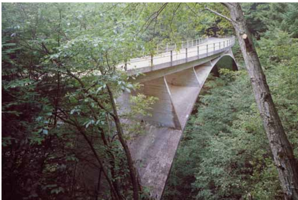
Fig. 29. Puente de Schwandbach
