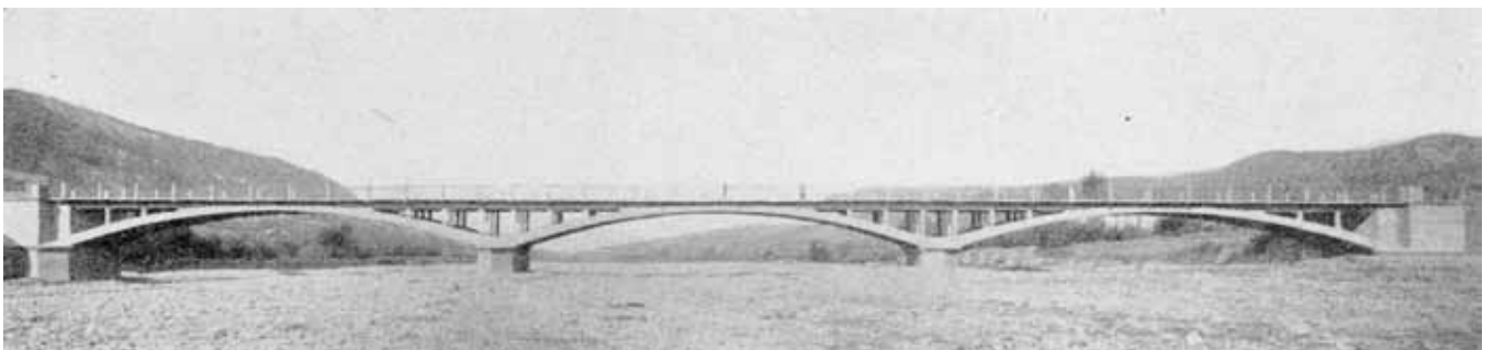
Fig. 25. Puente de Varzi
