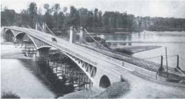
Fig. 31a. Puente de Veudre
