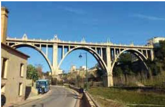
Fig. 20. Viaducto de San Jorge de Alcoy
