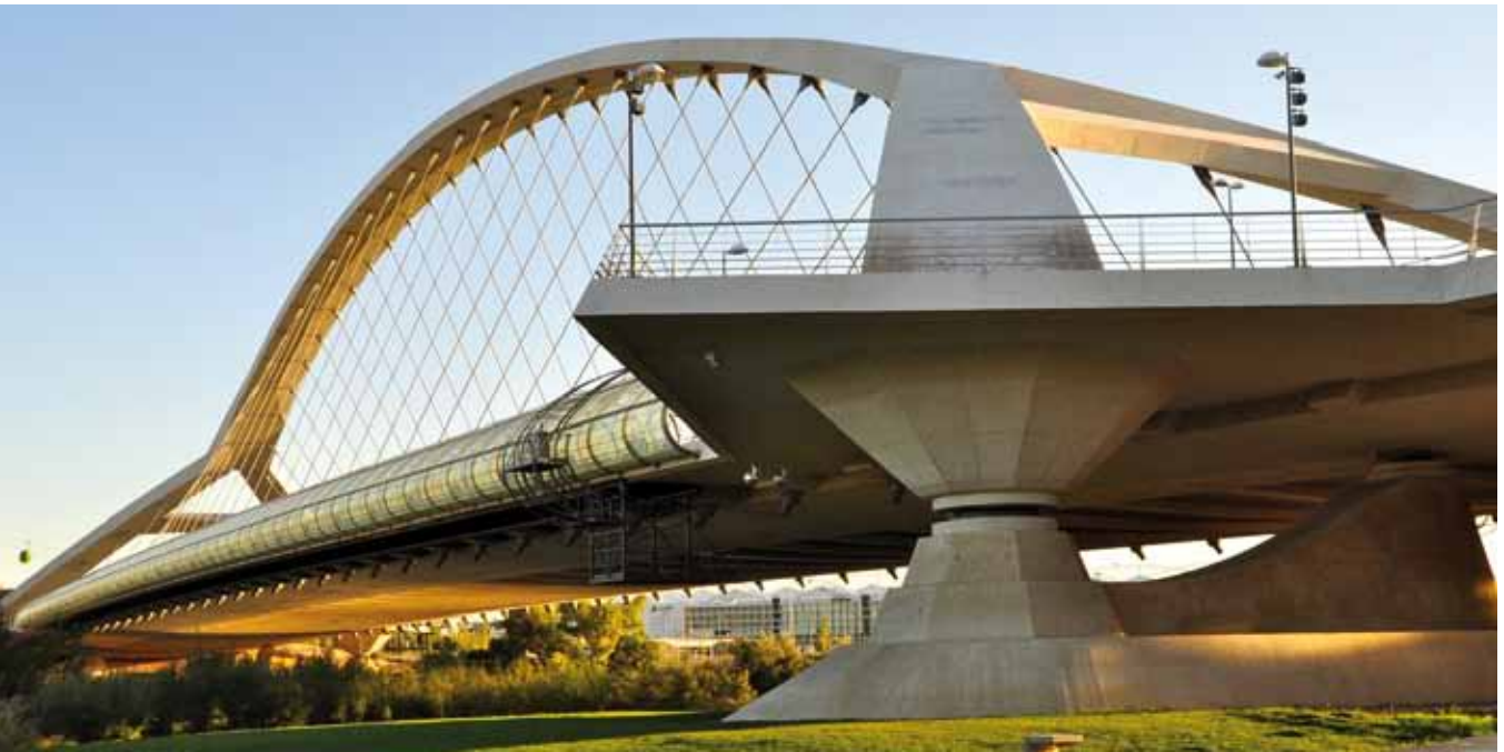
Fig. 44. Puente del Tercer Milenio
