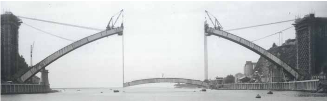
Fig.10. Puente de Arrábida. Elevación de la parte central de la cimbra metálica
