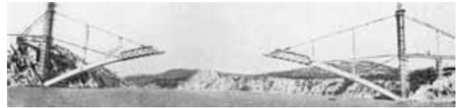
Fig. 16a. Construcción del puente de Sibenik
