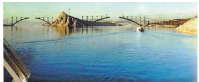
Fig. 17a. Puente de la isla Krk
