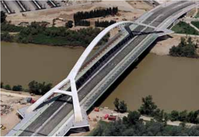
Fig. 43. Puente del Tercer Milenio
