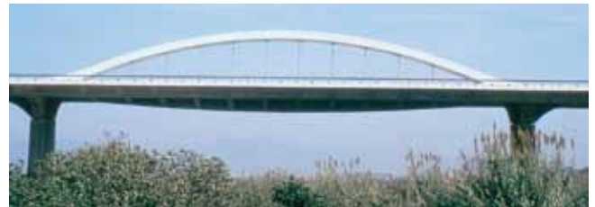
Fig. 40. Puente de Alcantarilla
