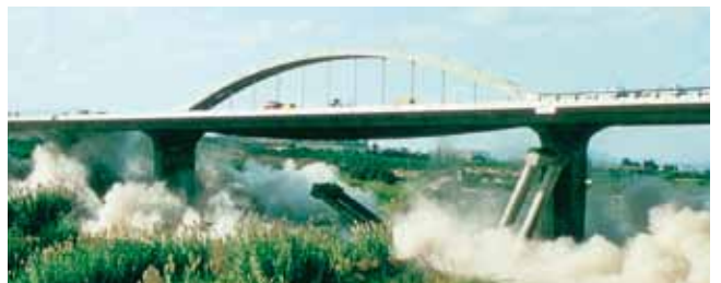
Fig. 42. Voladura del puente de Alcantarilla
