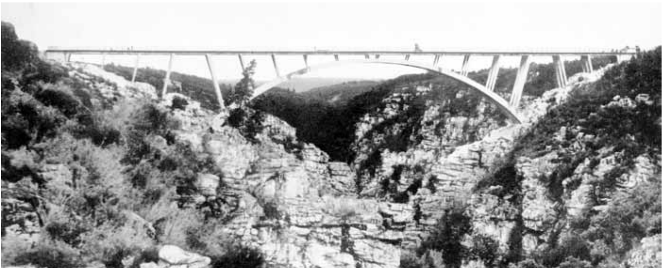
Fig. 7. Puente sobre el río Storms
