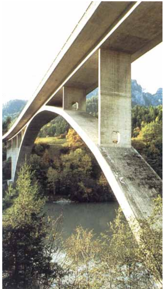
Fig. 29. Puente de Viamola
