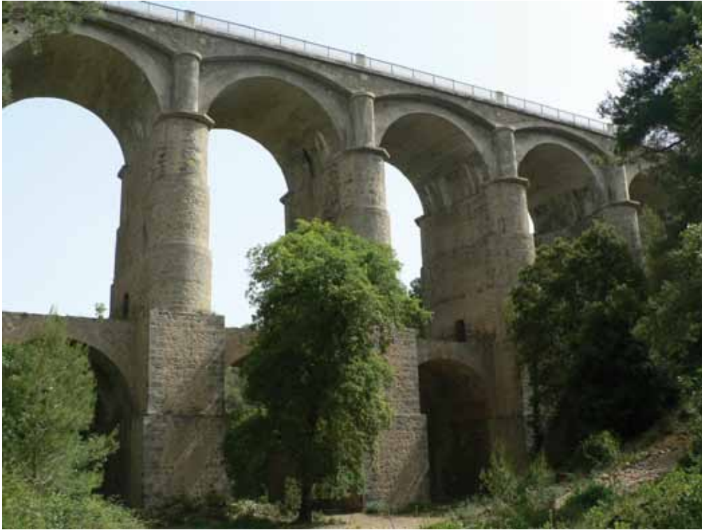
Figura 2. Viaducto de El Lledoner, N-340. Barcelona
