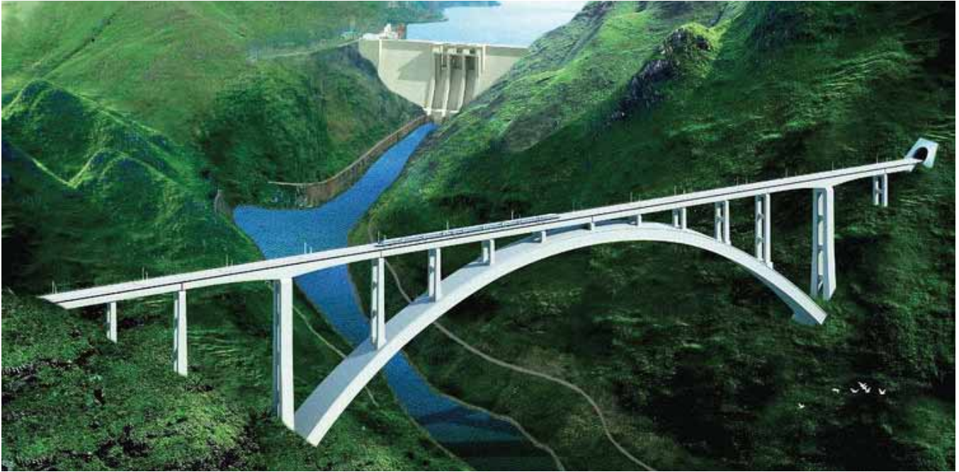
Fig. 21. Puente Beipanjiang (infografía)
