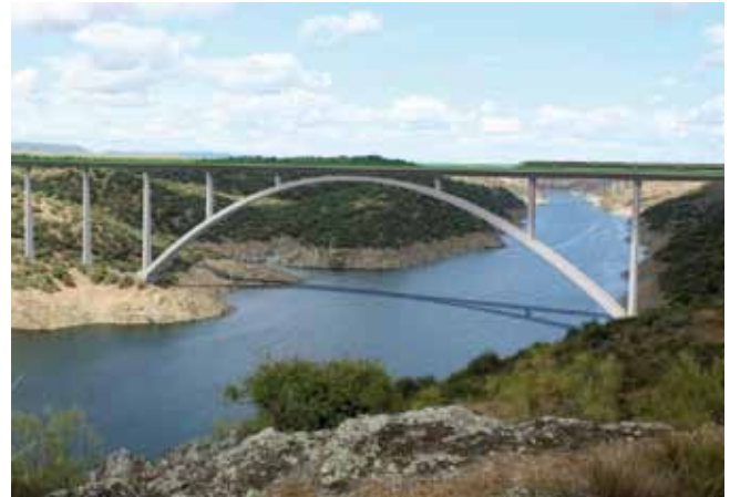
Fig. 1e. Puente sobre el río Tajo (L=324 m)
