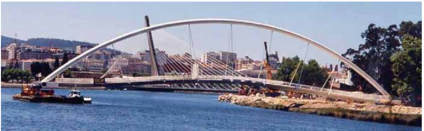
Fig. 19. Pasarela sobre el río Lérez, Pontevedra. 1997
