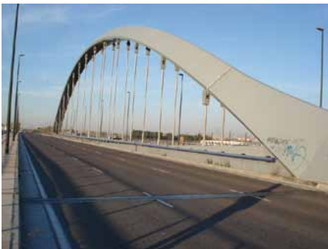
Fig. 3. Puente de Giménez Abad sobre el río Ebro (Zaragoza) con péndolas formadas por cables y uniones mediante bulones
