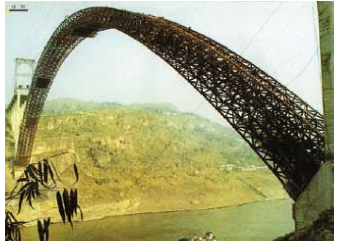
Fig. 24. Puente de Wanxian
