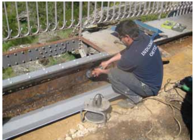
Fig. 16. Limpieza de la corrosión y colocación de la chapa de refuerzo sobre la cabeza de la viga
