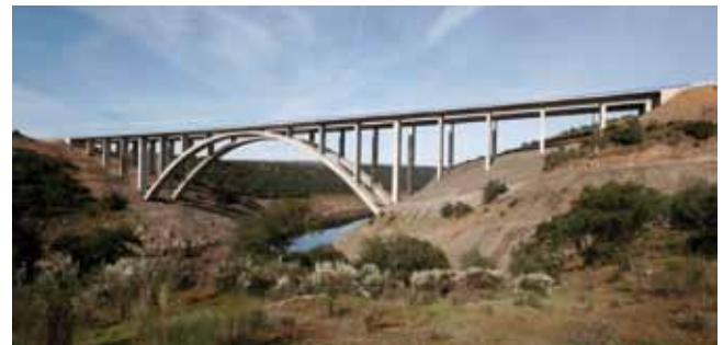
Viaducto de Almonte. (A-66. Tramo Hinojal-Cáceres, Cáceres. 2005)
