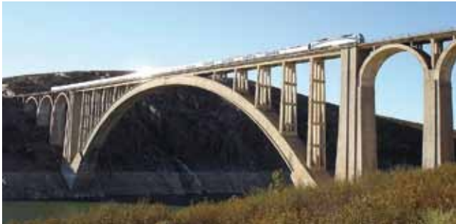
Viaducto de Martín Gil (Palacios del Pan, Zamora. 1942)
