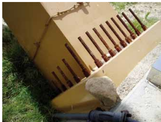
Fig. 13. Pérdida del tratamiento protector e inicio de corrosión en los anillos del arco (izquierda) e inicio de corrosión de barras de anclaje en el empotramiento de un anillo en la cimentación (derecha)
