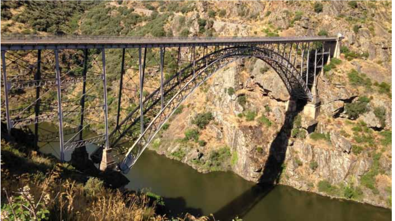
Fig. 1. Vista general del puente de Pino desde la margen derecha (Pino del Oro)
