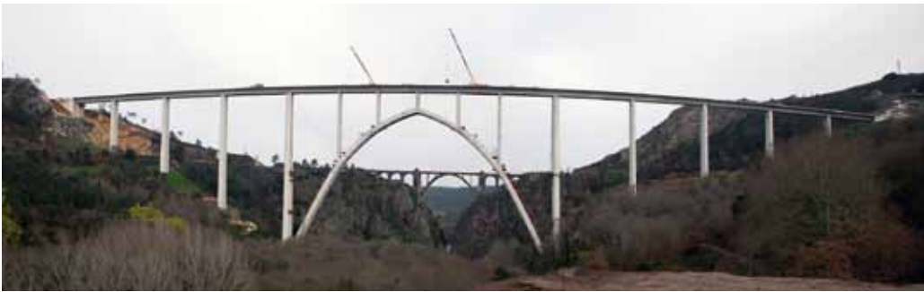
Fig. 1c. Puente sobre el río Ulla (L=179 m)
