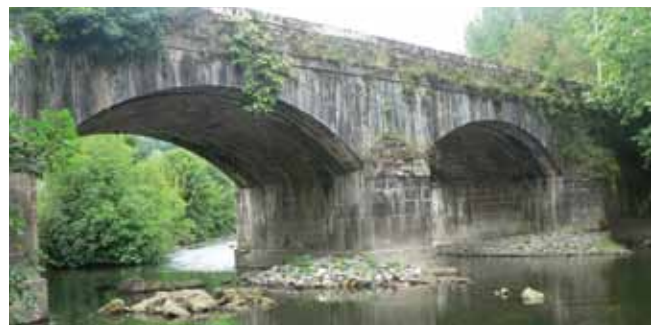
Fig. 1. Puente de Narbarte, sobre el Bidasoa (Navarra)
