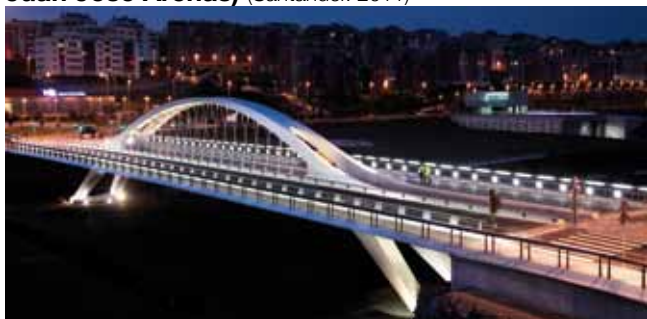
Puente de la vaguada de Las Llamas (Puente Juan José Arenas) (Santander. 2011)
