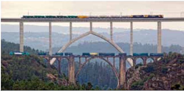
Viaducto sobre el río Ulla (LAV Orense-Santiago, A Coruña. 2010)
