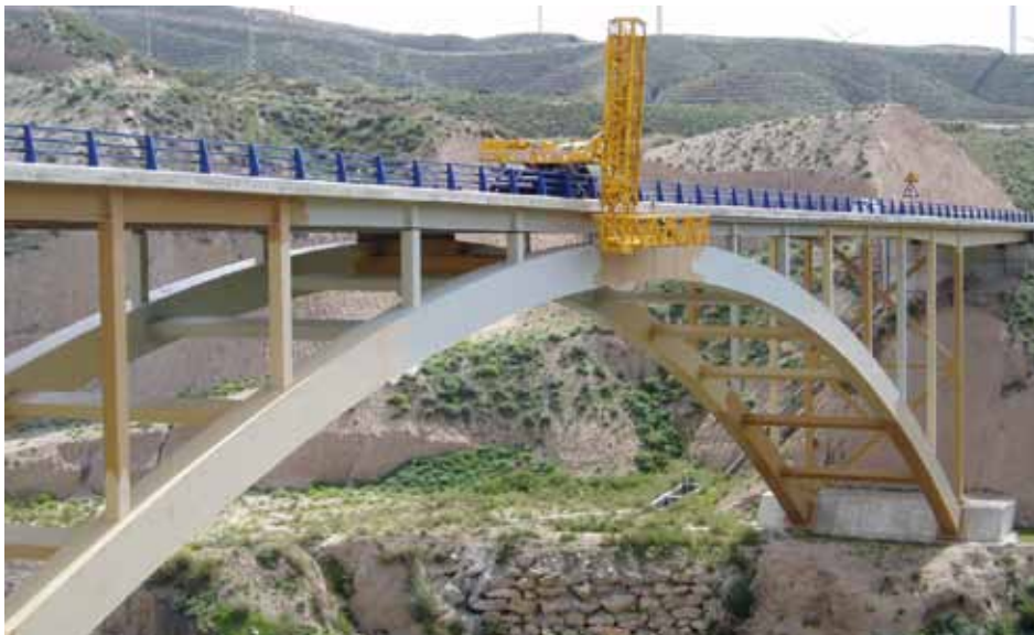
Fig. 4. Inspección del puente arco de Tablate (autovía A-44, Granada)
