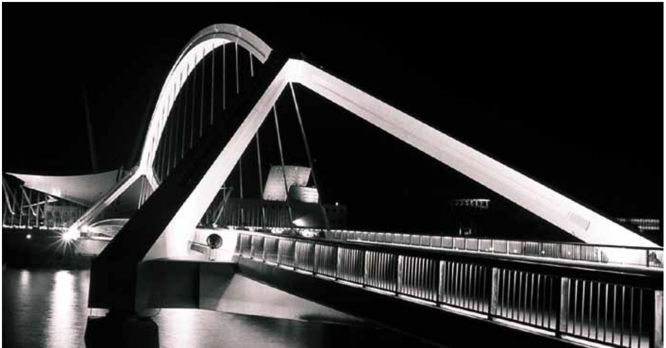
Fig. 12. Puente de La Barqueta sobre el río Guadalquivir. Sevilla, 1992. Foto: José Luis Gil Paradás
