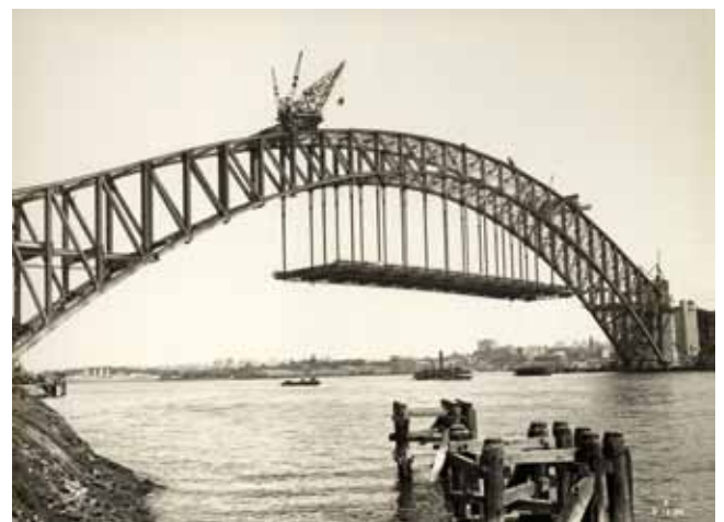
Fig. 9. Construcción del arco de Sidney
