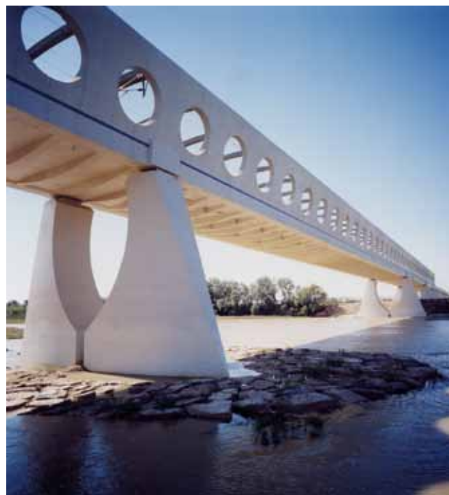
Fig. 1a. Puente sobre el río Ebro (L=120 m)
