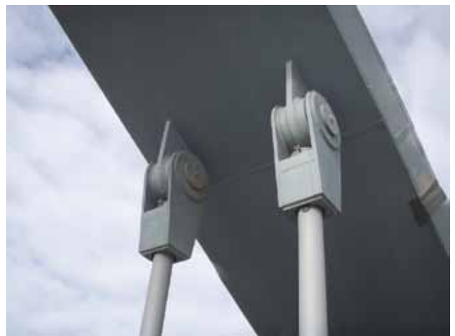
Fig. 3. Puente de Giménez Abad sobre el río Ebro (Zaragoza) con péndolas formadas por cables y uniones mediante bulones
