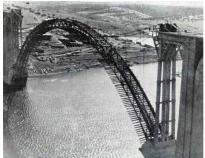
Fig. 9. Viaducto de Martín Gil sobre el embalse del Esla
