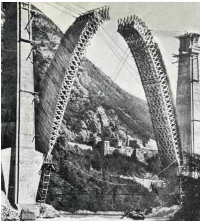
Fig. 6. Posicionamiento de la cimbra del puente de Longeray (Francia)
