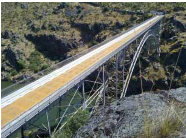
Fig. 20. Retirada de la totalidad del material de relleno
