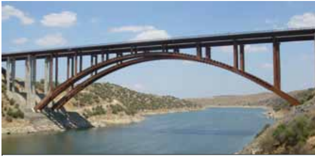
Arcos de Alconétar (Autovía de la Plata. Tramo Plasencia-Cáceres. Cruce del río Tajo sobre el embalse de Alcántara. 2006)
