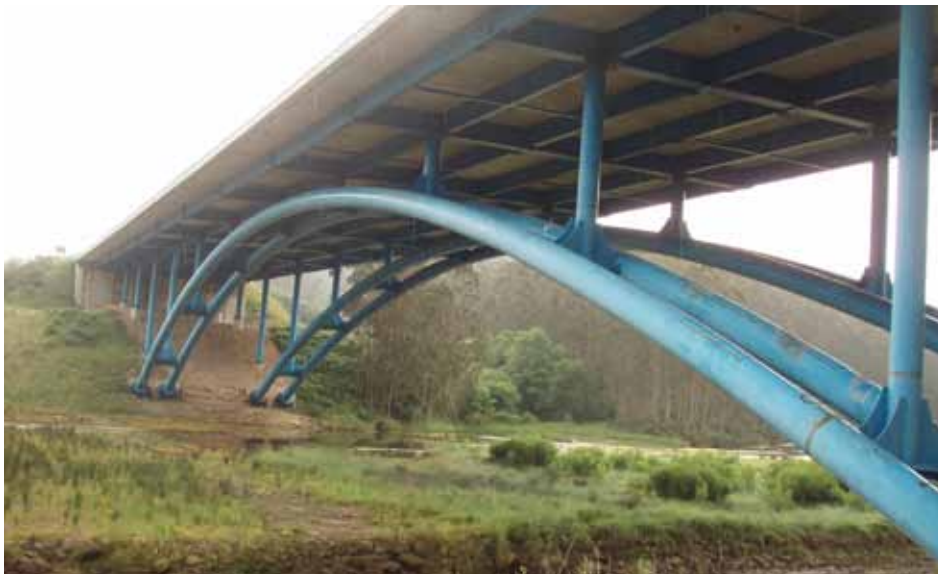
Fig. 8. Puente arco de tablero superior: los elementos del arco son los anillos (en el marco de los sistemas de gestión es habitual emplear esta terminología para designar así a los elementos principales de directriz curva y, en este caso, sección circular) y riostras transversales y los elementos del puente son los montantes verticales, el emparrillado de vigas y la losa (viaducto del Escudo, autovía A-8, Cantabria)
