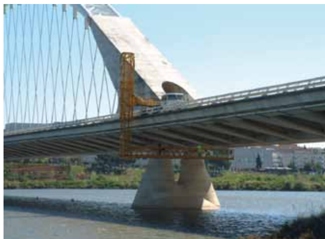
Fig. 5. Inspección del puente arco de Lusitania (Mérida)
