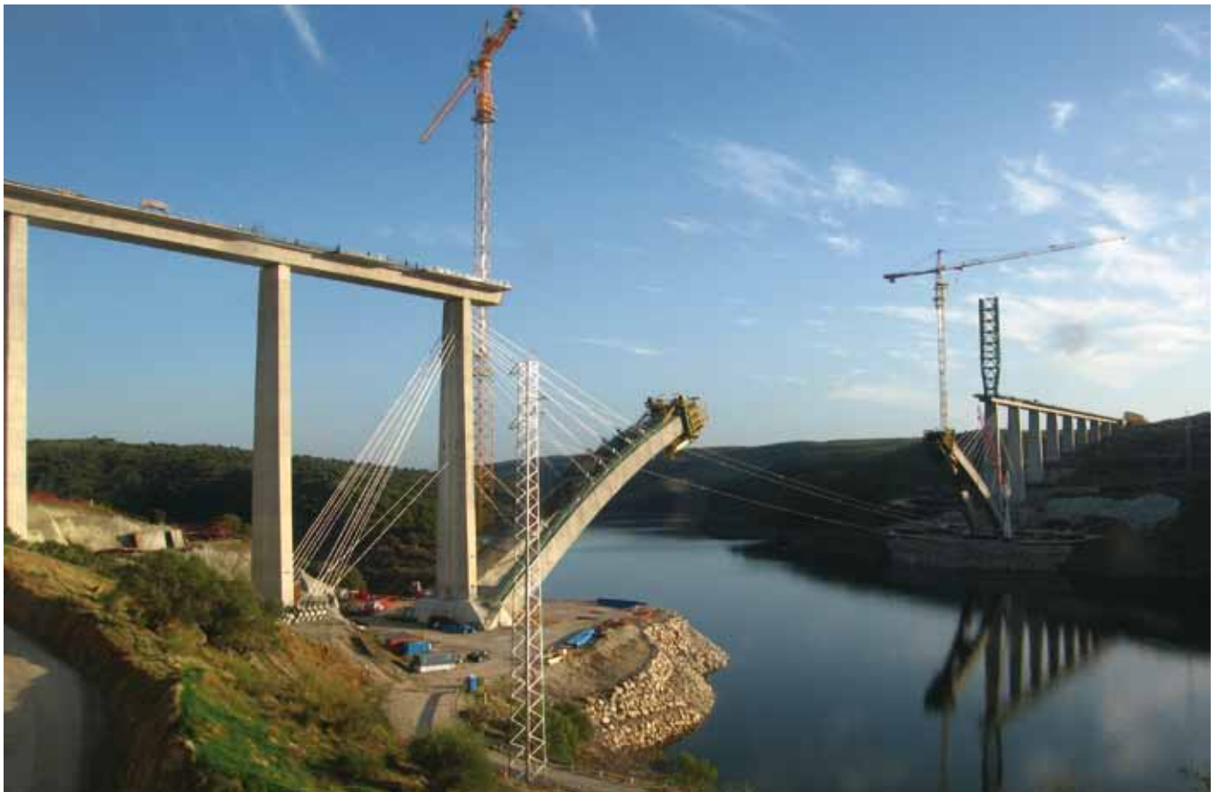
Fig. 11. Viaducto sobre el río Almonte en el embalse de Alcántara, Cáceres. LAV Madrid - Lisboa
