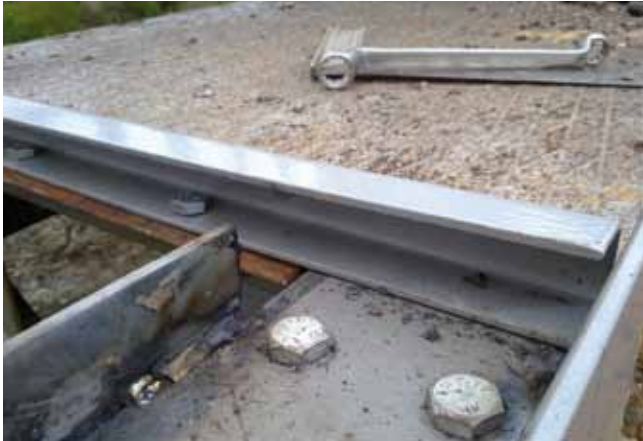
Fig. 18. Colocación de los perfiles con sección en C para atornillado de las chapas de las aceras
