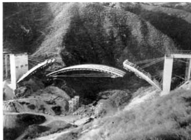
Fig. 7. Cimbra de La Guaira
