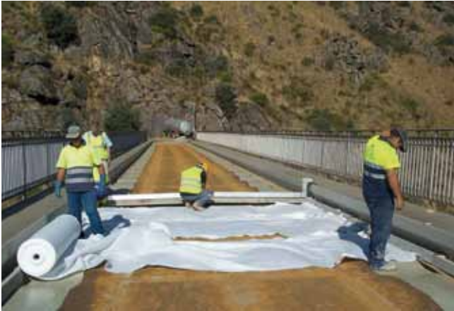
Fig. 22. Colocación de geotextil
