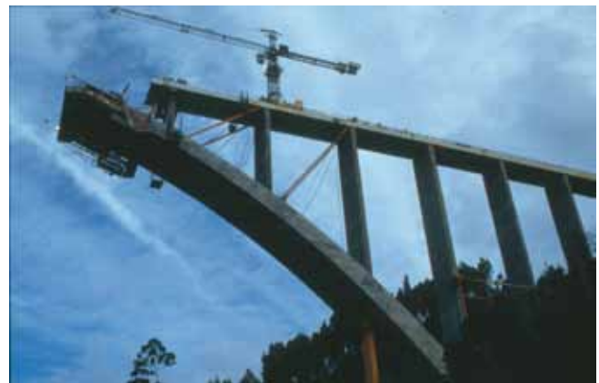
Fig. 10. Puente arco del Pintor Fierros en fase de construcción.
