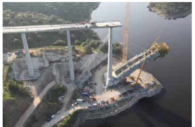
Figs. 14 y 15. Vistas de la ejecución en voladizo de los arcos con atirantamiento provisional (fuente: Eduardo Rojo, A&A y FCC)
