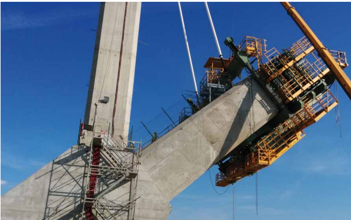
Fig. 6. Carro de hormigonado
