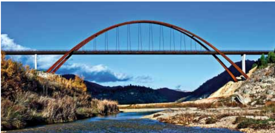
Fig. 10. Puente arco de tablero intermedio: los elementos del arco son los anillos, las péndolas y las riostras transversales entre anillos y elementos del puente las pilas verticales y la losa del tablero (puente arco de la Vicaría sobre el embalse de La Fuensanta en el río Segura, Albacete)
