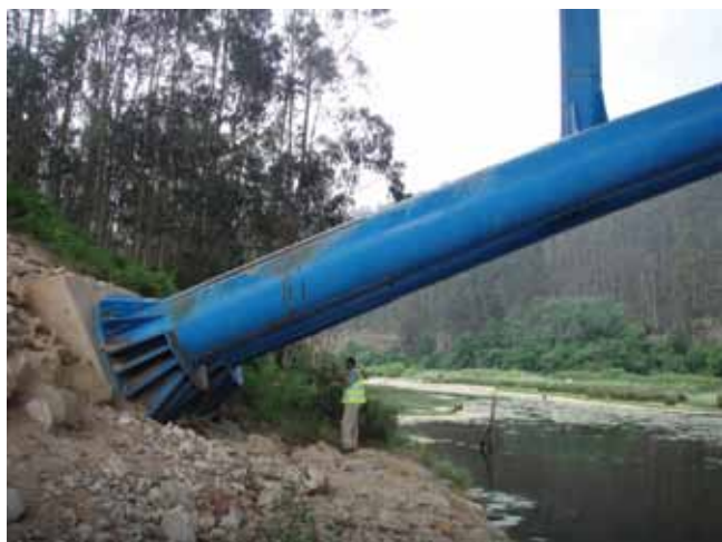
Fig. 13. Pérdida del tratamiento protector e inicio de corrosión en los anillos del arco (izquierda) e inicio de corrosión de barras de anclaje en el empotramiento de un anillo en la cimentación (derecha)
