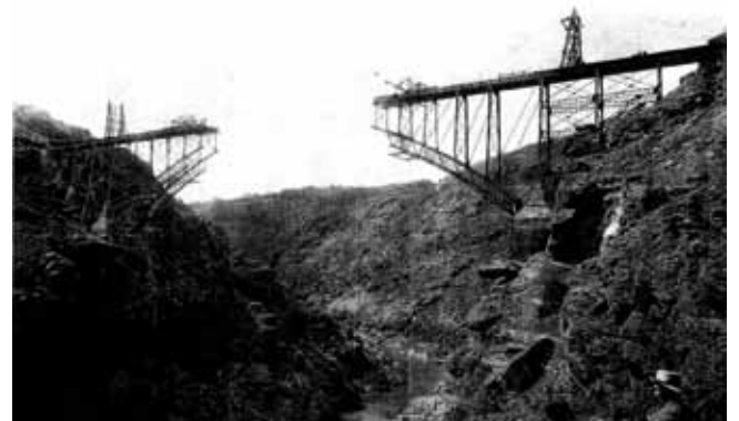
Fig. 8. Puente de Pino, en fase de construcción (fotografía tomada el 1 de julio de 1913)
