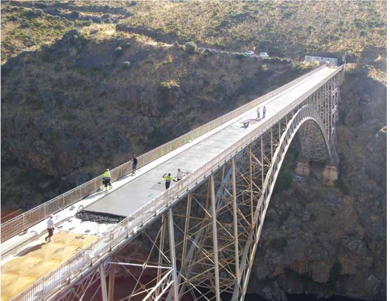
Fig. 25. Vista general del puente durante el hormigonado del tablero
