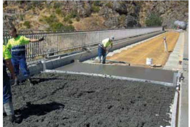
Fig. 23. Hormigonado del tablero (Espesor medio: 14 cm)
