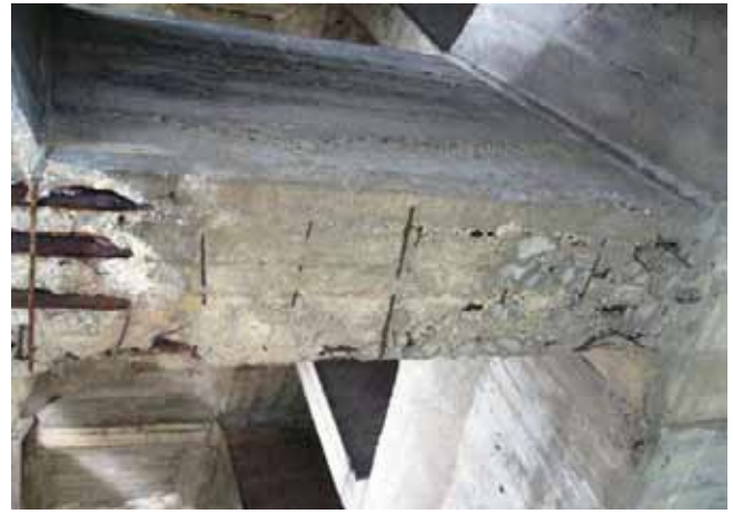
Fig. 11. Inspección del puente sobre el río Ebro, en Miranda de Ebro. Detalle de armaduras vistas en riostra entre anillos
