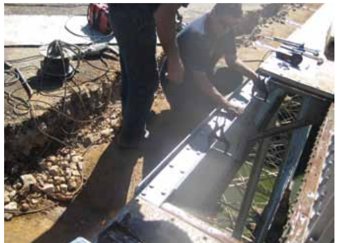
Fig. 17. Colocación de las chapas laterales de refuerzo
