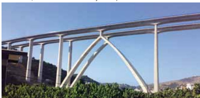
Viaducto del Verde (Autovía del Mediterráneo. Tramo Almuñecar, La Herradura-Taramay. 2006)
