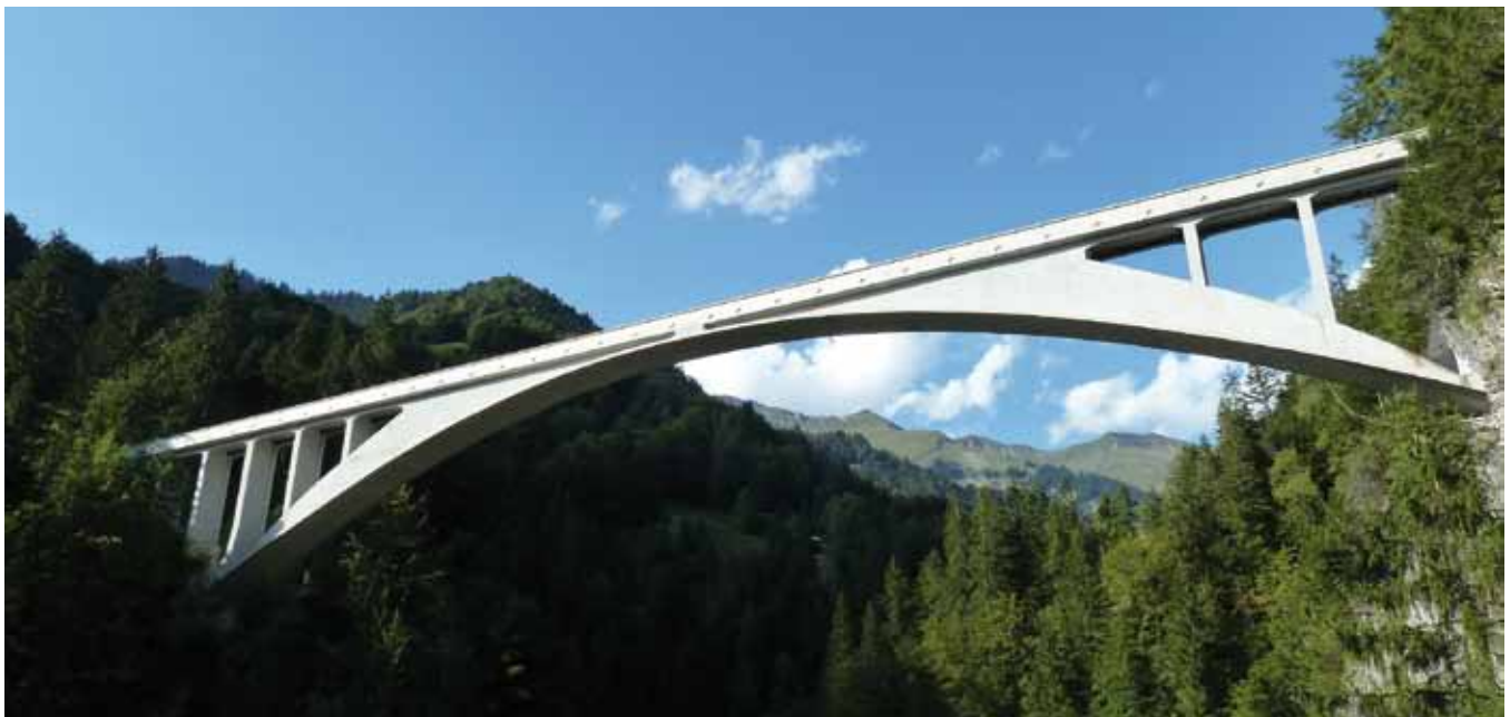
Fig. 7. Puente de Salginatobel (Robert Maillart, 1930). Fotografía: Miguel Sacristán Montesinos
