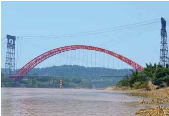
Fig. 26. Puente de Bosiden
