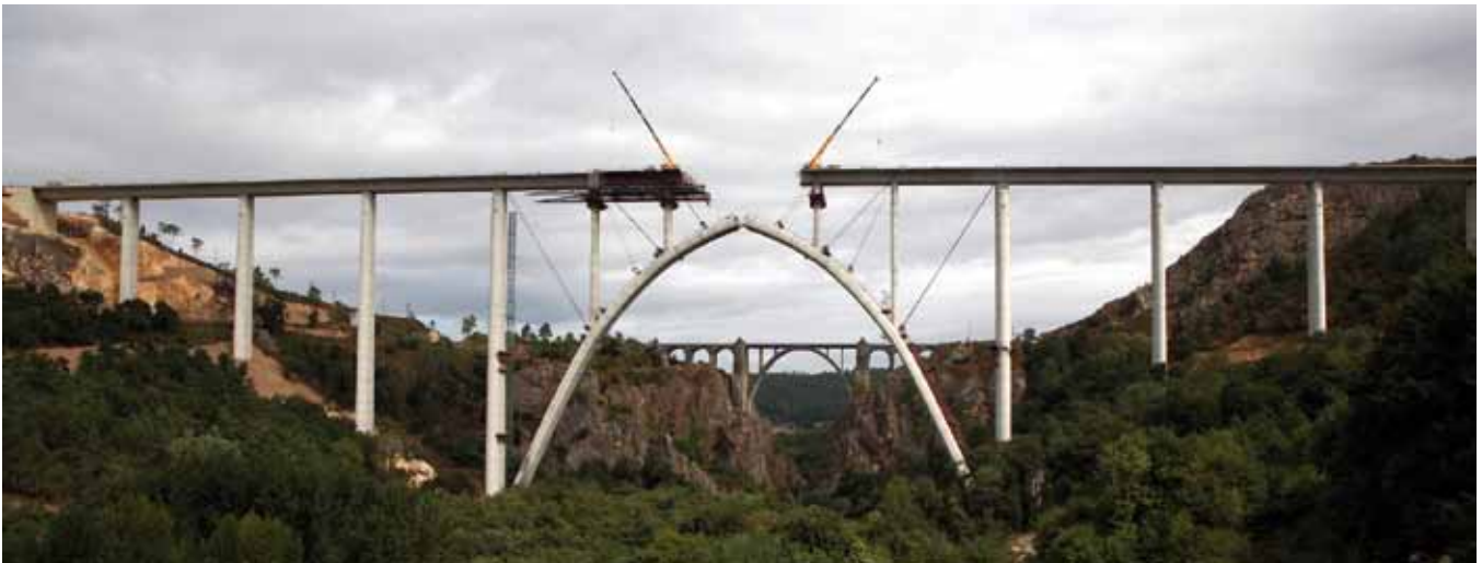
Fig. 16. Viaducto del río Ulla
