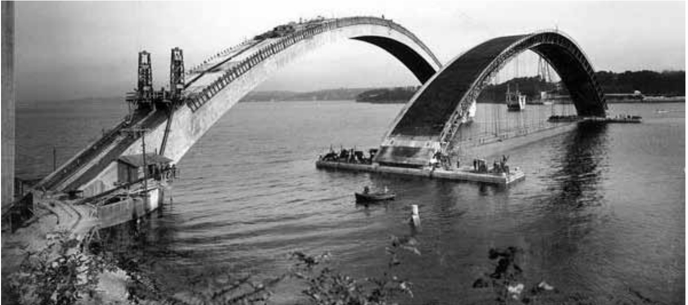
Fig. 4. Cimbra del puente de Plougastel
