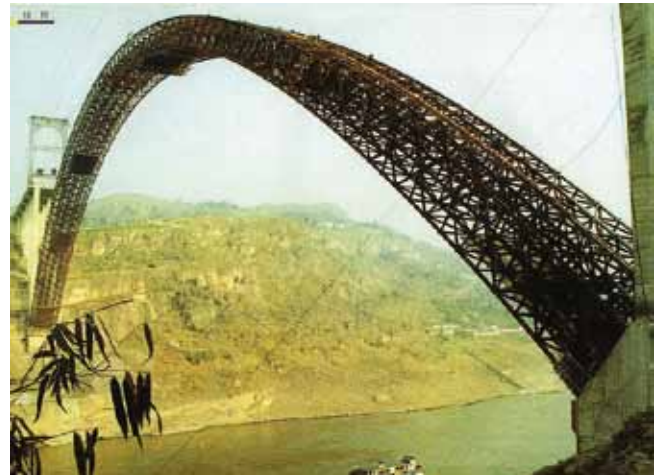
Fig. 24. Puente de Wanxian
