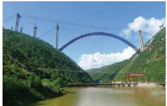
Fig. 22. Puente Beipanjiang (izquierda) y puente Nanpanjiang (derecha)
