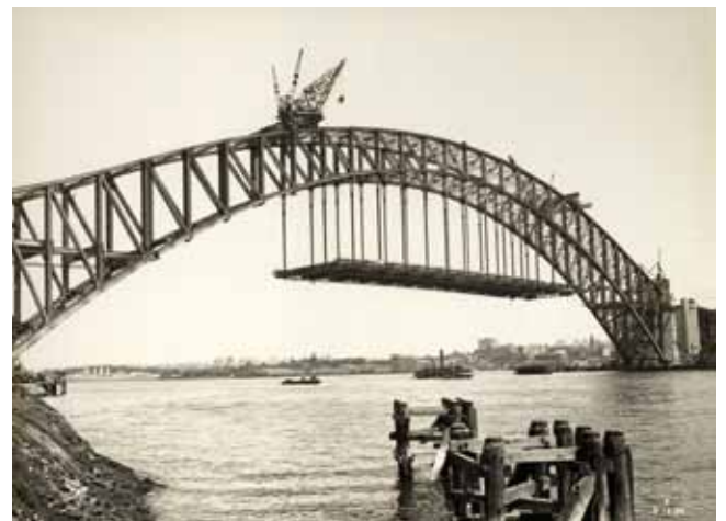
Fig. 9. Construcción del arco de Sidney
