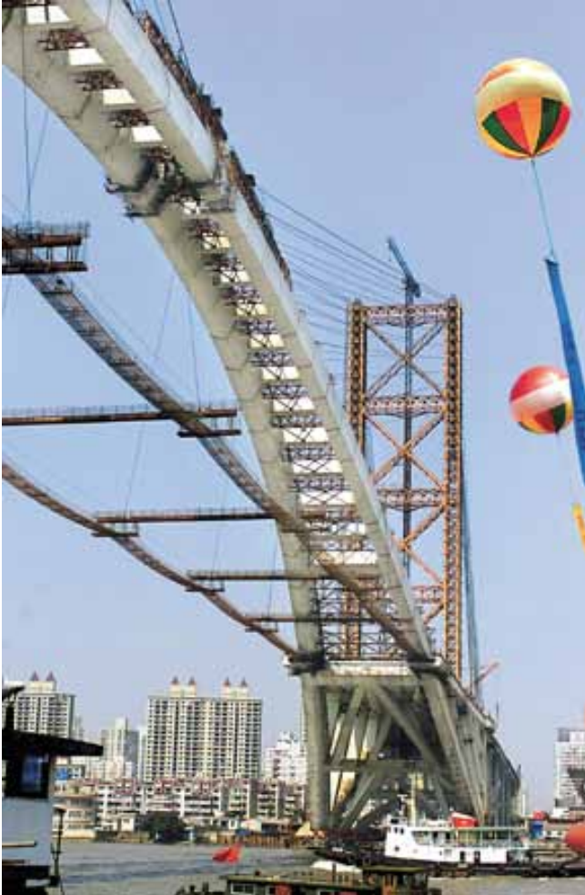
Fig. 3b. El arco de Lupu, en construcción
