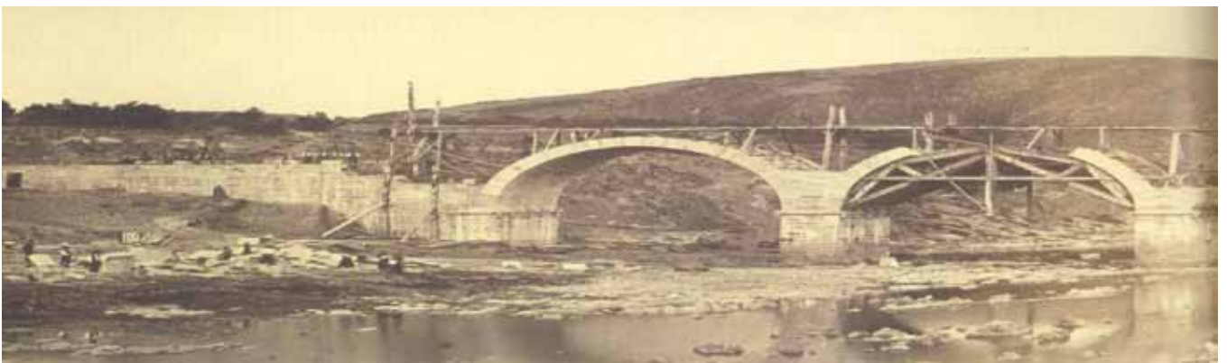
Fig. 7. Construcción de un puente sobre el río Tera, en Zamora (Foto: Laurent, mediados del s. XIX)
