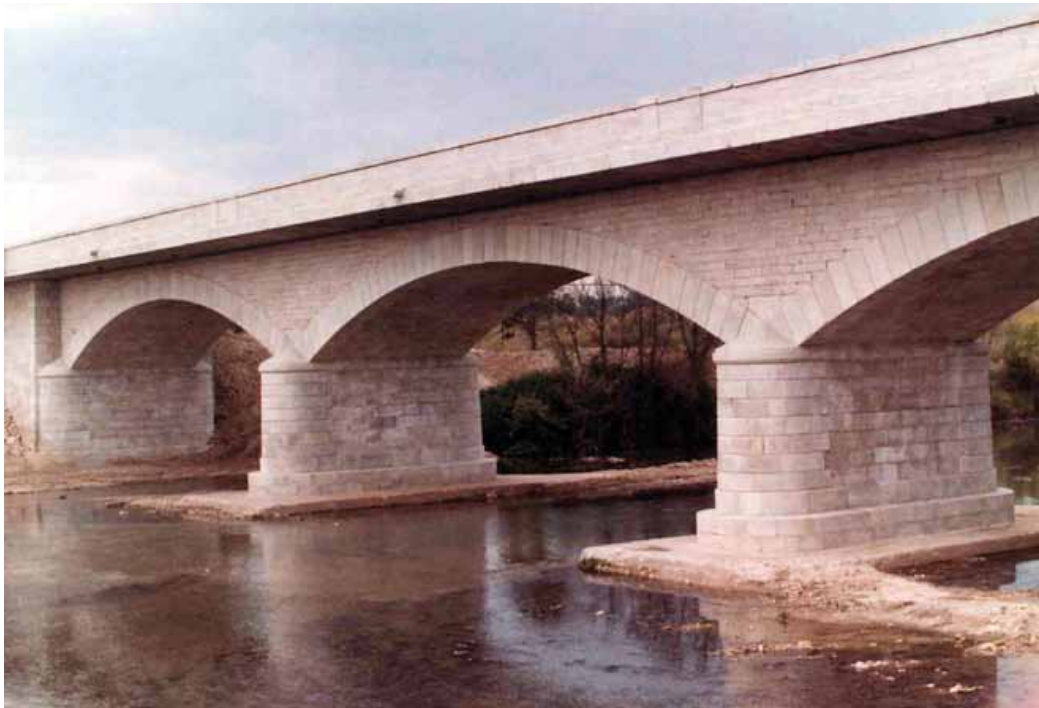
Fig. 16. Ensanche del puente de Algete, sobre el Jarama. Si bien el resultado formal es impecable y el proceso está muy bien documentado, se echa de menos un esfuerzo mayor por haber aprovechado más las posibilidades estructurales de las bóvedas
