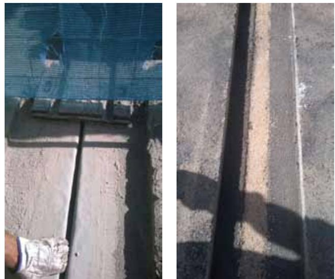
**Fig. 2. Ejecución de banda de estanqueidad bajo junta de perfil de elastómero (izquierda) y bajo junta de betún modificado con protección de arena (derecha)**
