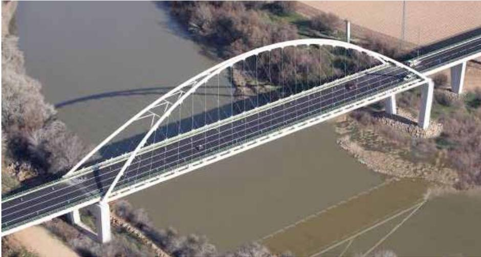
**Fig. 9. Puente arco de tablero inferior:** los elementos del arco son los anillos, las péndolas y las riostras transversales entre anillos y elementos del puente las pilas verticales y la losa del tablero (puente arco sobre el río Guadalquivir en Palma del Río, carretera A-453, Córdoba)
