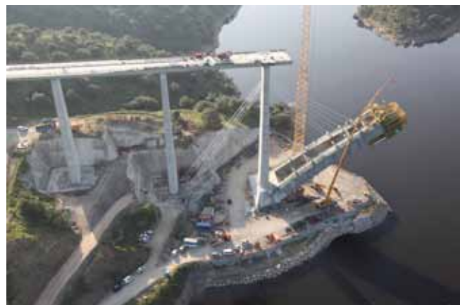
Figs. 14 y 15. Vistas de la ejecución en voladizo de los arcos con atirantamiento provisional (fuente: Eduardo Rojo, A&A y FCC)
