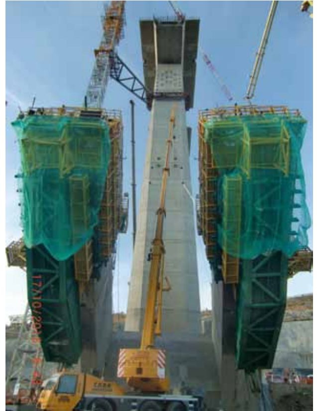
Figs. 10 y 11. Ejecución de pilas y tablero. Carros de avance de arcos (fuente: Ignacio Meana Martínez, ADIF)
