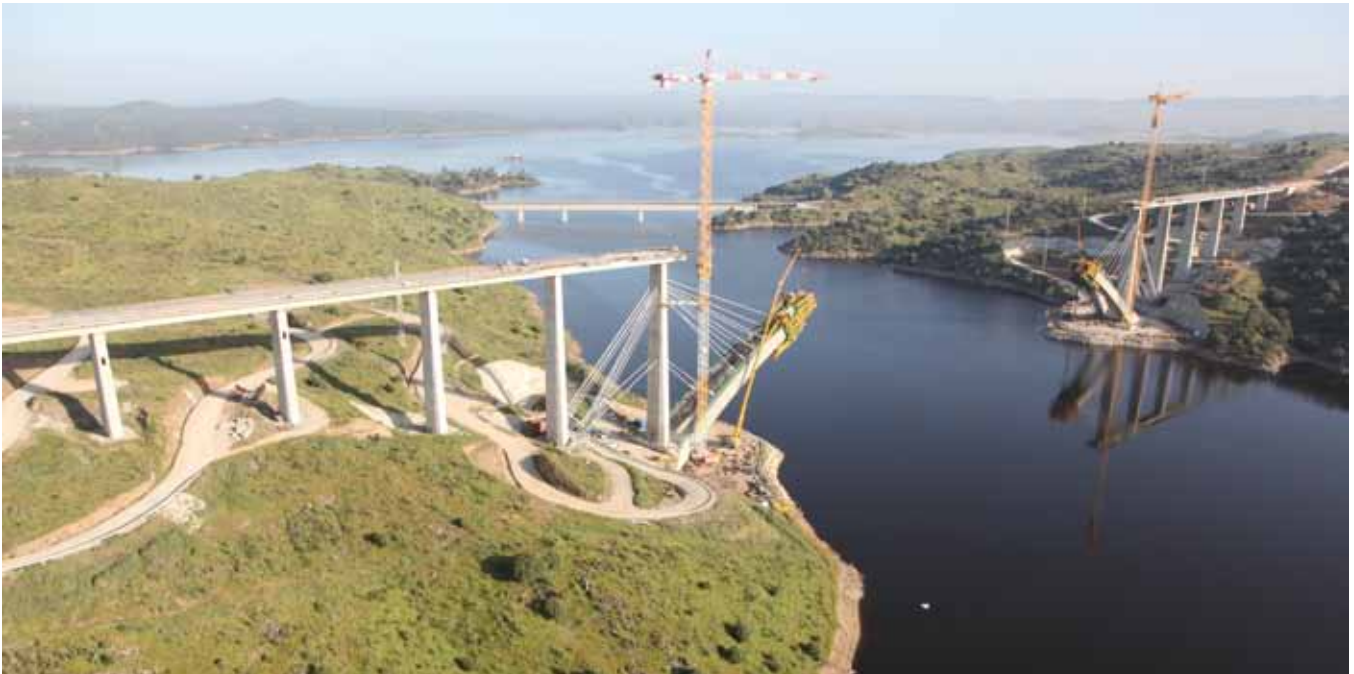
Fig. 13. Vista aérea general de la ejecución del viaducto sobre el río Almonte (fuente: FFCC)
