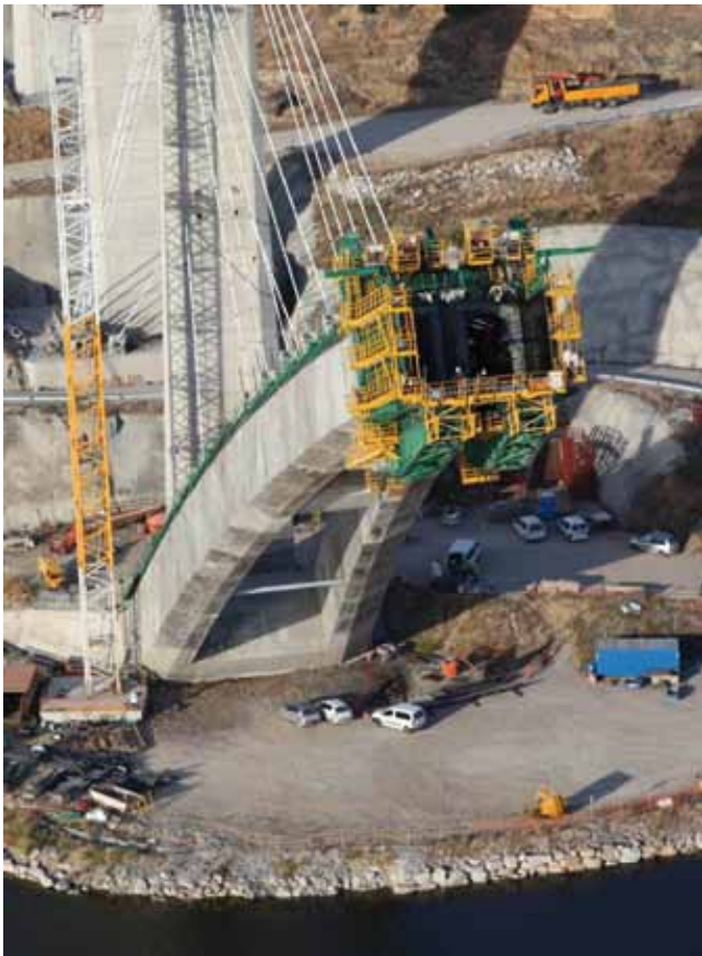
Figs. 14 y 15. Vistas de la ejecución en voladizo de los arcos con atirantamiento provisional (fuente: Eduardo Rojo, A&A y FCC)
