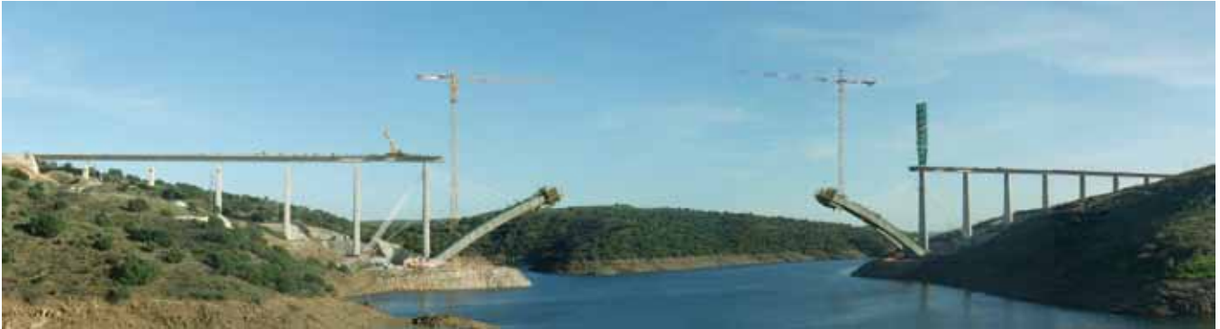
Fig. 12. Vista panorámica del estado actual de las obras (Fuente: Eduardo Rojo)
