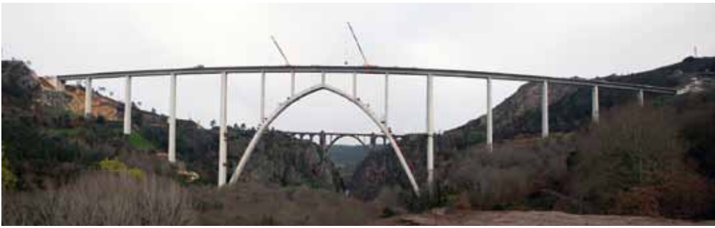
Fig. 1c. Puente sobre el río Ulla (L=179 m)
