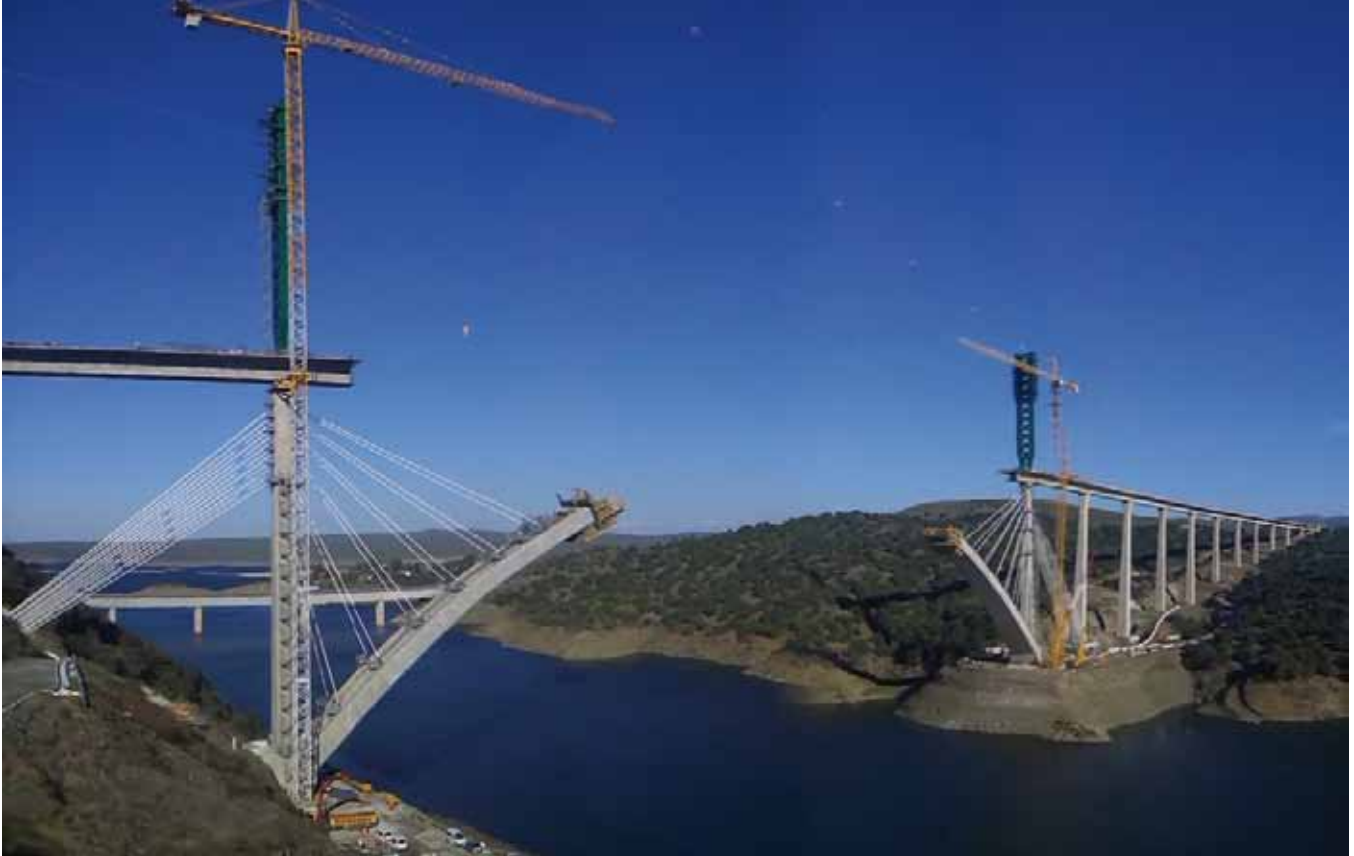
Fig. 8. Vista general del viaducto en construcción
