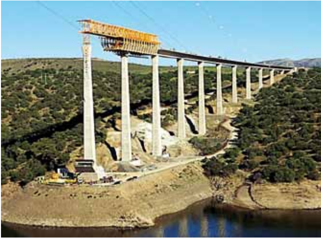
Fig. 5. Ejecución de tablero con autocimbra
