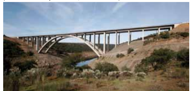
Viaducto de Almonte. (A-66. Tramo Hinojal-Cáceres, Cáceres. 2005)
