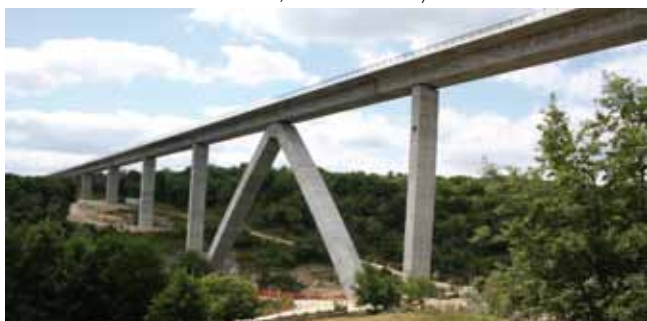
Viaducto sobre el río Arnoia (AVE Madrid-Galicia. Tramo Miamán-Ponte Ambia, Orense. 2013)
