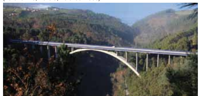
Viaducto del Pintor Fierros (Arco de la Regenta) (Autovía A-8, Ballota, Asturias. 1996)
