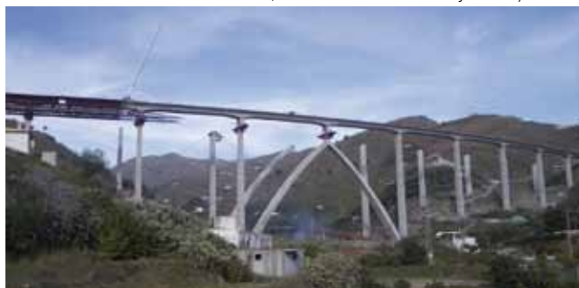
Viaducto del barranco de la Cuesta (Autovía del Mediterráneo. Tramo Almuñecar, La Herradura-Taramay. 2006)
