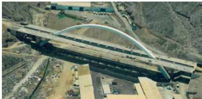
Viaducto de Tamaraceite (GC-2 Acceso Norte, Las Palmas, Gran Canaria. 1994)
