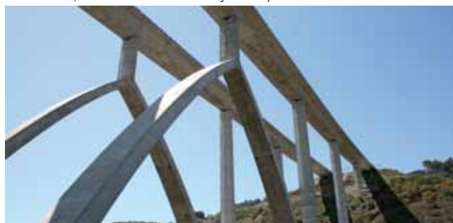
Viaducto del Seco (Autovía del Mediterráneo. Tramo Almuñecar, La Herradura-Taramay. 2006)
