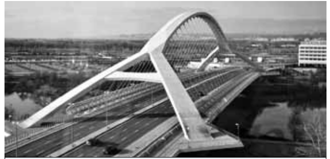
Puente del Tercer Milenio (Zaragoza. 2008)
