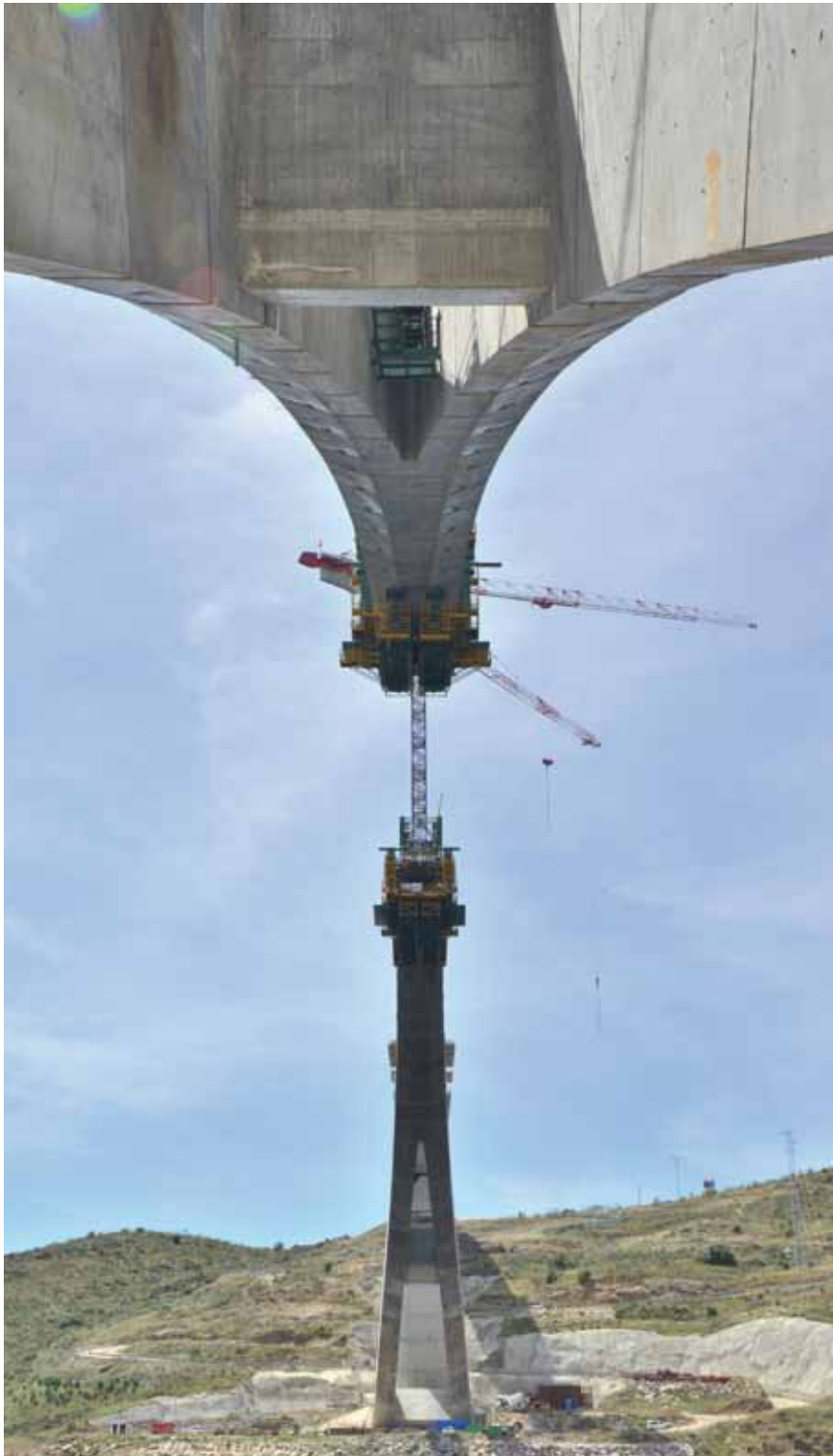
Vista inferior del viaducto
