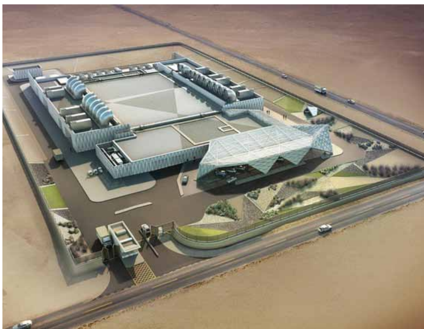
Centro de datos de Qatar Foundation MV2 (Ecisa)
