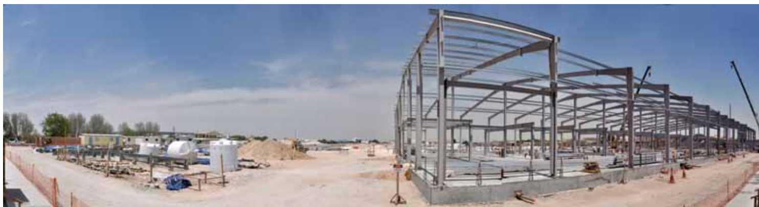
Construcción de instalaciones para trabajadores (Ecisa)
