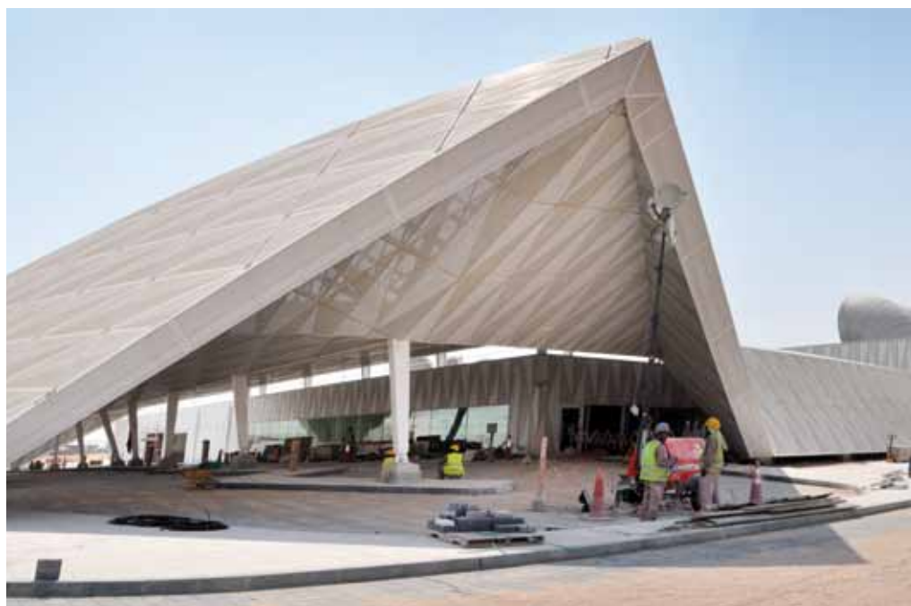
Centro de datos de Qatar Foundation MV2 (Ecisa)
