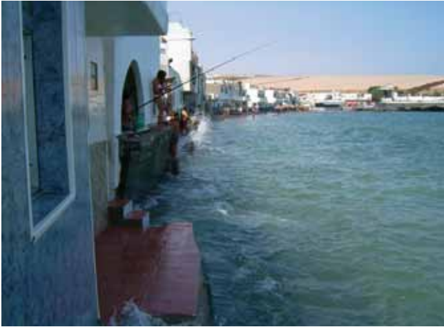
Edificación junto al mar
