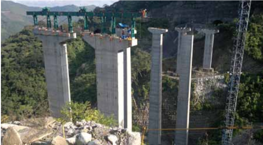
Autopista Nuevo Nexaca (FCC)
