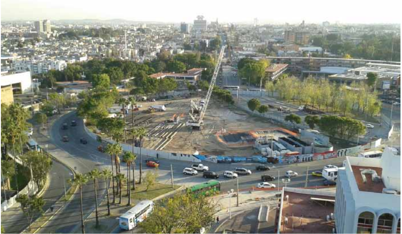
Construcción de la línea 3 del tren ligero de Guadalajara (Sacyr)
