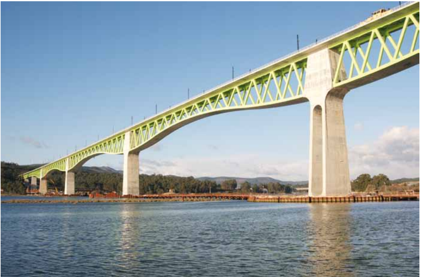
Fig. 8. Vista del viaducto concluido
