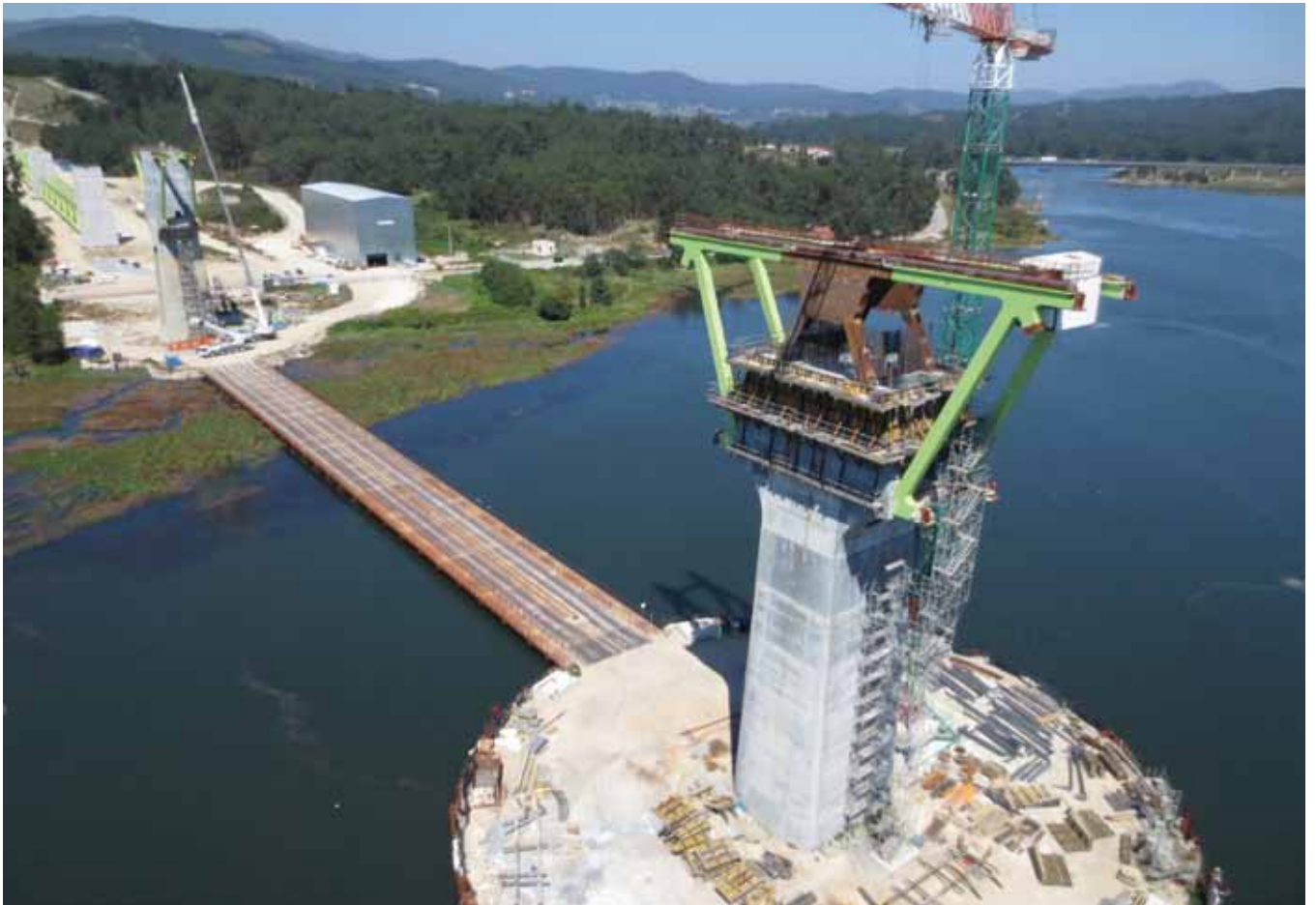
Fig. 6b. Ejecución del cabecero de hormigón
