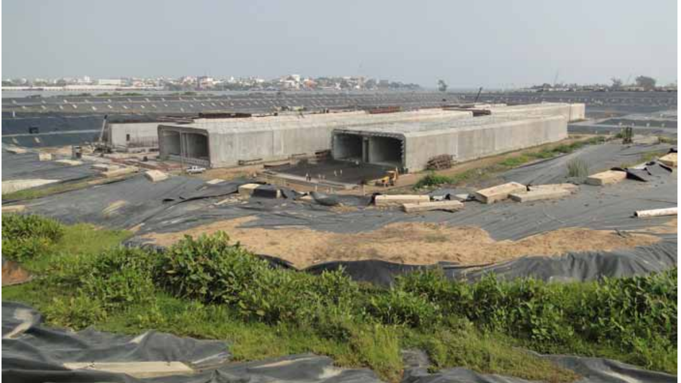
Proyecto del túnel sumergido del río Coatzacoalcos, en el Estado de Veracruz (FCC)
