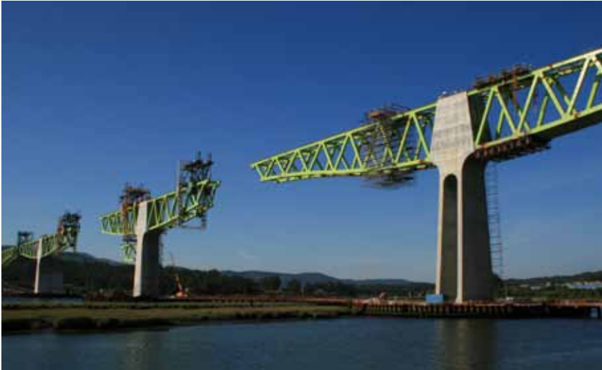
Fig. 7. Vista del avance por voladizos sucesivos
