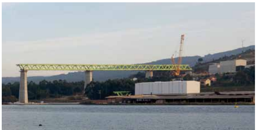
Figs. 3a, 3b y 3c. Fase I, Fase II y Fase III del proceso constructivo.
