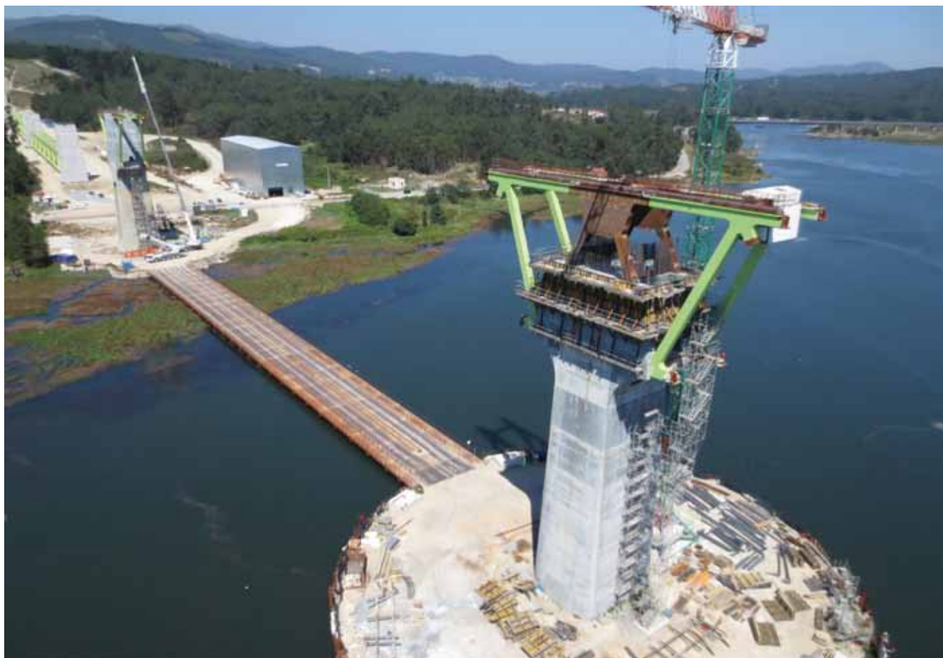
Fig. 6b. Ejecución del cabecero de hormigón
