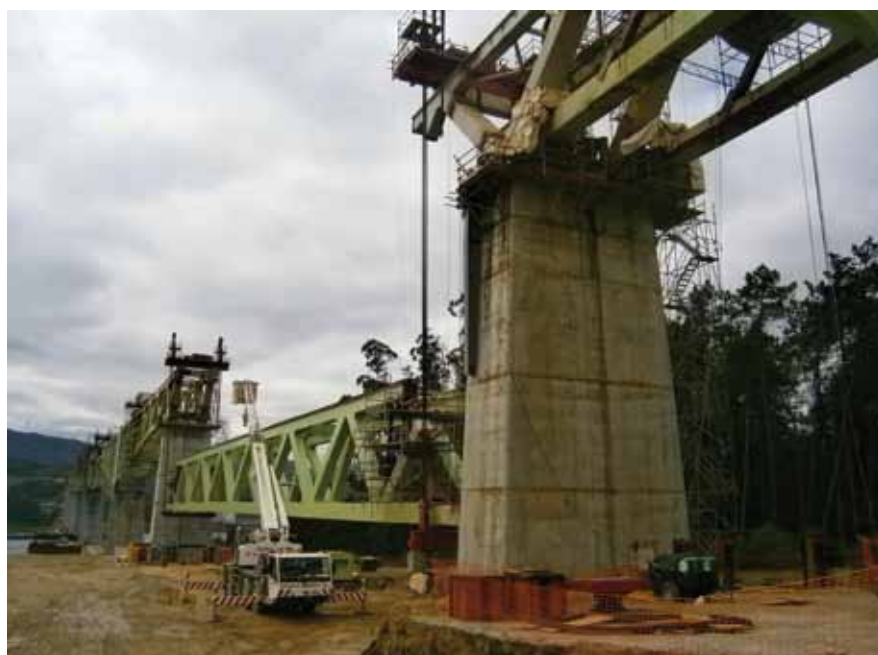
Figs. 4a, 4b y 4c. Secuencia del proceso de izado de los vanos laterales 10, 11 y 12, vista del izado del vano 12 y del vano 10
