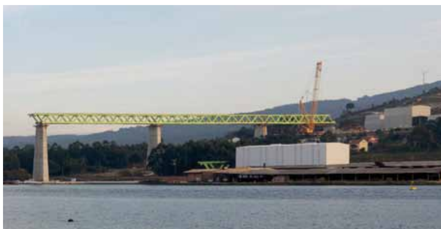
Figs. 3a, 3b y 3c. Fase I, Fase II y Fase III del proceso constructivo.
