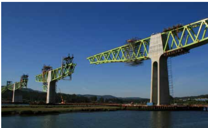
Fig. 7. Vista del avance por voladizos sucesivos
