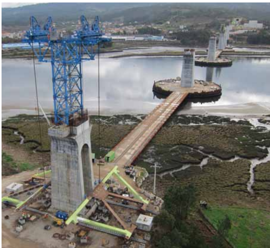
Fig. 6a. Verticalizado de la W de cabeza de pilas centrales
