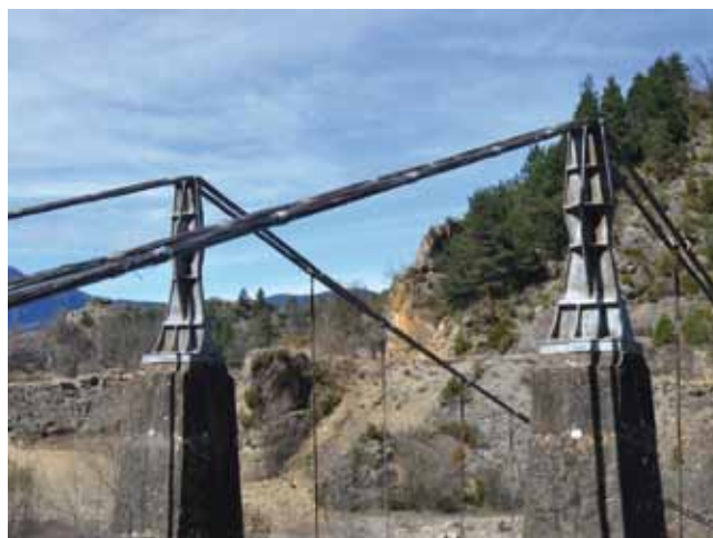
Fig. 11. Piezas de fundición de las torres
