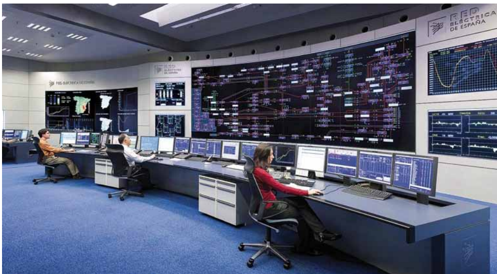
Fig. 3. Centro de control (CECOEL) de Red Eléctrica de España
