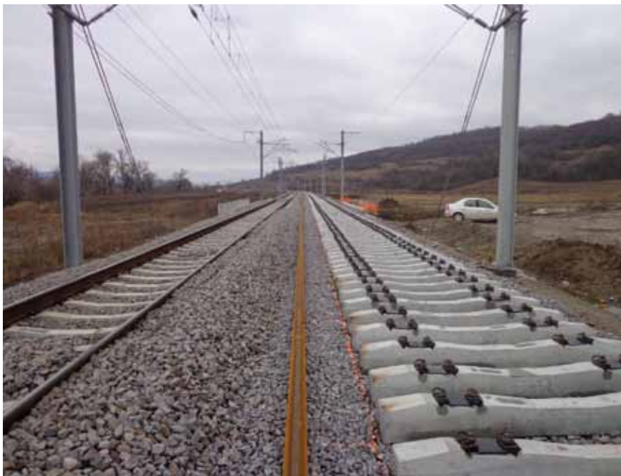
Infraestructura ferroviaria (Azvi)
