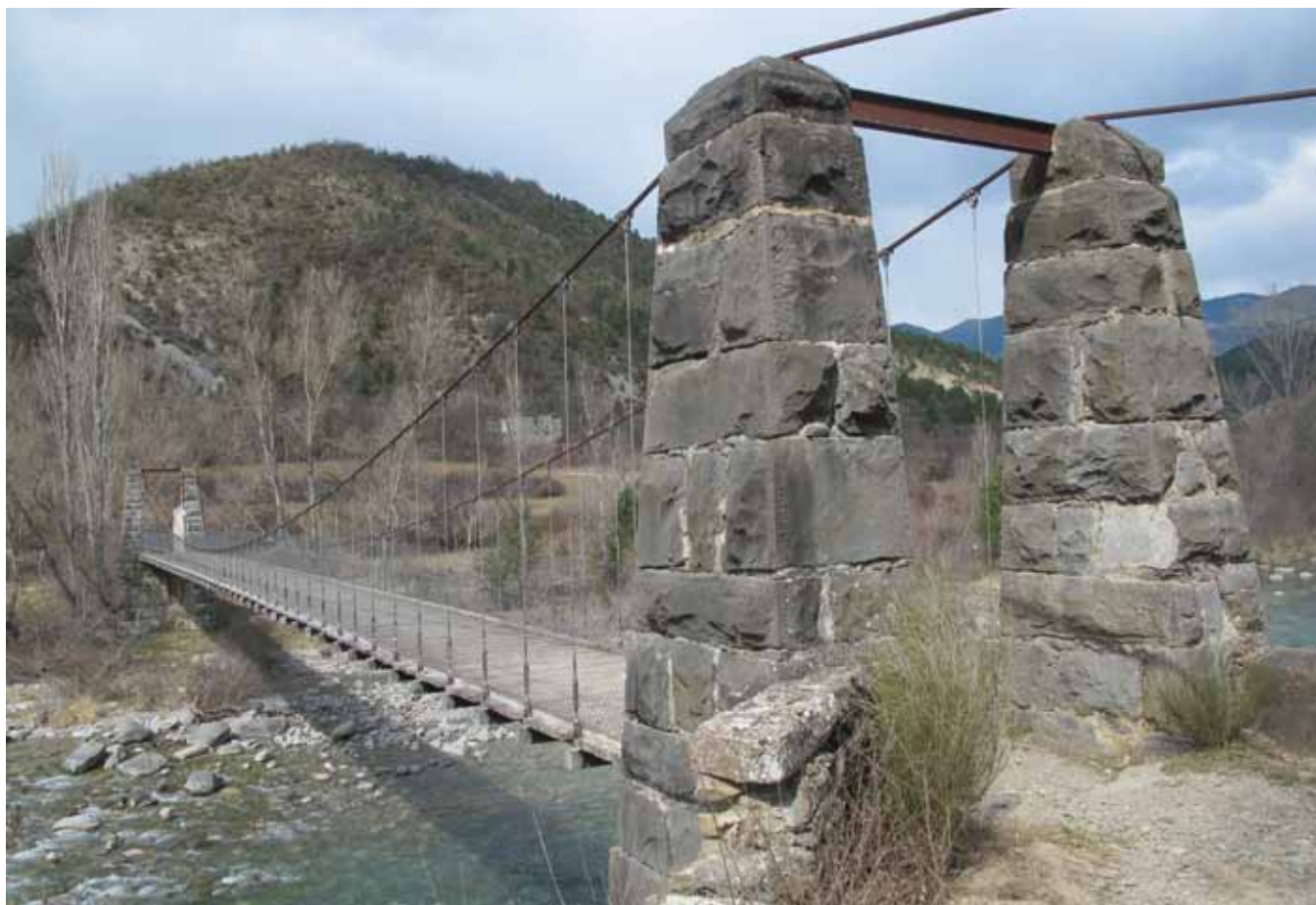
Fig. 12. El tablero de madera
