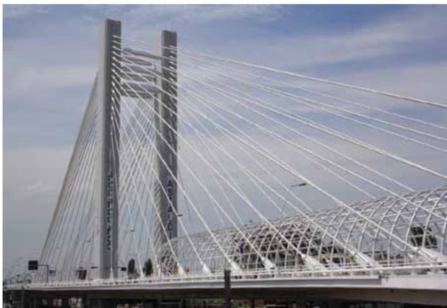
Viaducto de Basarab (FCC)
