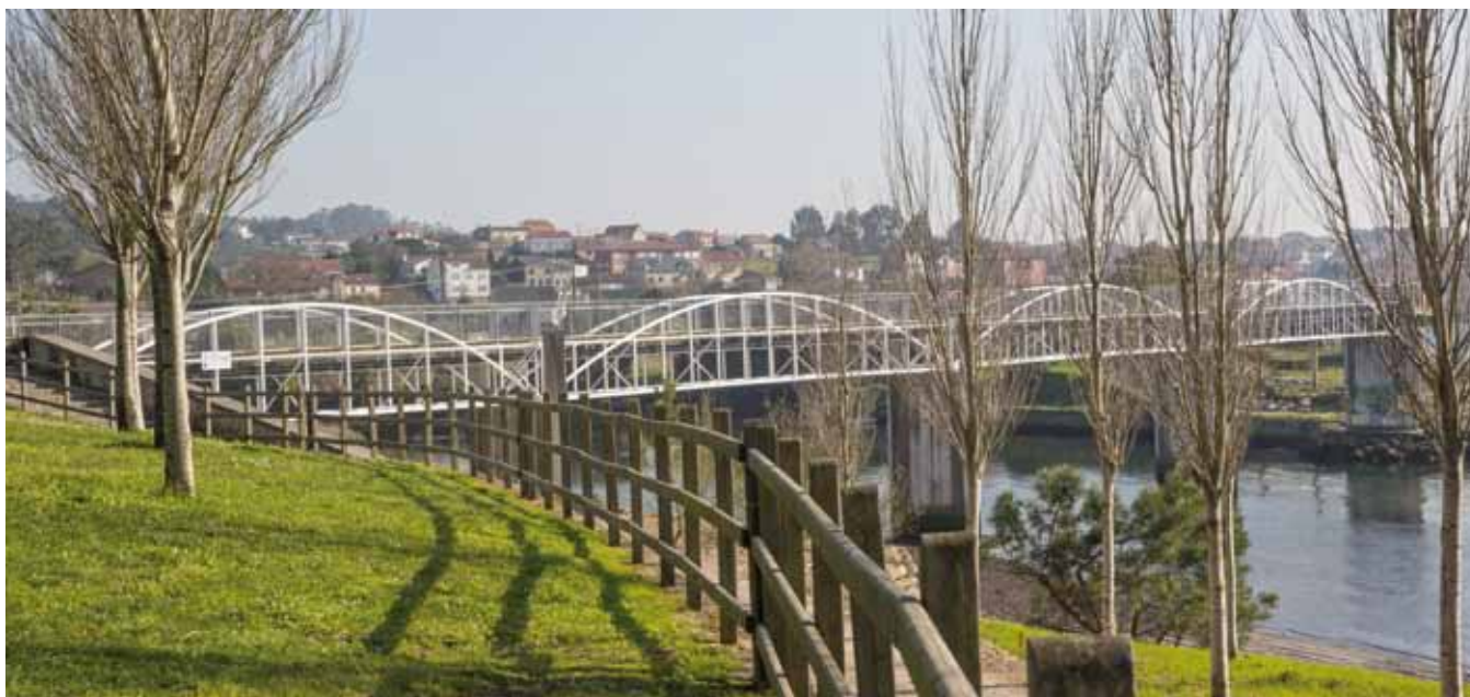
Fig. 2. Vista General de la pasarela terminada
