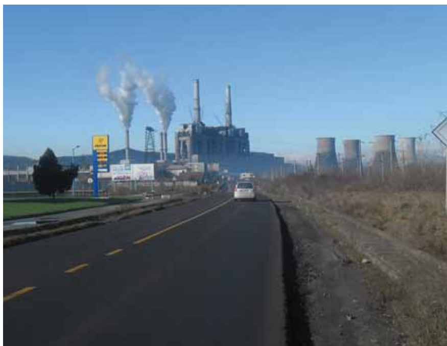
Rehabilitación de una parte de la carretera nacional DN-66 (Comsa-Emte)
