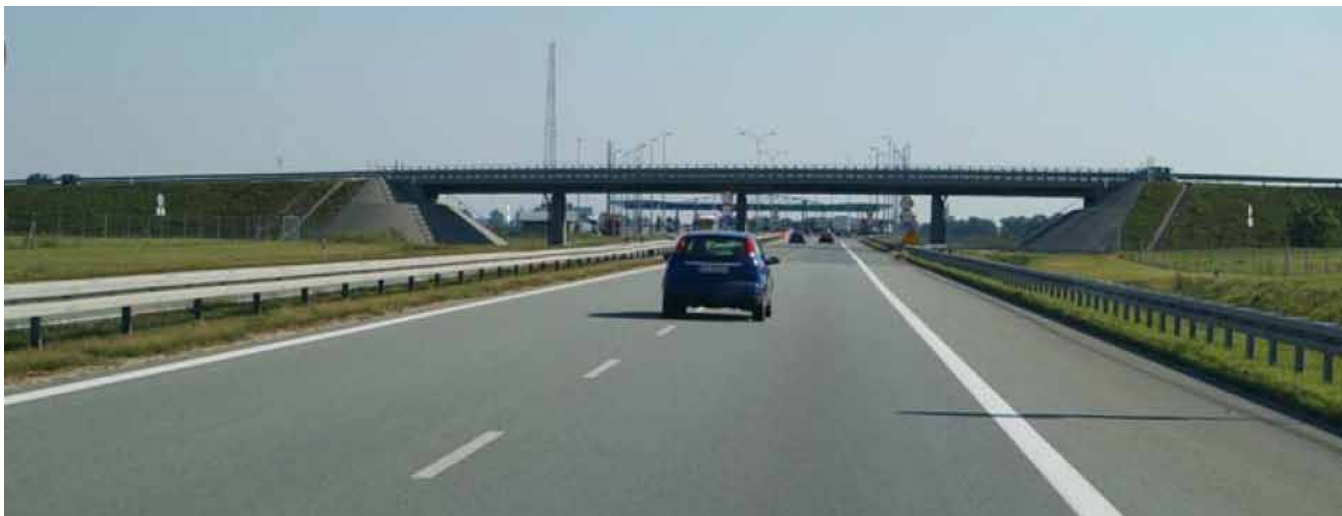
Autopista Arad-Timisoara (FCC)
