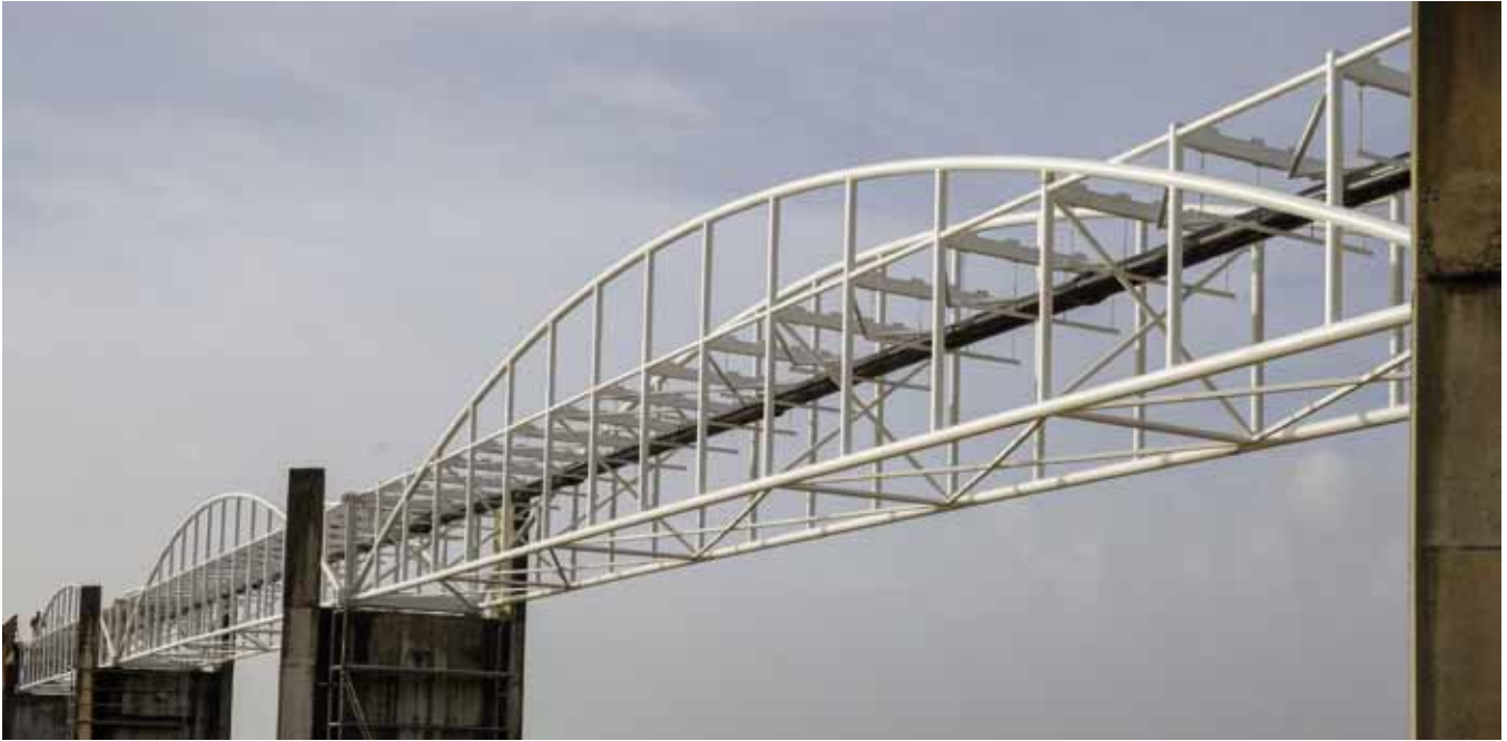
Fig. 5. Esqueleto estructural metálico
