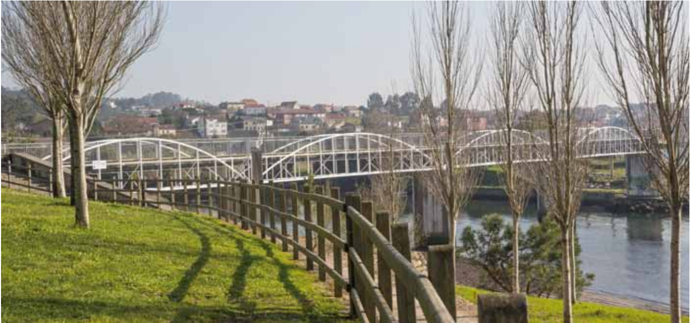
Fig. 2. Vista General de la pasarela terminada
