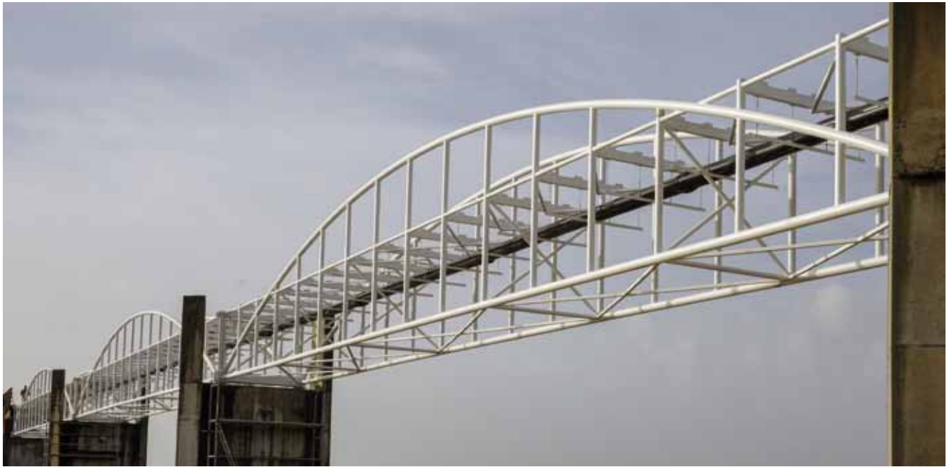
Fig. 5. Esqueleto estructural metálico
