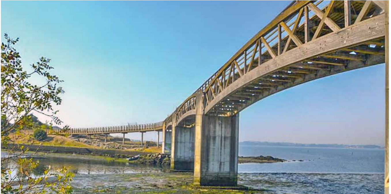
Fig. 1. Vista general de la pasarela de madera con la rampa de acceso en Rianxo
