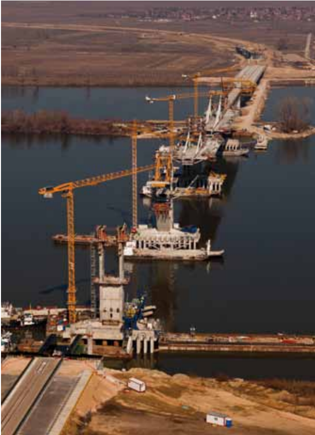
Proceso de construcción
