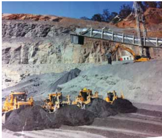
Detalle del extendido de material en la cantera
