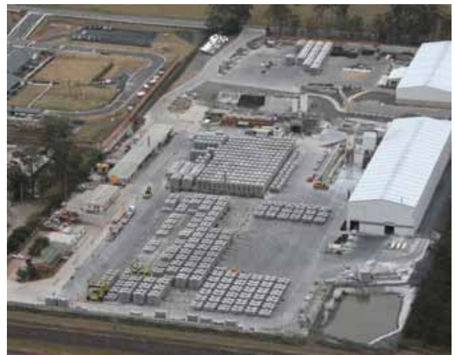
Planta de fabricación de dovelas de revestimiento
