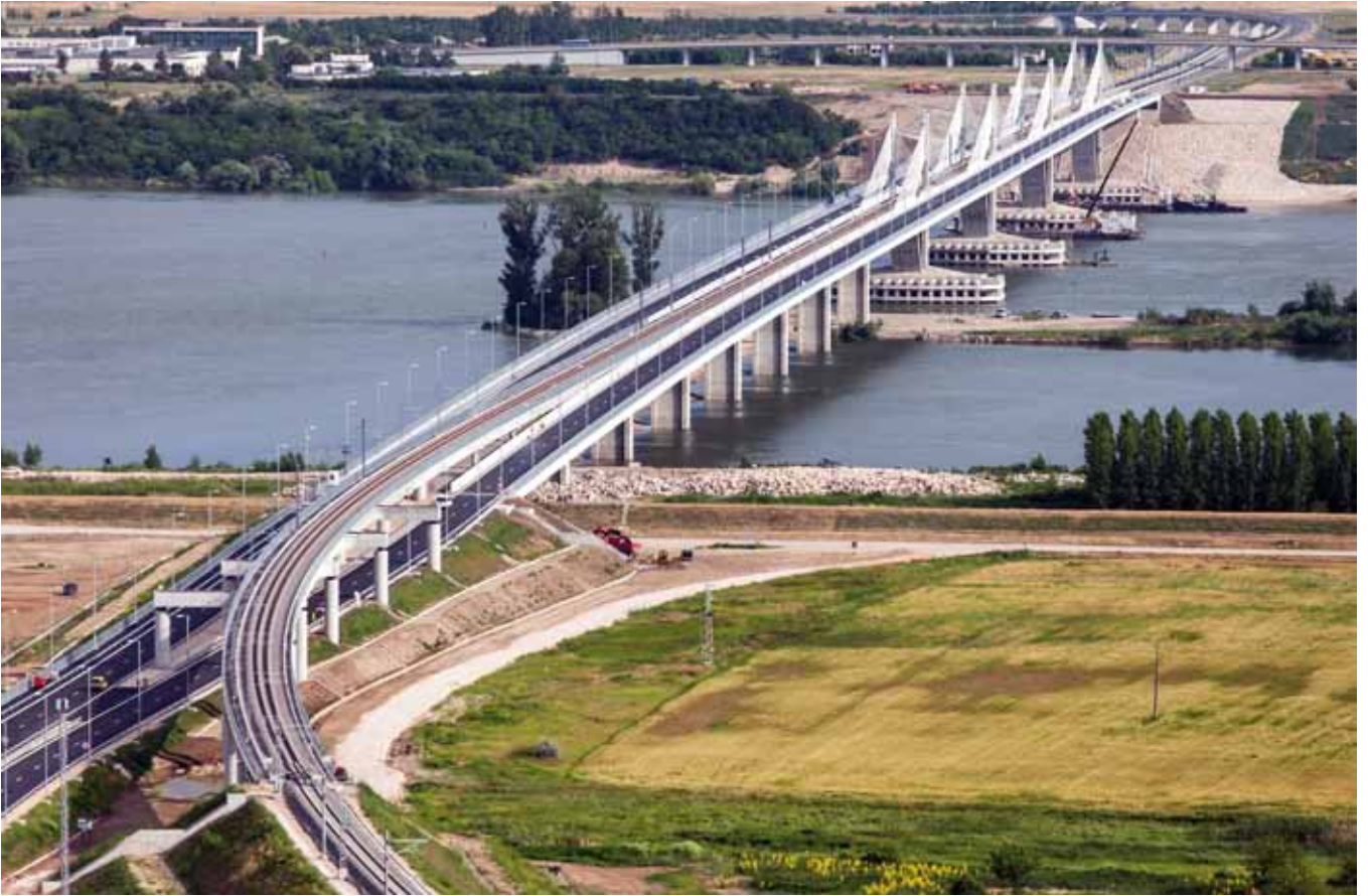
Puente sobre el danubio. Obra acabada
