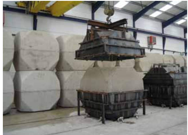
Prefabricación de bloques de hormigón
