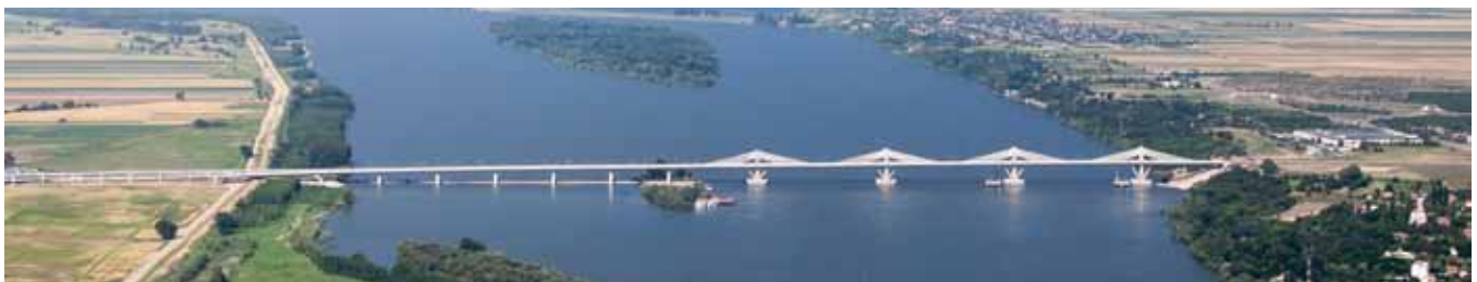
Vista del puente aguas abajo
