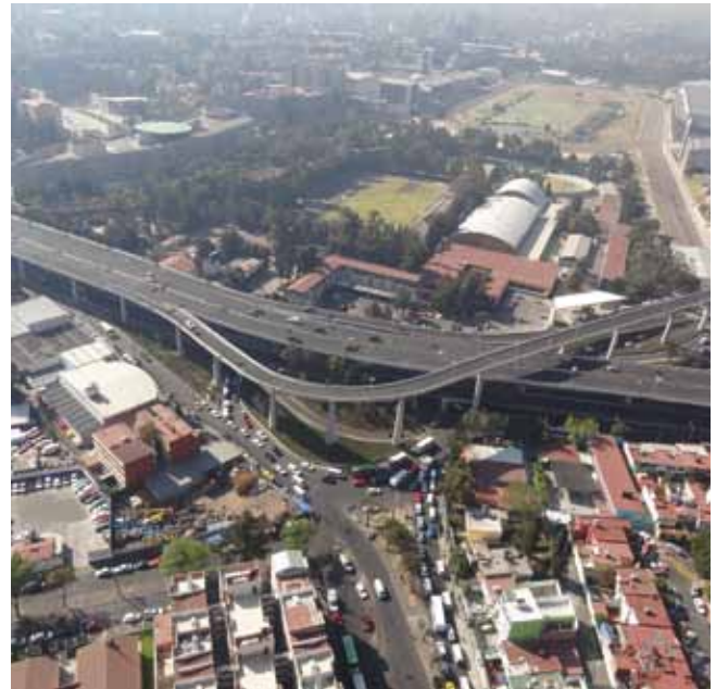
Distribuidor Vial Conscripto, columnas a doble altura y trazo a 90°
