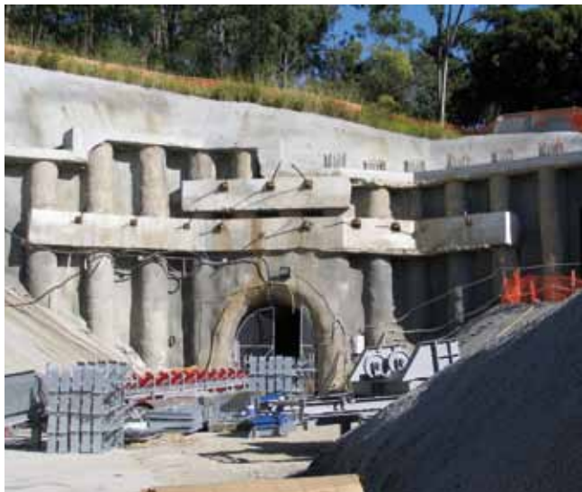
Boca del túnel para ubicación de la cinta de descombro
