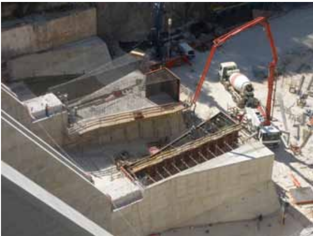
Ejecución de las nuevas cámaras de desagüe de fondo
