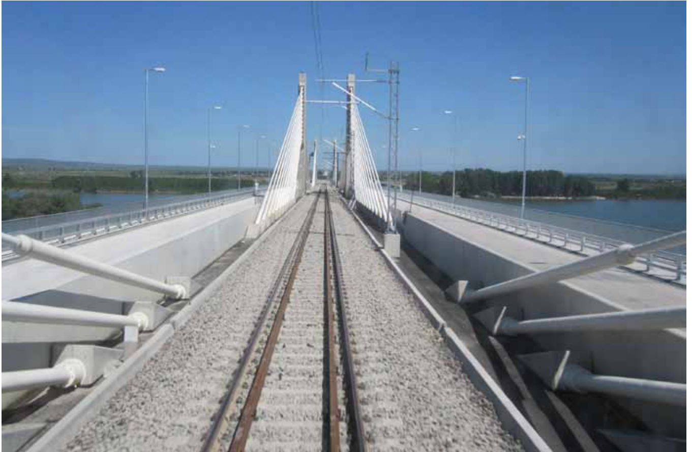
Vías en tramo de puente
