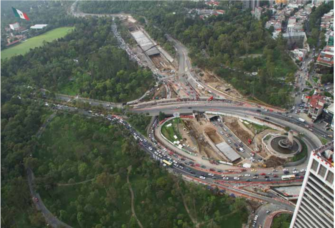
Panorámica general de la construcción del falso túnel, Distribuidor Vial Reforma
