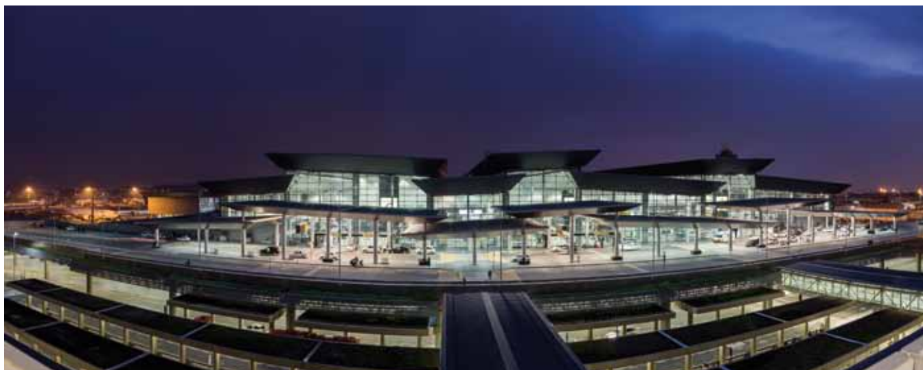
Fig. 1. Fachada principal Edificio Terminal 3
