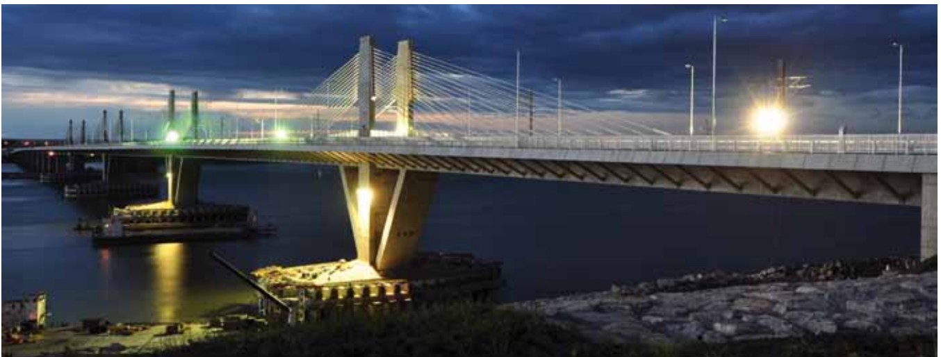
Vista nocturna del viaducto en avanzado estado de construcción
