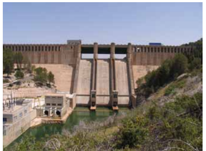
Vista general de la presa desde aguas abajo. Estado inicial
