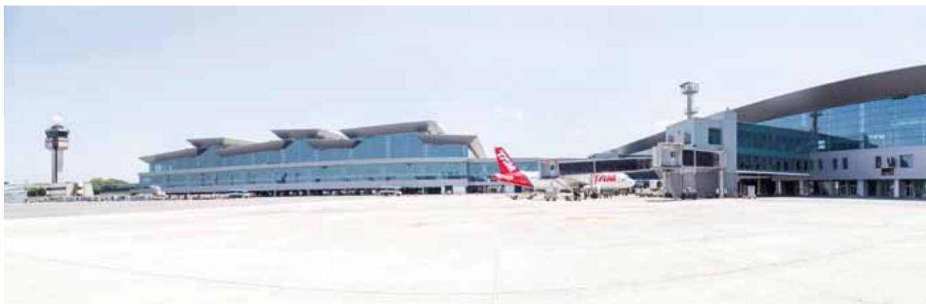
Fig. 3. Vista Edificio Terminal 3 desde plataforma de estacionamiento de aeronaves
