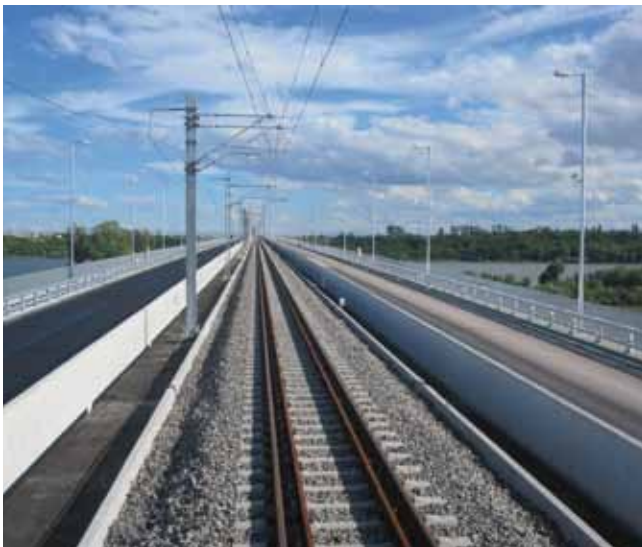
Vías entre calzadas
