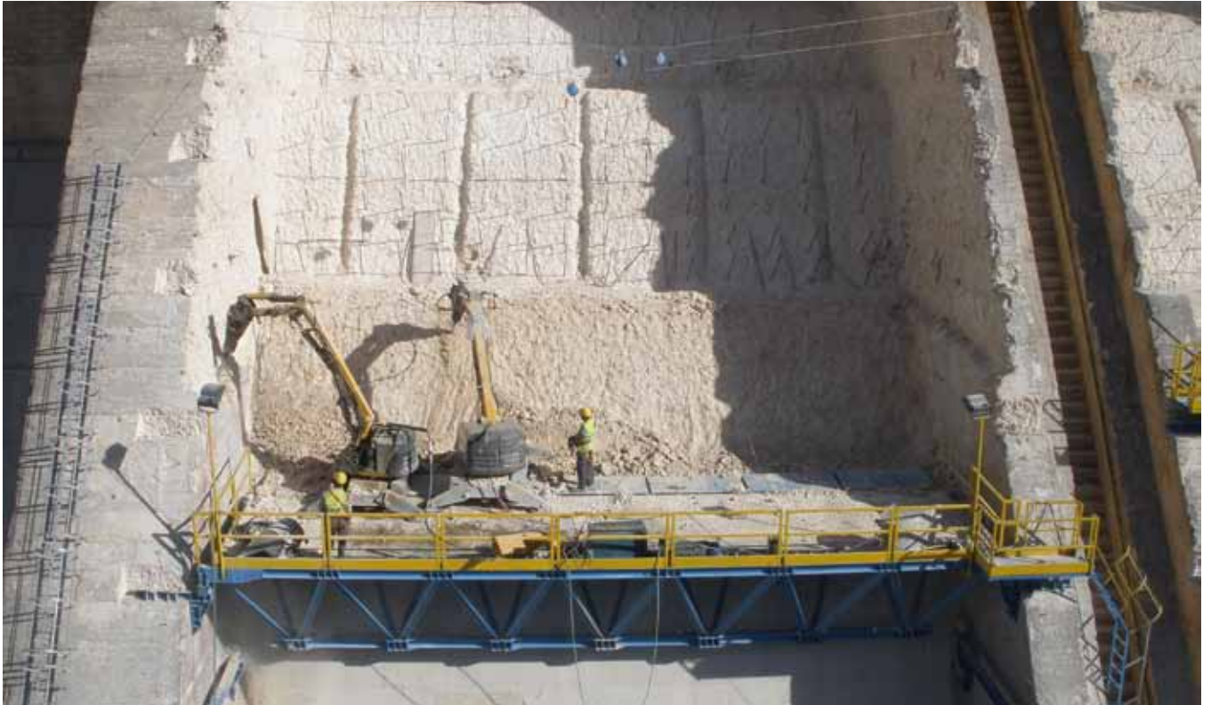
Ejecución de la demolición robotizada de uno de los aliviaderos desde la plataforma móvil
