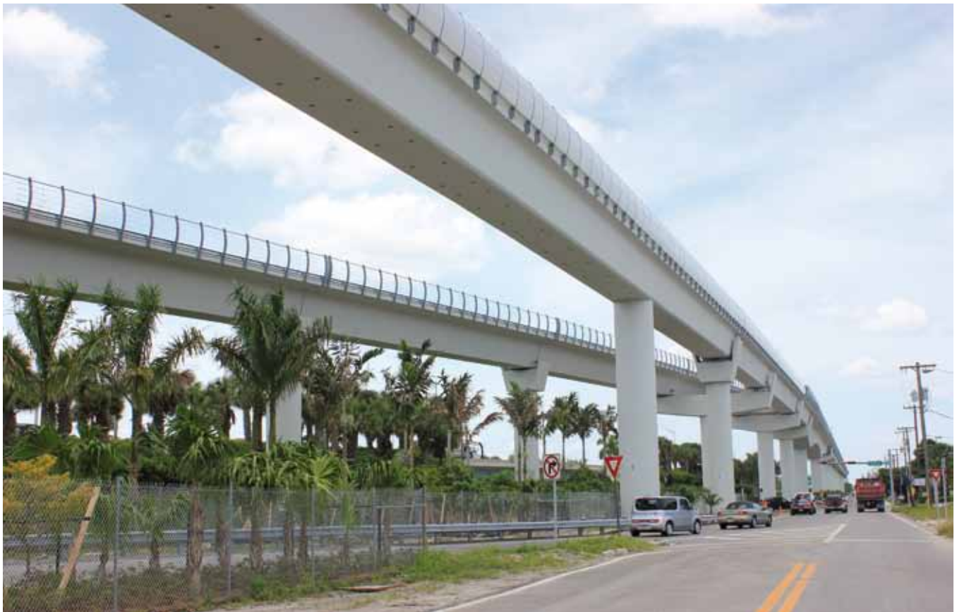
Estructura elevada del vial
