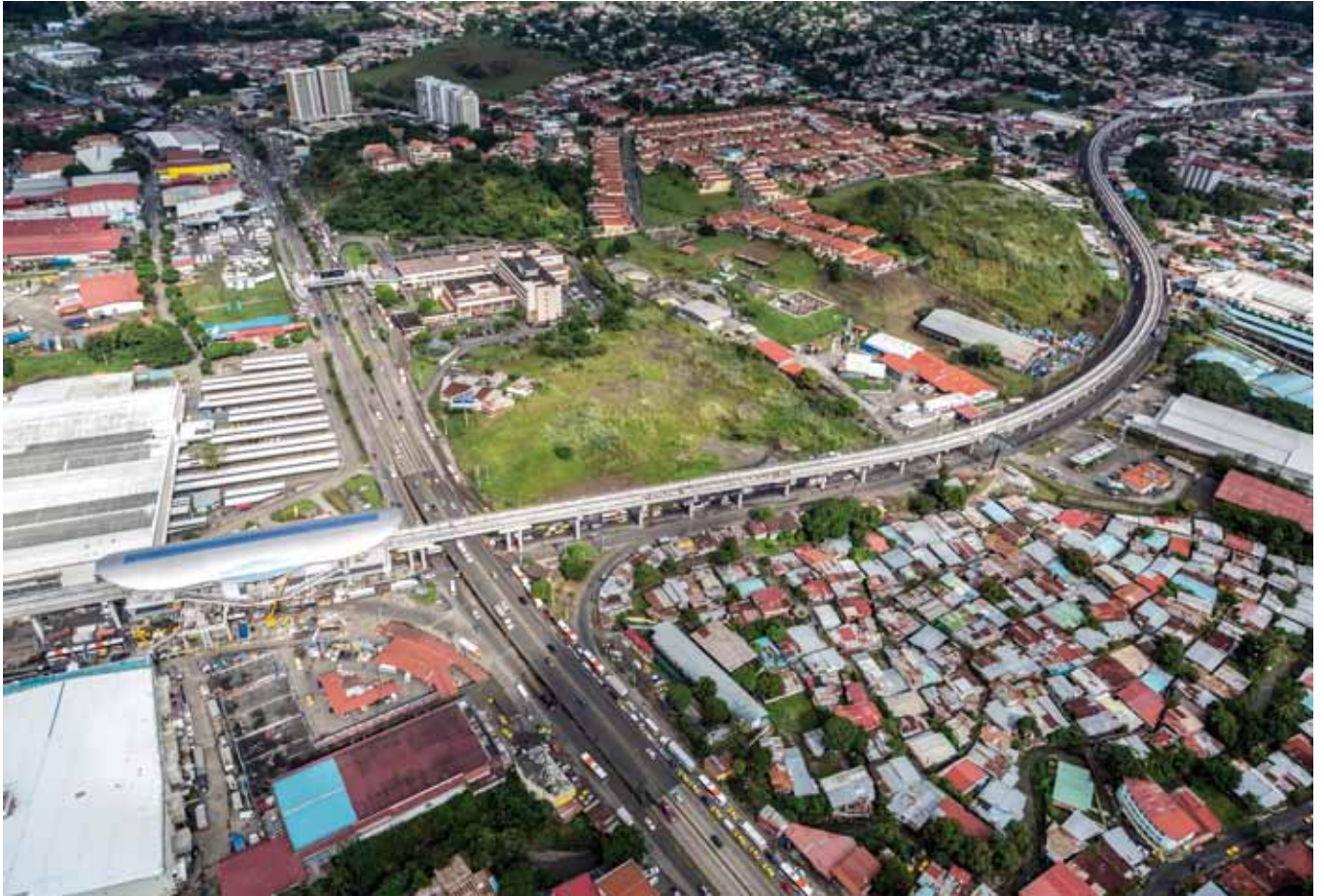
Metro de Panamá. Tramo en superficie
