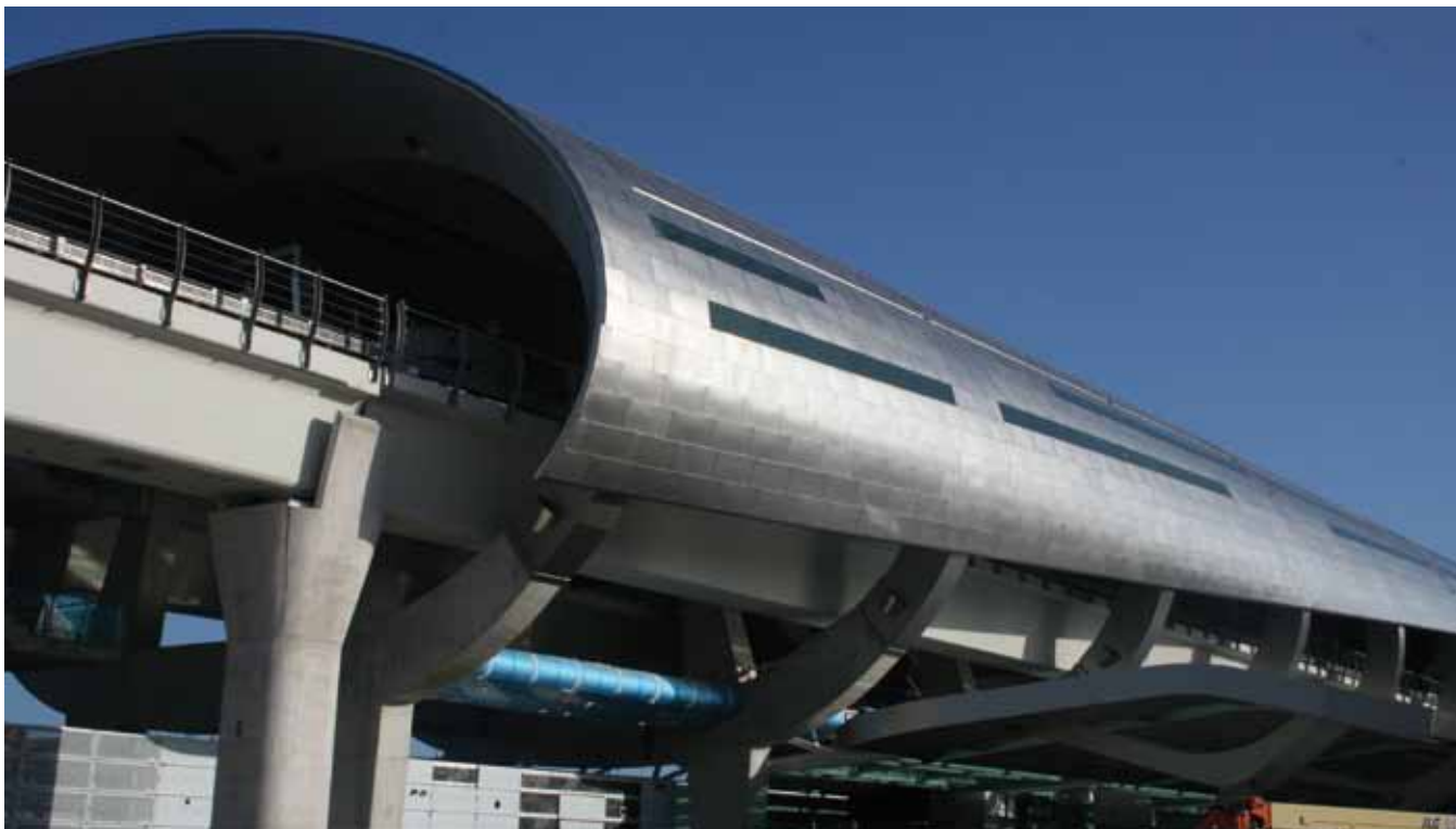
Detalle de infraestructura
