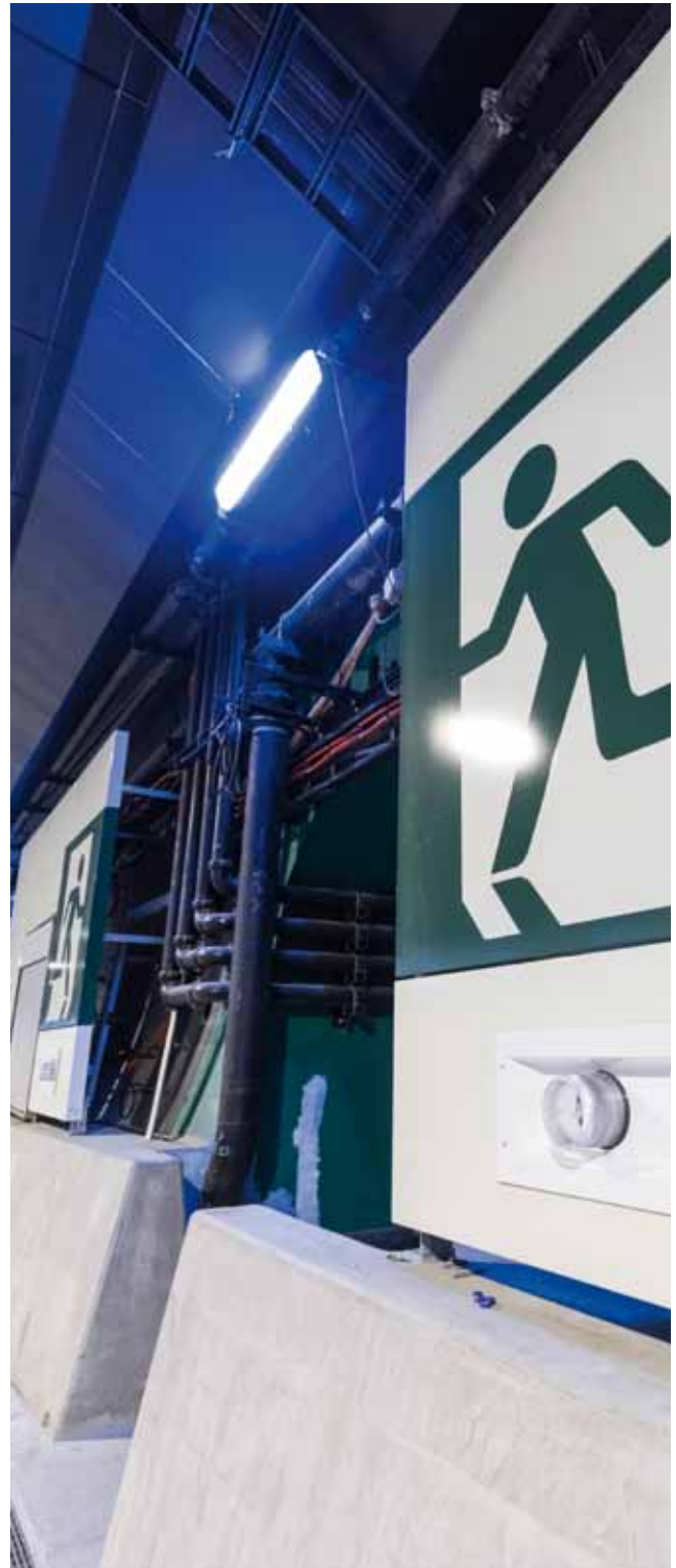
Entrada de galería transversal
