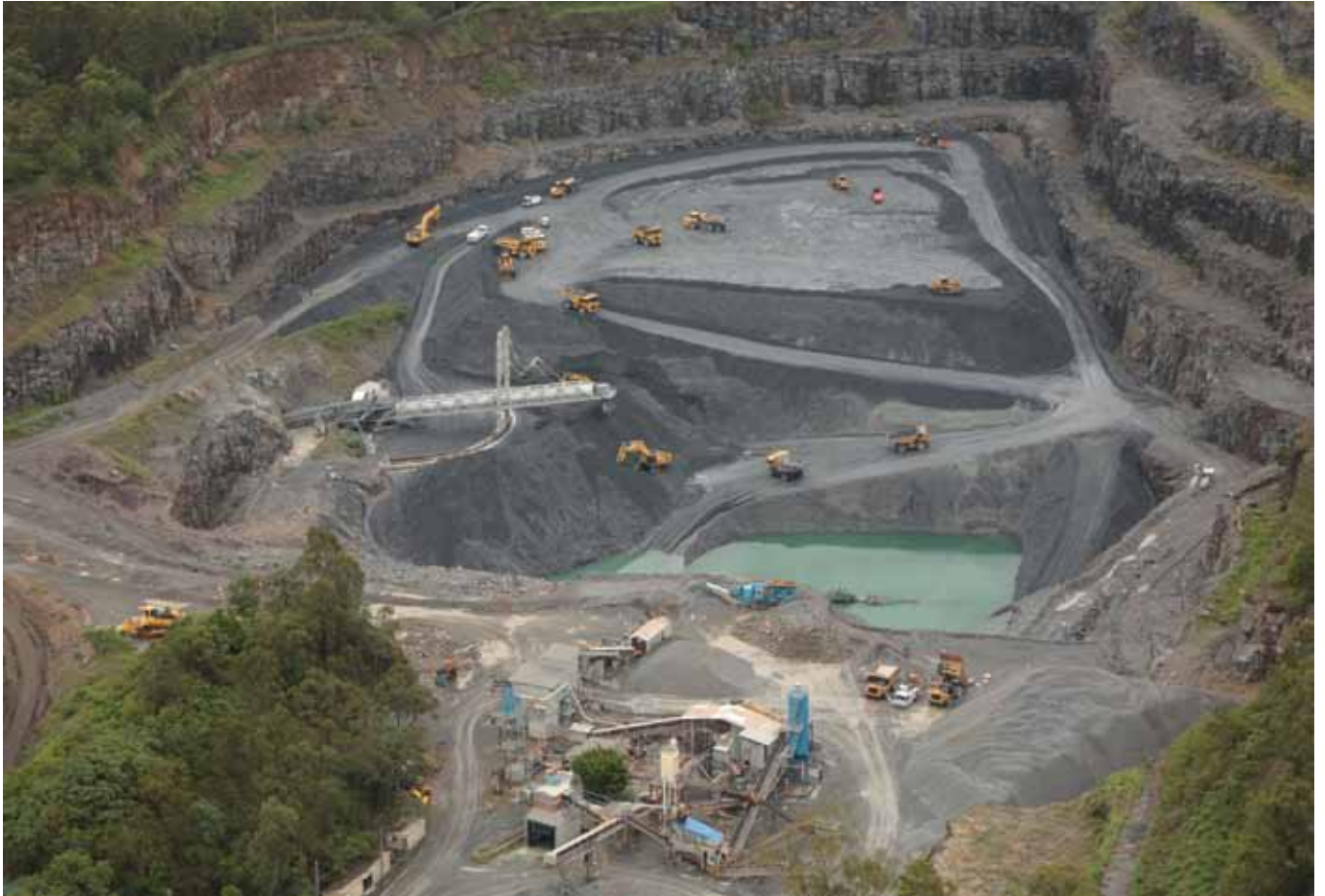
Cinta distribuidora del escombros en la cantera
