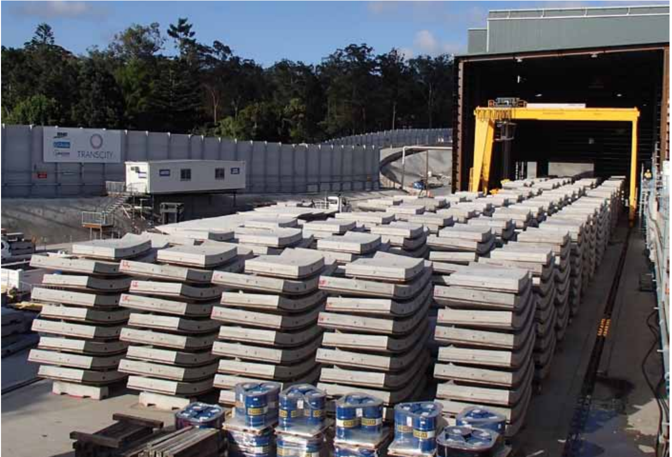
Acopio en portal de arranque de las TBM
