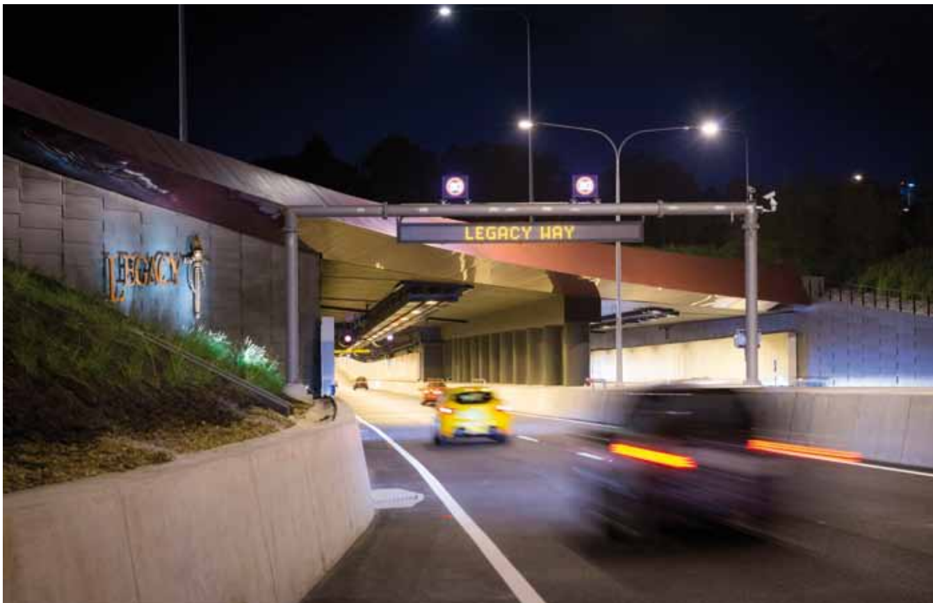
Portal oeste una vez abierto al tráfico
