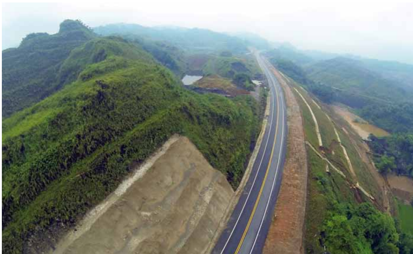
Vista aérea del km 240. Sección Yen Bai-Lao Cai
