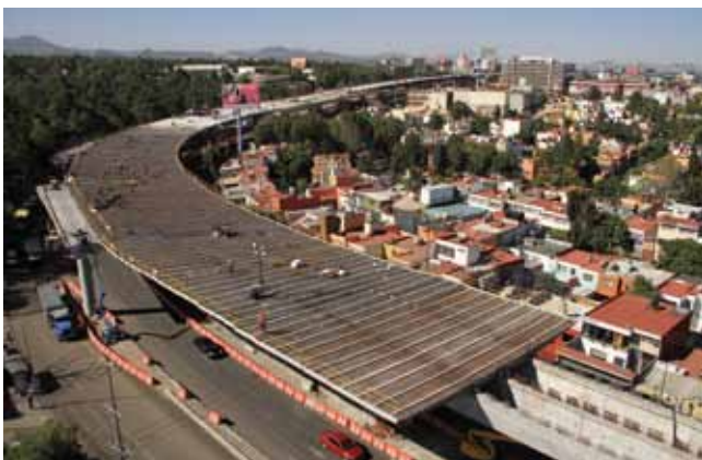
Panorámica de la calzada en fase de construcción
