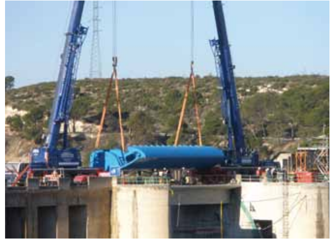
Proceso de colocación de una de las nuevas compuertas Taintor del aliviadero de 40 tn de peso
