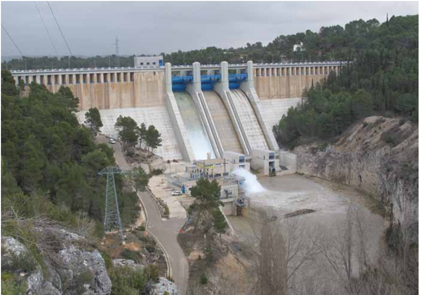
Vista general de la presa desde aguas abajo totalmente rehabilitada y aliviando
