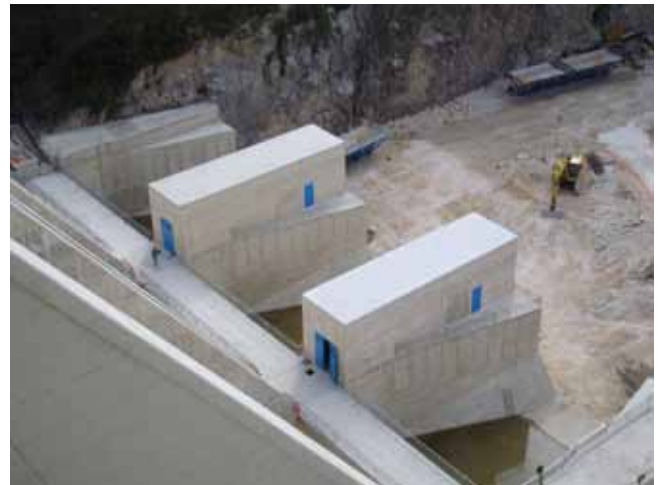
Cámaras de desagües de fondo y trampolín sumergido terminado
