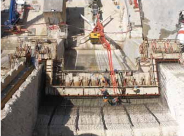
Vista desde arriba de una puesta de encofrado, ferrallado y hormigonado
