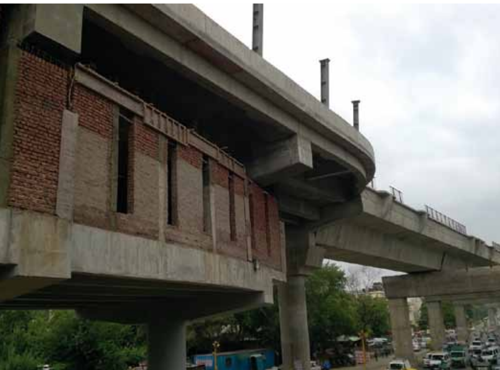
Construcción del metro de Delhi (Ayesa)
