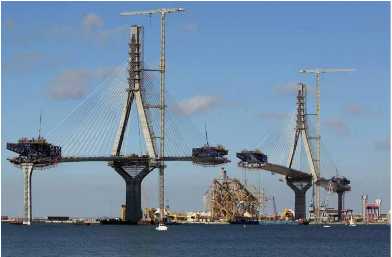
Proceso de construcción. 2014
