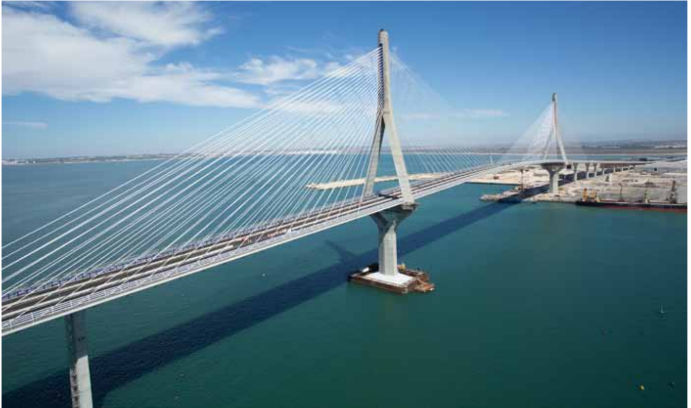
Vista actual del puente
