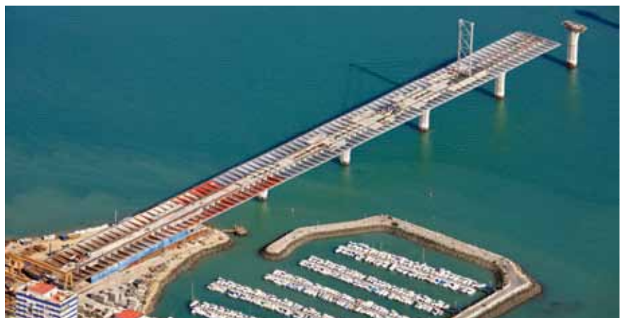
Viaducto de acceso desde Cádiz
