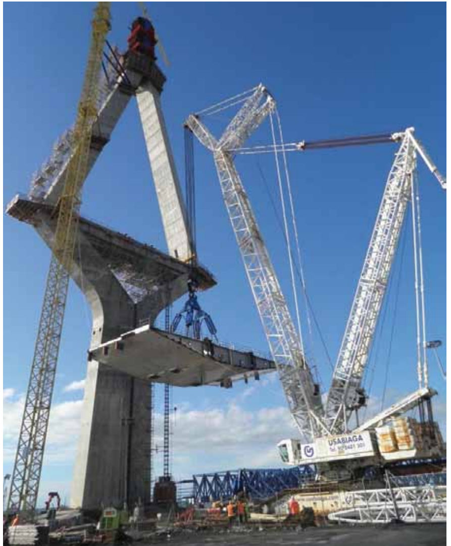
Izado de la primera dovela del tramo atirantado sobre la torre de tierra
