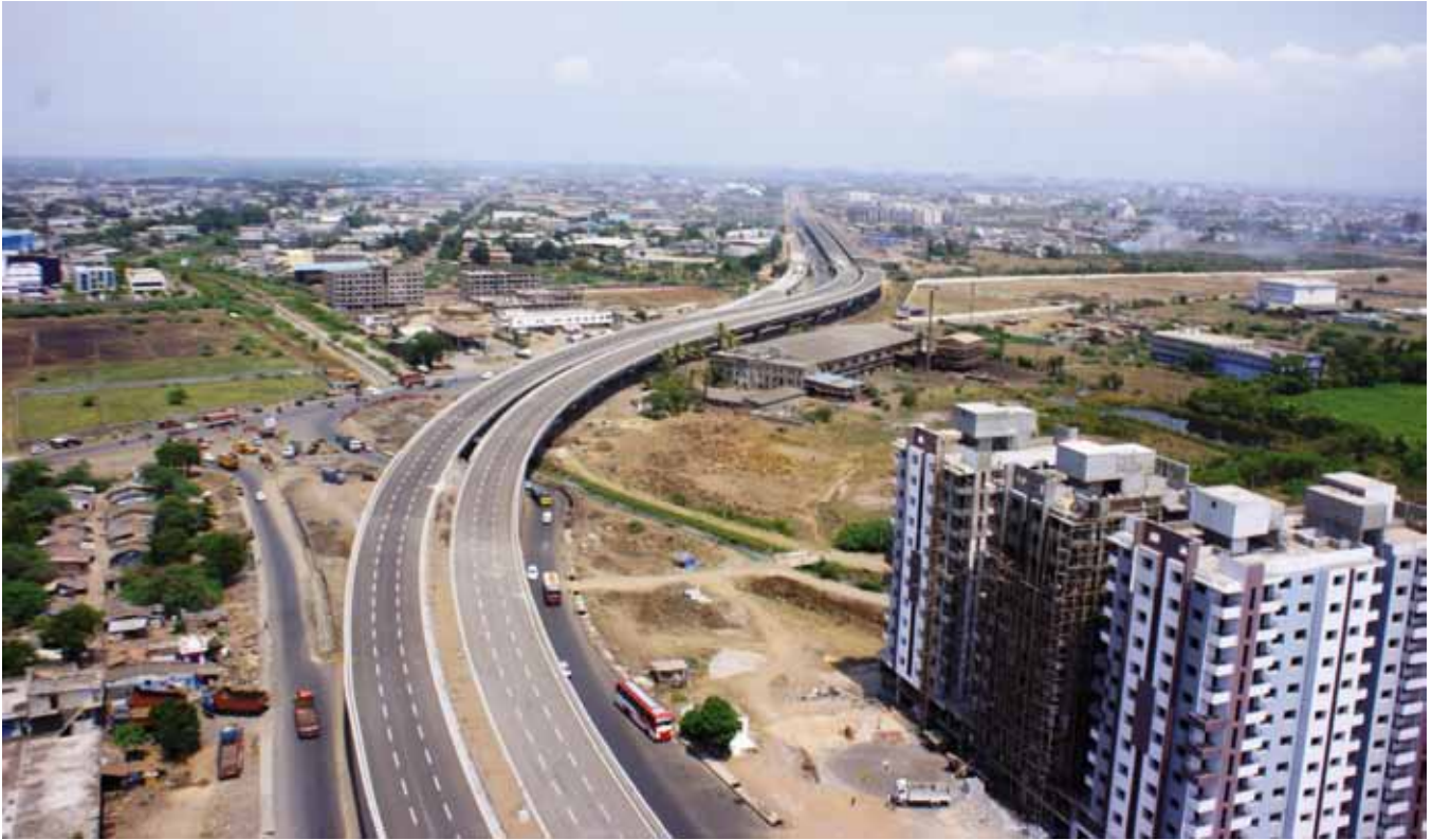
Viaducto Sachin en la autopista NH6 | India (Isolux Corsán)
