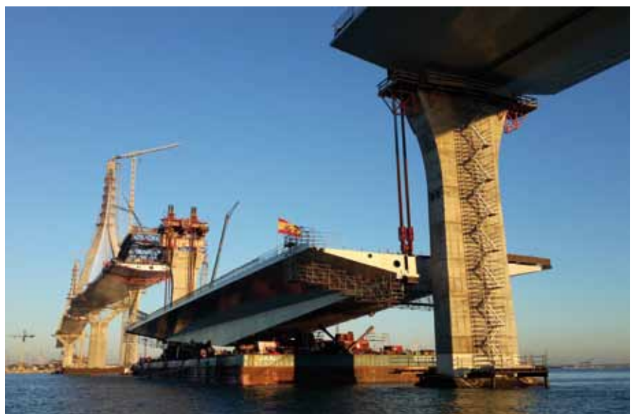
Izado del tramo desmontable
