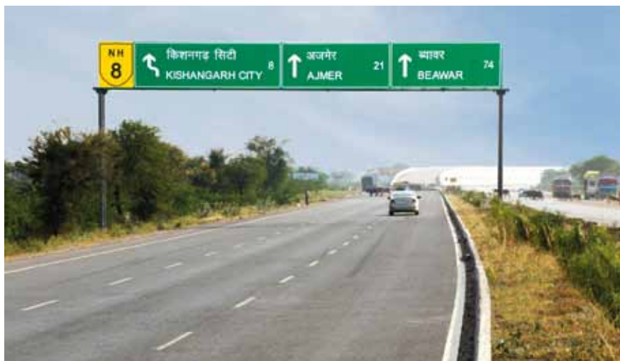
Autopista NH-8 Kishangarh-Ajmer-Beawar, 93,56 km (Isolux Corsán)
