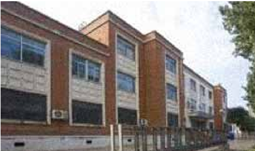
Vista exterior del edificio
