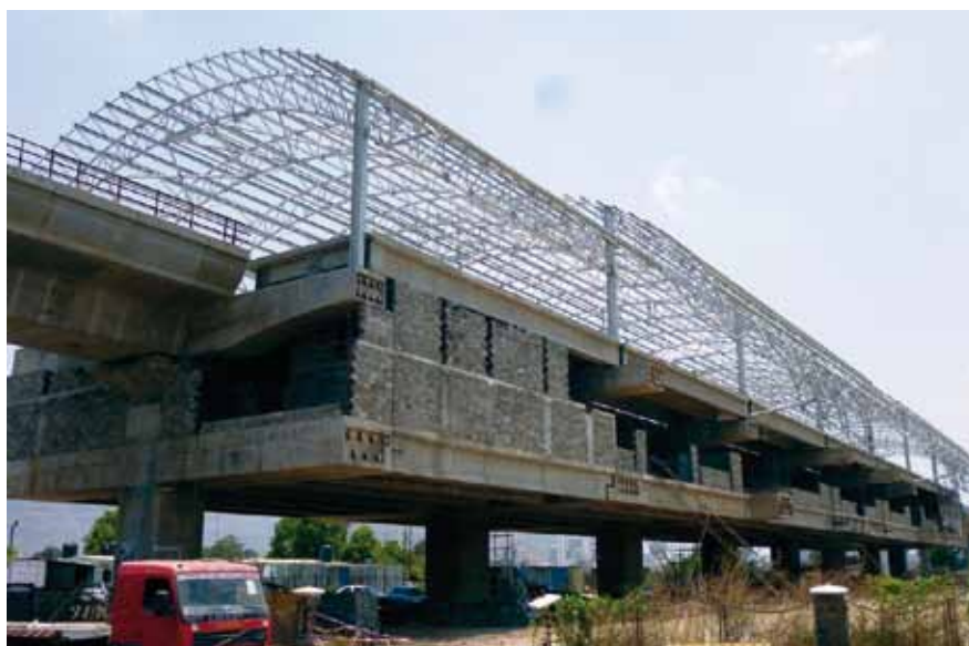
Construcción de una estación del metro de Mumbai (San José)
