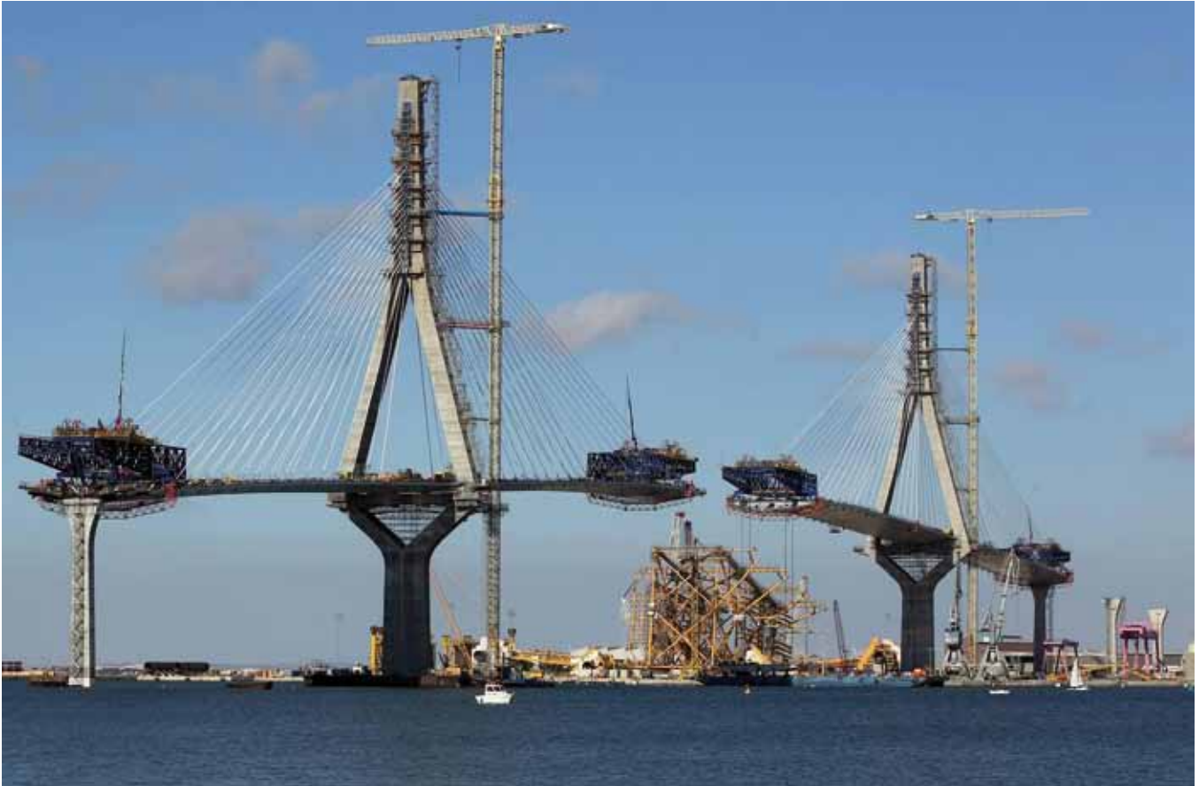
Proceso de construcción. 2014
