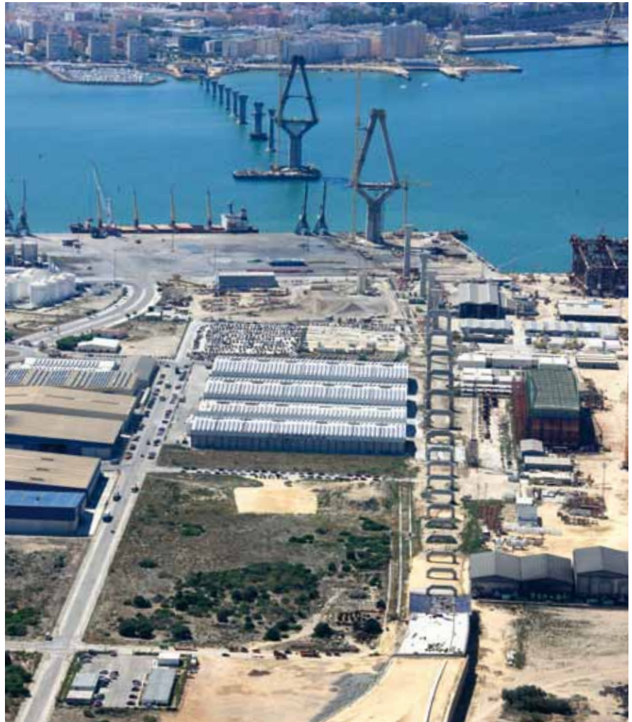
Vista general de todas las pilas del puente
