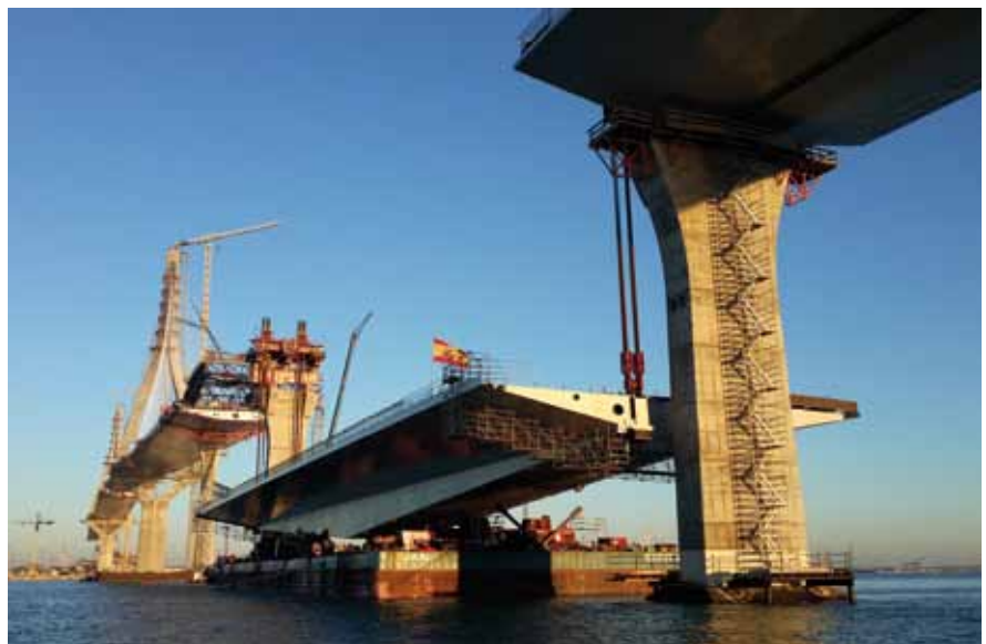
Izado del tramo desmontable
