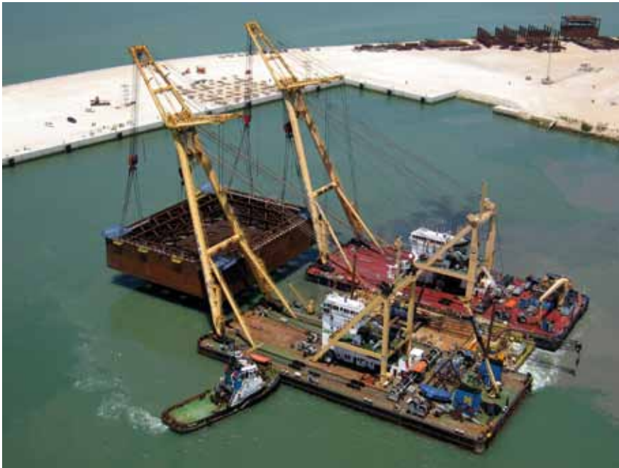
Transporte del recinto estanco de la torre de mar
