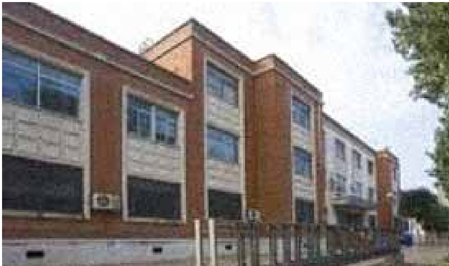
Vista exterior del edificio
