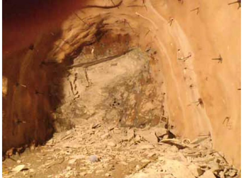
Fig. 27. Estallido en galería próxima a Casa de Máquinas (izda.)
