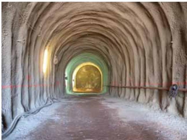
Fig. 9. Túnel conducción-Drive 4 (22 m² y 0,9 %)
