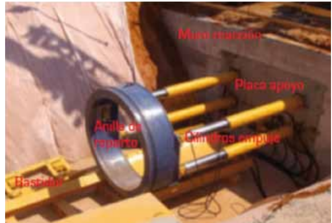
Fotografía 2. Equipo de empuje. Fuente: Conducciones y Vías
