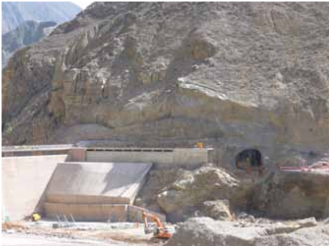
Fig. 7. Portal de salida del túnel transferencia, a la presa de Checras
