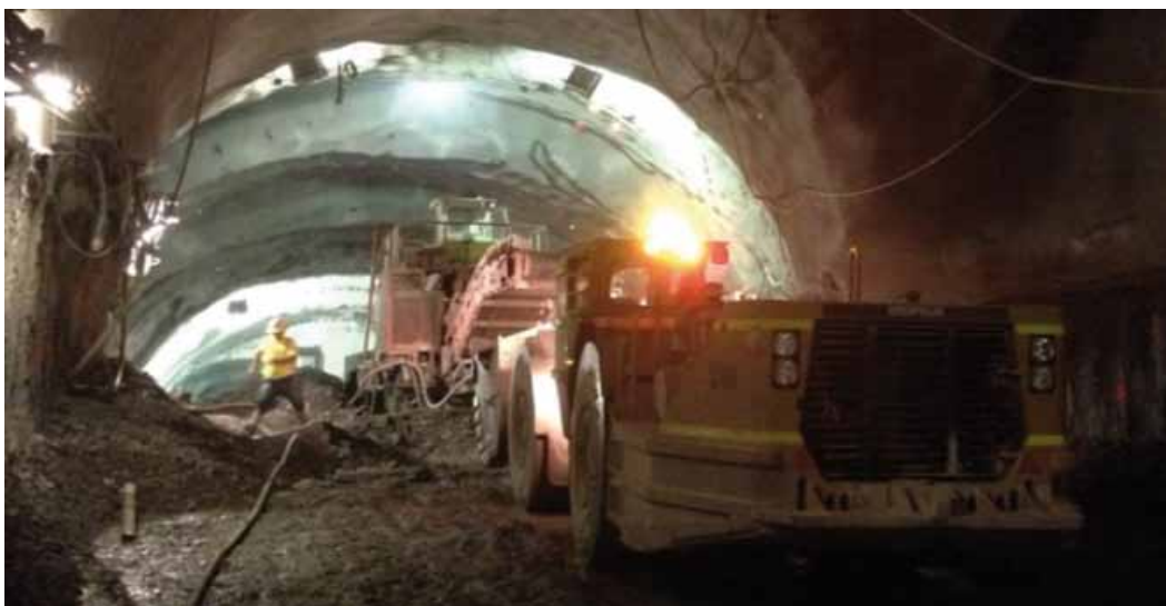
Foto 8. Equipos de excavación y desescombro
