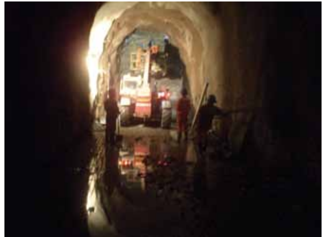
Fig. 8. Vista interior del túnel transferencia, durante su construcción
