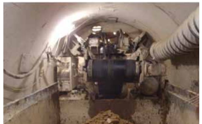
Foto 5. Cinta vertiendo en la vagoneta.
