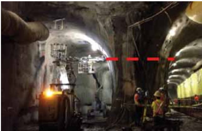
Fotos 2 y 3. Ejecución de galerías inferiores, impermeabilización y perforación de orificios para tirantes
