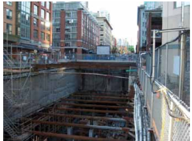
Foto 1. Estación en Canada Line (Vancouver)
