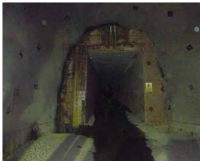
Fig. 21. Vista del tapón una vez construido
