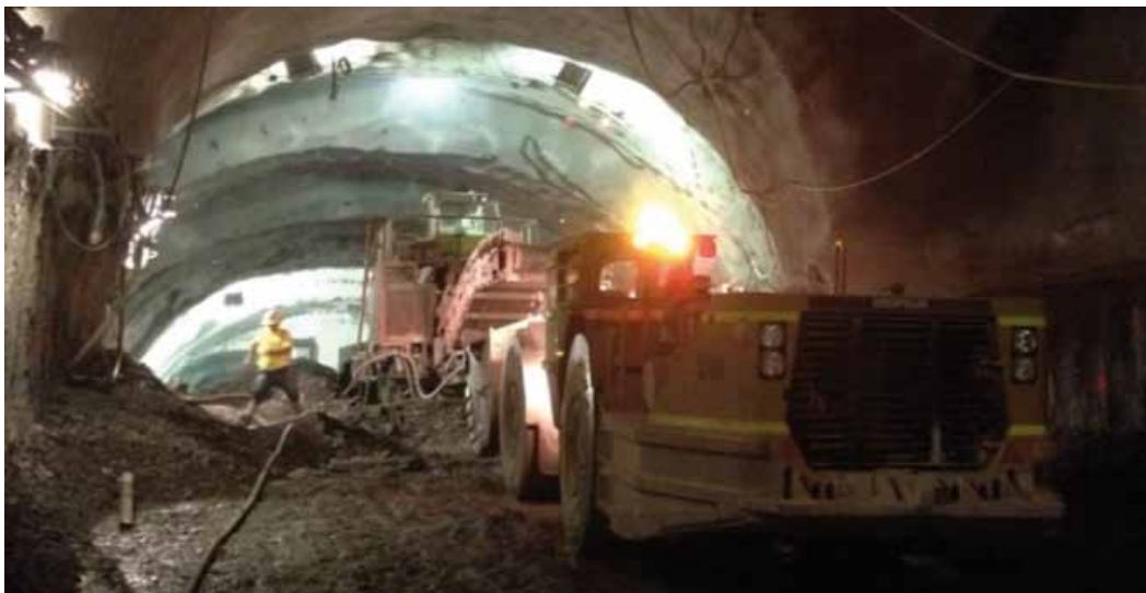
Foto 8. Equipos de excavación y desescombro
