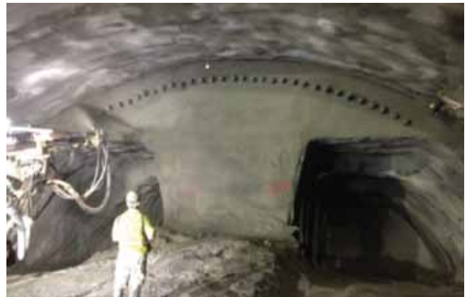
Fotos 4 y 5. Tirantes conectados al revestimiento y relleno de galería inferior (arriba). Excavación de galerías laterales superiores (abajo)
