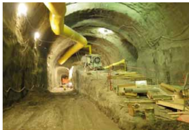
Fotos 9 y 10. Excavación de cavernas en avance y destroza en zonas no sensibles (izda.) y mediante sistema de control de cargas mediante tirantes en zonas sensibles (dcha.)
