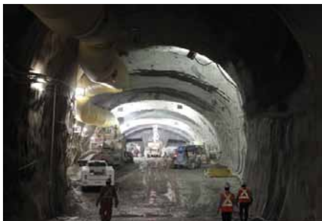
Fotos 9 y 10. Excavación de cavernas en avance y destroza en zonas no sensibles (izda.) y mediante sistema de control de cargas mediante tirantes en zonas sensibles (dcha.)
