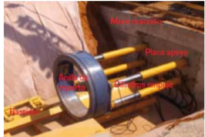
Fotografía 2. Equipo de empuje. Fuente: Conducciones y Vías
