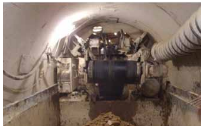
Foto 5. Cinta vertiendo en la vagoneta.
