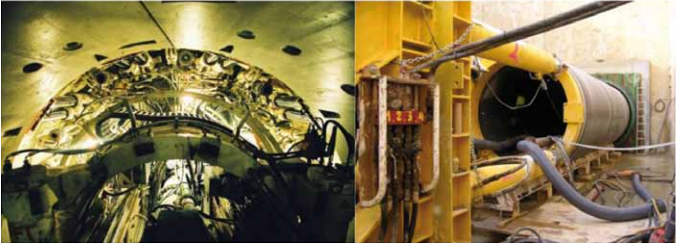
Foto 6. Cilindros de empuje apoyados sobre dovelas. Fuente: Tunneltalk.com
