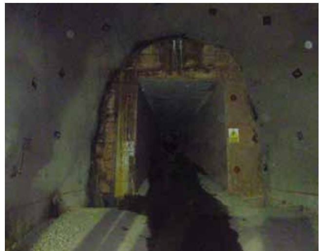
Fig. 21. Vista del tapón una vez construido
