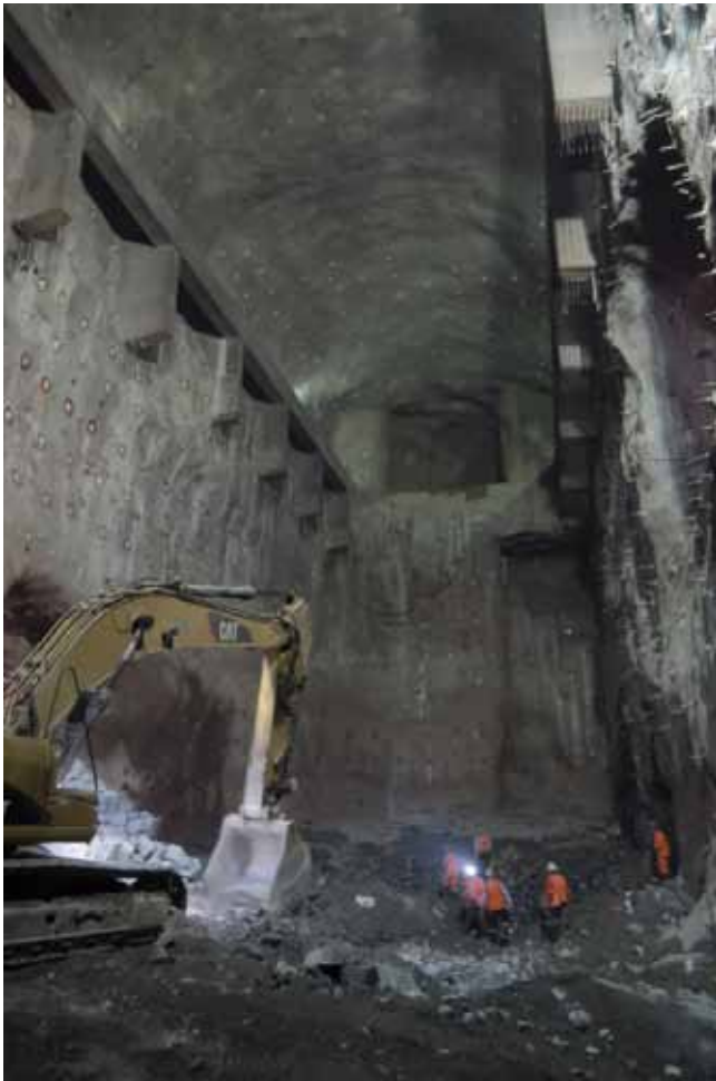
Fig. 17. Último banqueo de la caverna de Casa de Máquinas
