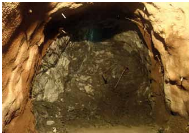
Fig. 11. Vista de uno de los ramales del bifurcador durante la construcción
