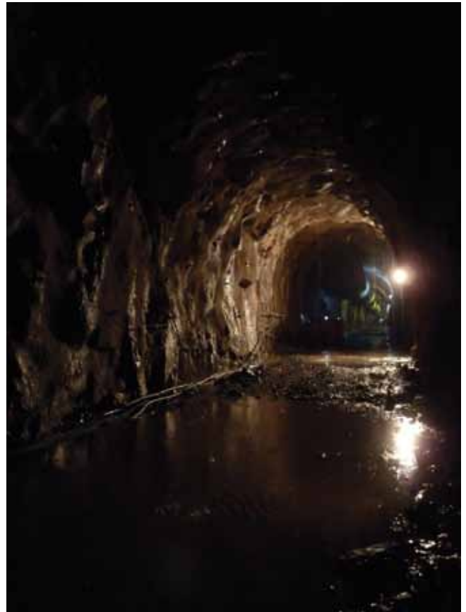
Fig. 19. Vista del túnel descarga una vez finalizada la excavación
