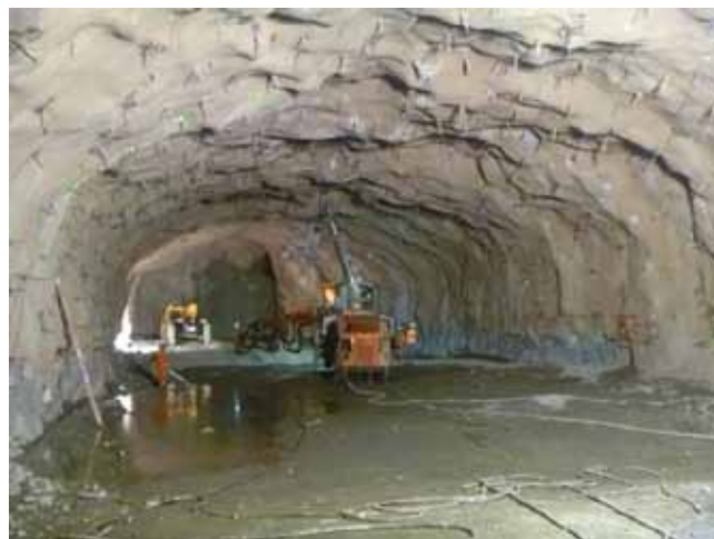
Fig. 16. Excavación de la calota de la caverna de Casa de Máquinas
