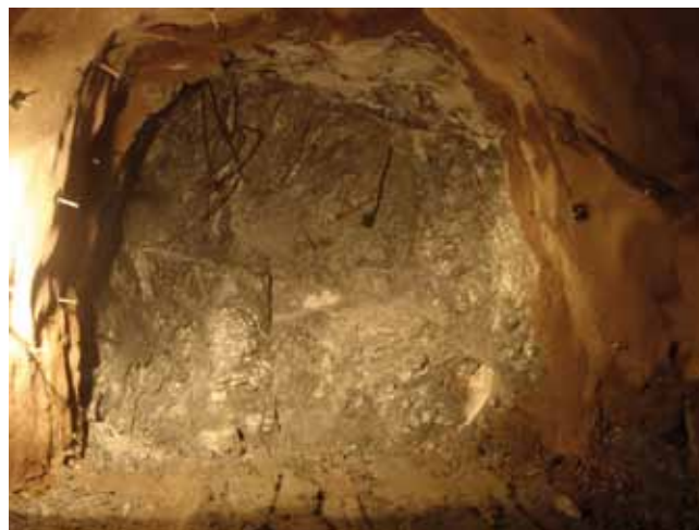
Fig. 10. Túnel conducción-Drive 9 (30 m² y 14 %)
