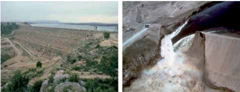
Fig. 7. Vista de la presa de Caspe USA (izquierda) ( www.seprems.es ). Vista de la presa de Teton en (USA), la cual fallo por tubificación (erosión interna) en la cortina (derecha): ( www.rinconabstracto.com )
