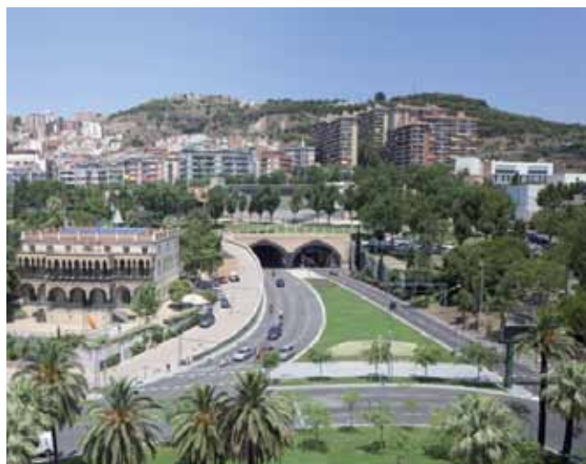
Túnel de La Rovira bajo la colina del Guinardó (Barcelona)
