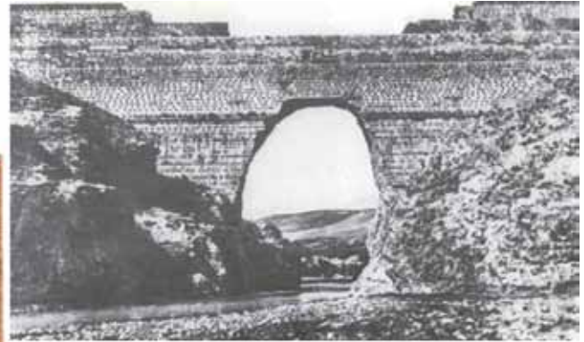
Fig. 4. Falla por sifonamiento mecánico en taludes (izquierda). Vista de la segunda presa de Puentes, después de su rotura, desde aguas abajo. https://www.chsegura.es/chs/cuenca/infraestructuras/embalses/embalsedePuentes/antecedentes.html
