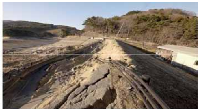
Fig. 3. Vistas del deslizamiento del talud aguas arriba en la Presa de Fujinuma por efecto de un sismo, Tohoku el 12 de marzo de 2011. Fujinuma – Ike, colapsando el terraplén de cierre. (Carmona, Juan S., 2011)
