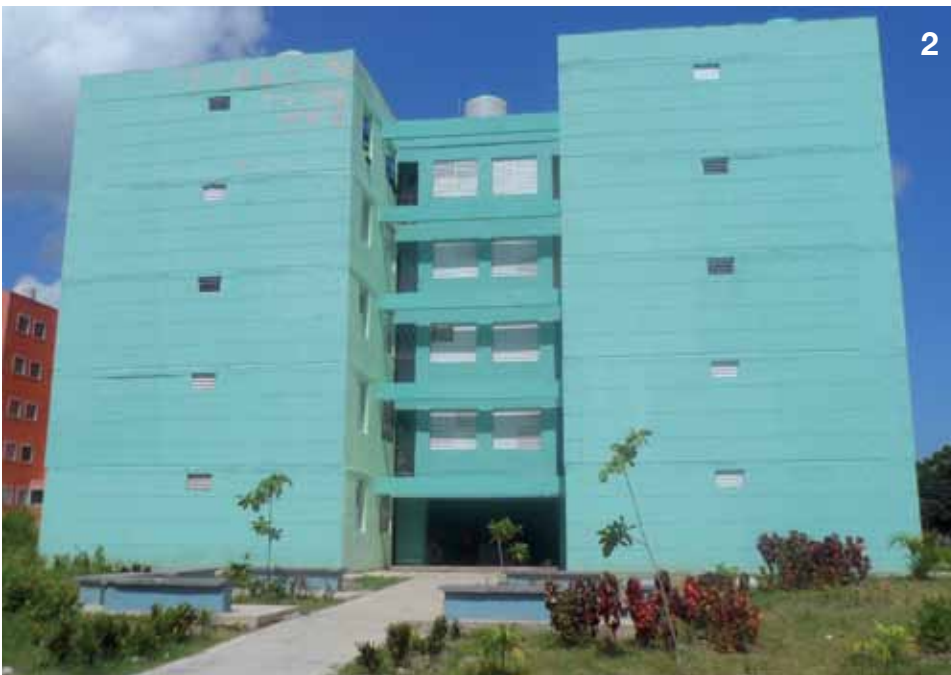
2. Edificio FORSA, soluciones de hormigón armado fundido in situ con el empleo de moldes metálicos. Fuente: fotos tomadas por las autoras
