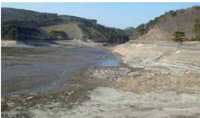
Fig. 3. Vistas del deslizamiento del talud aguas arriba en la Presa de Fujinuma por efecto de un sismo, Tohoku el 12 de marzo de 2011. Fujinuma – Ike, colapsando el terraplén de cierre. (Carmona, Juan S., 2011)
