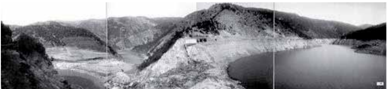
Fig. 12. Imagen sacada pocos días después del desastre en Molare por rebase de aliviadero que muestra los restos de la presa Sella Zerbino (www.eoi.es). Cruz, 2012
